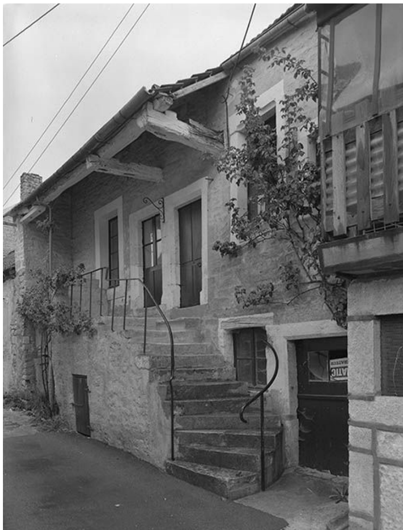
Façade principale avec escalier tournant à retour avec jour. 89, Cry
