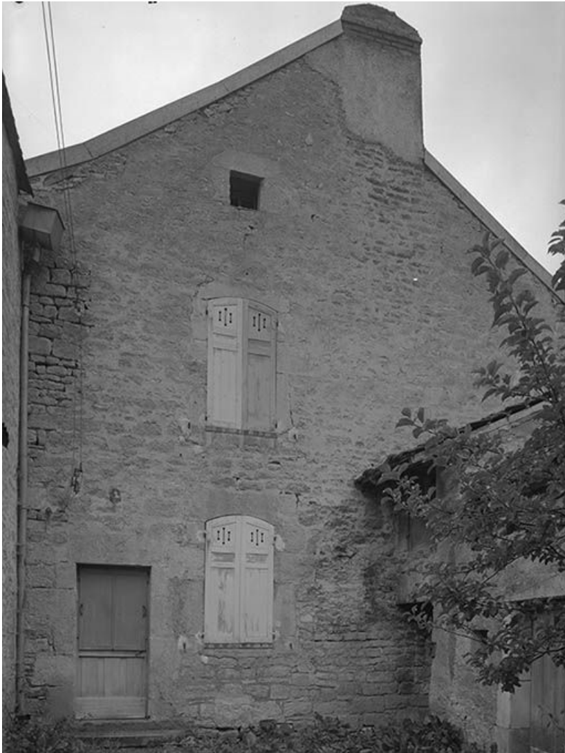
Mur-pignon sur l'impasse.
