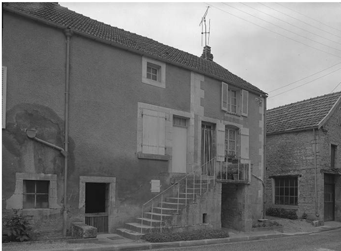
Façade en bordure de l'impasse.
