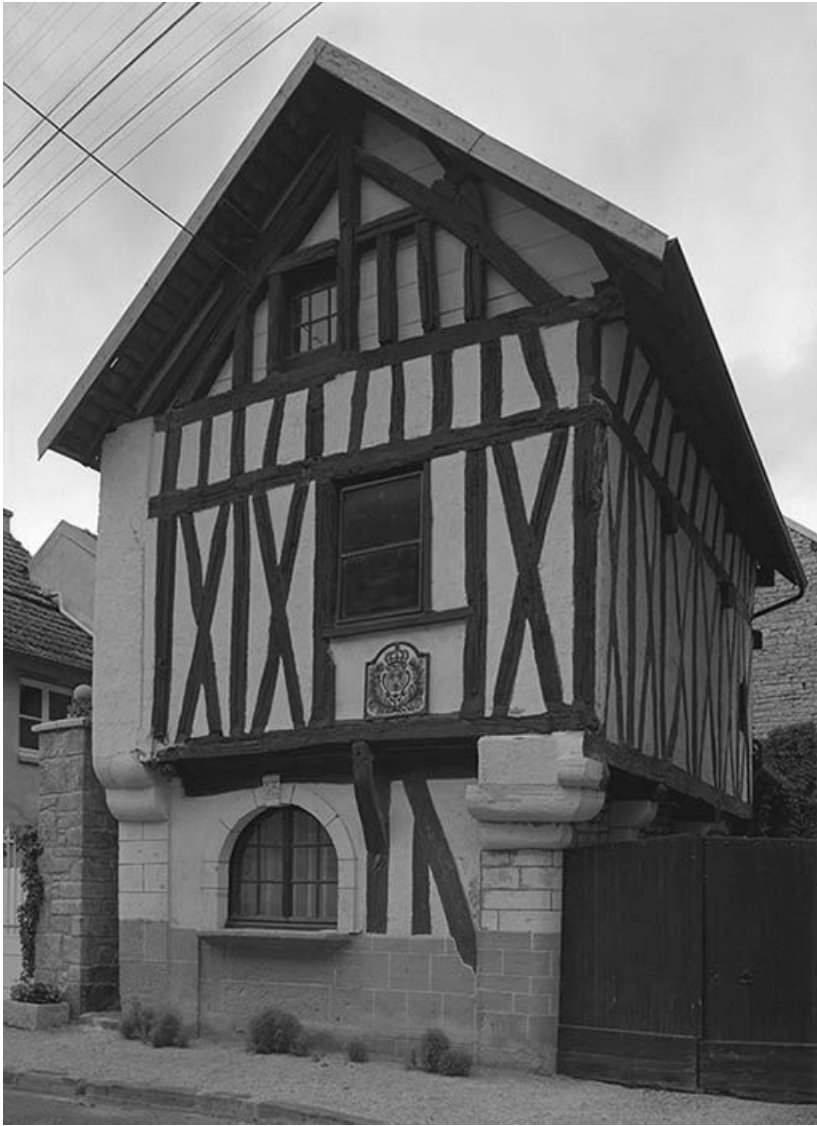
Mur-pignon sur rue. 89, Cry, 8 Grande-Rue
