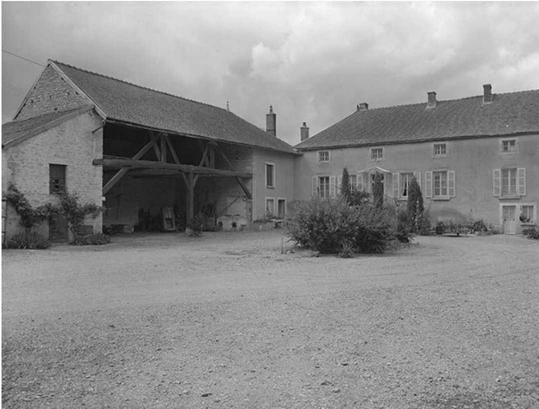
Granges, étables, fenil et logis. Façades sur cour.
