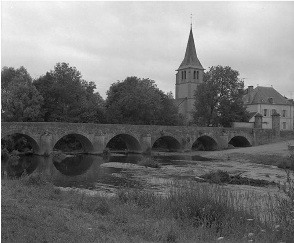
Pont sur l'Armançon (pont routier).
