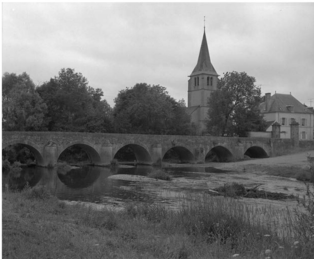
Pont sur l'Armançon (pont routier).
