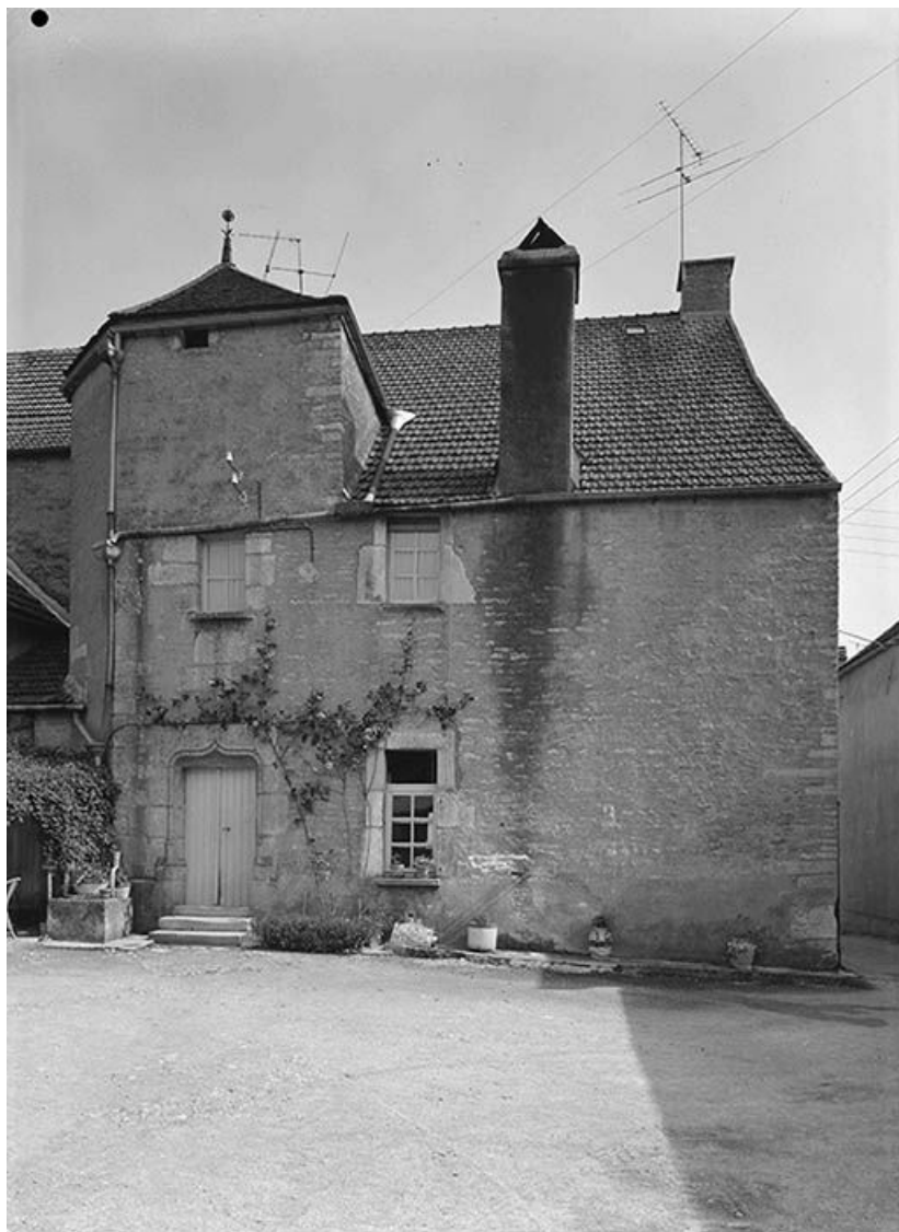
Maison enserrant une ancienne tour. Façade sur rue.
