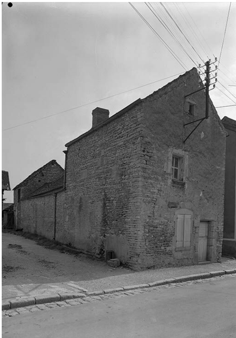
Façade latérale gauche aveugle et mur-pignon sur rue. 89, Chassignelles Grande-Rue
