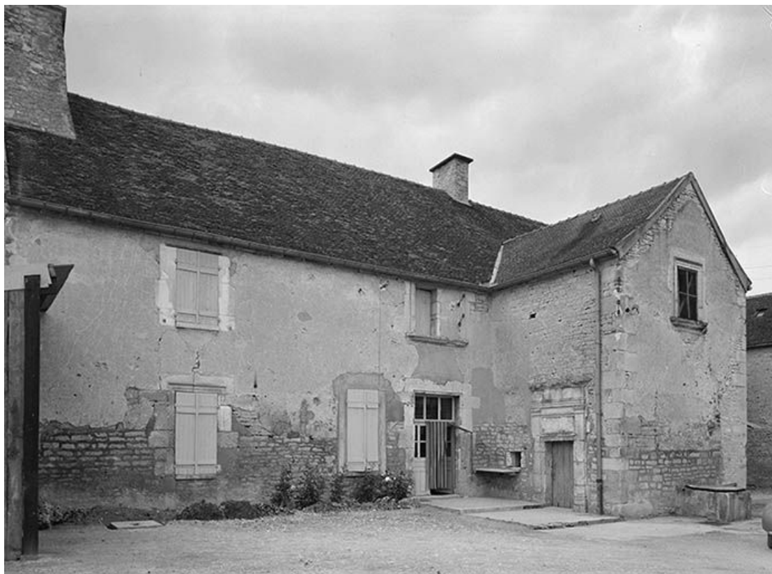
Corps de logis principal et petit corps en retour. Façades sur cour.
