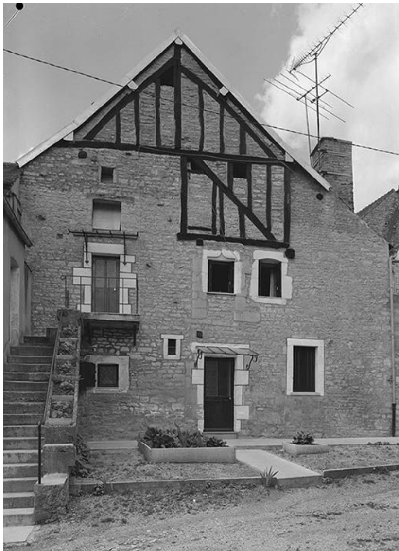
Escalier et mur-pignon sur rue.
