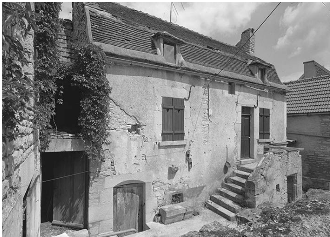
Façade sur rue. Sous-sol, rez-de-chaussée surélevé sur cellier (sous le palier de l'escalier). 89, Argentenay rue Serein
