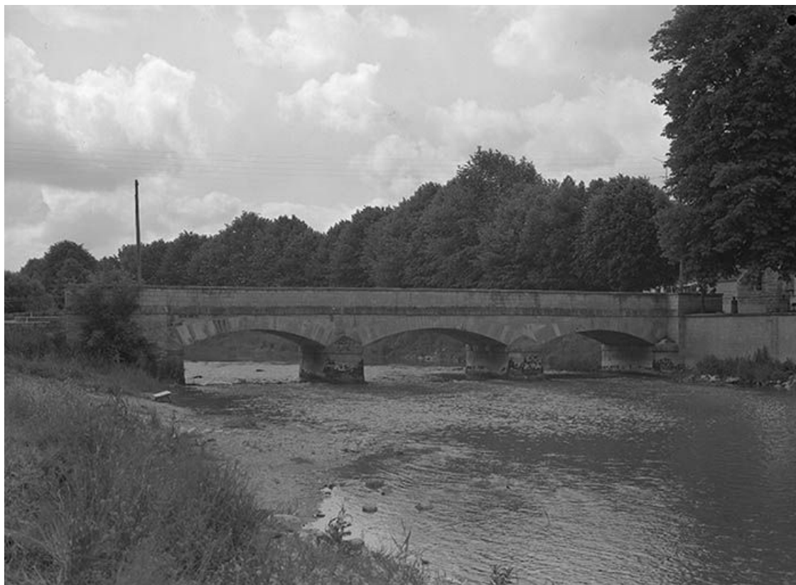
Pont sur l'Armançon (reconstruit en 1832). 89, Argenteau
