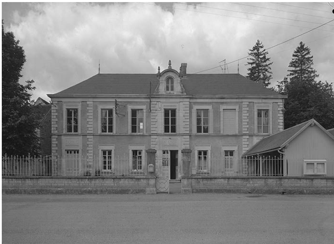
Portail sur rue, entrée de l'école à gauche de l'entrée de la mairie. 89, Argentenay rue Basse
