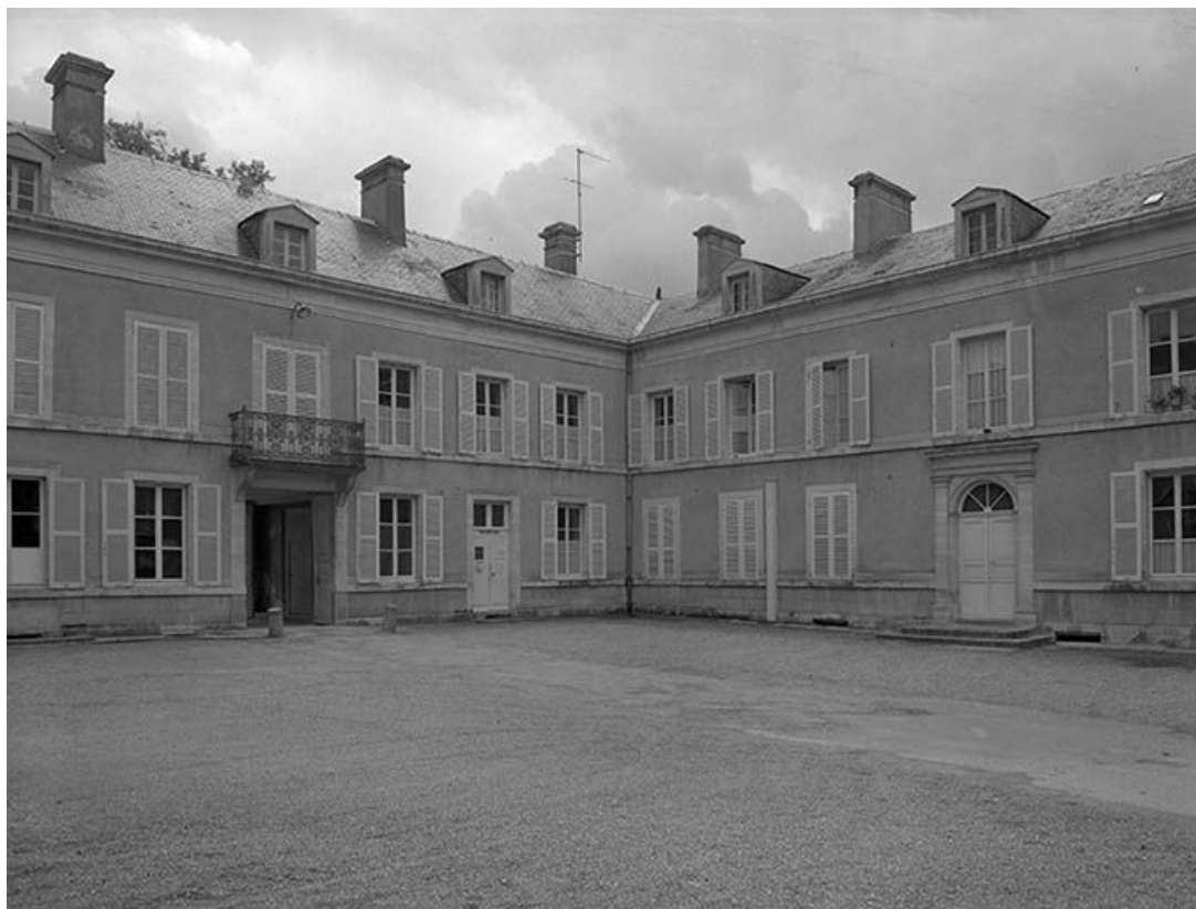
.Façades sur cour
