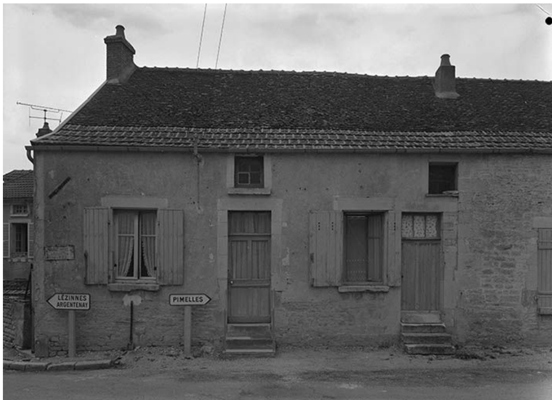
Maison sise parcelle AB 230, du cadastre de 1960 : vue d'ensemble. 89, Ancy-le-Libre C.D. 200
