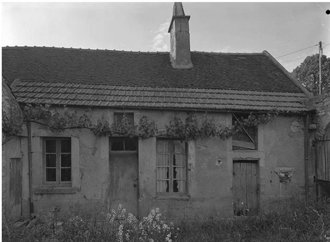
Maison sise parcelle AB 107, du cadastre de 1960 : vue d'ensemble. 89, Ancy-le-Libre Petite-Rue
