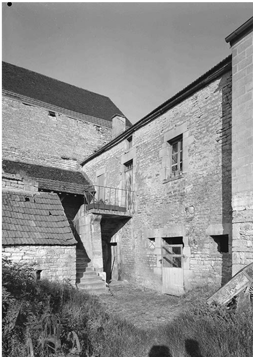
Maison sise parcelle AB 77, du cadastre de 1960 : façade sur cour.
