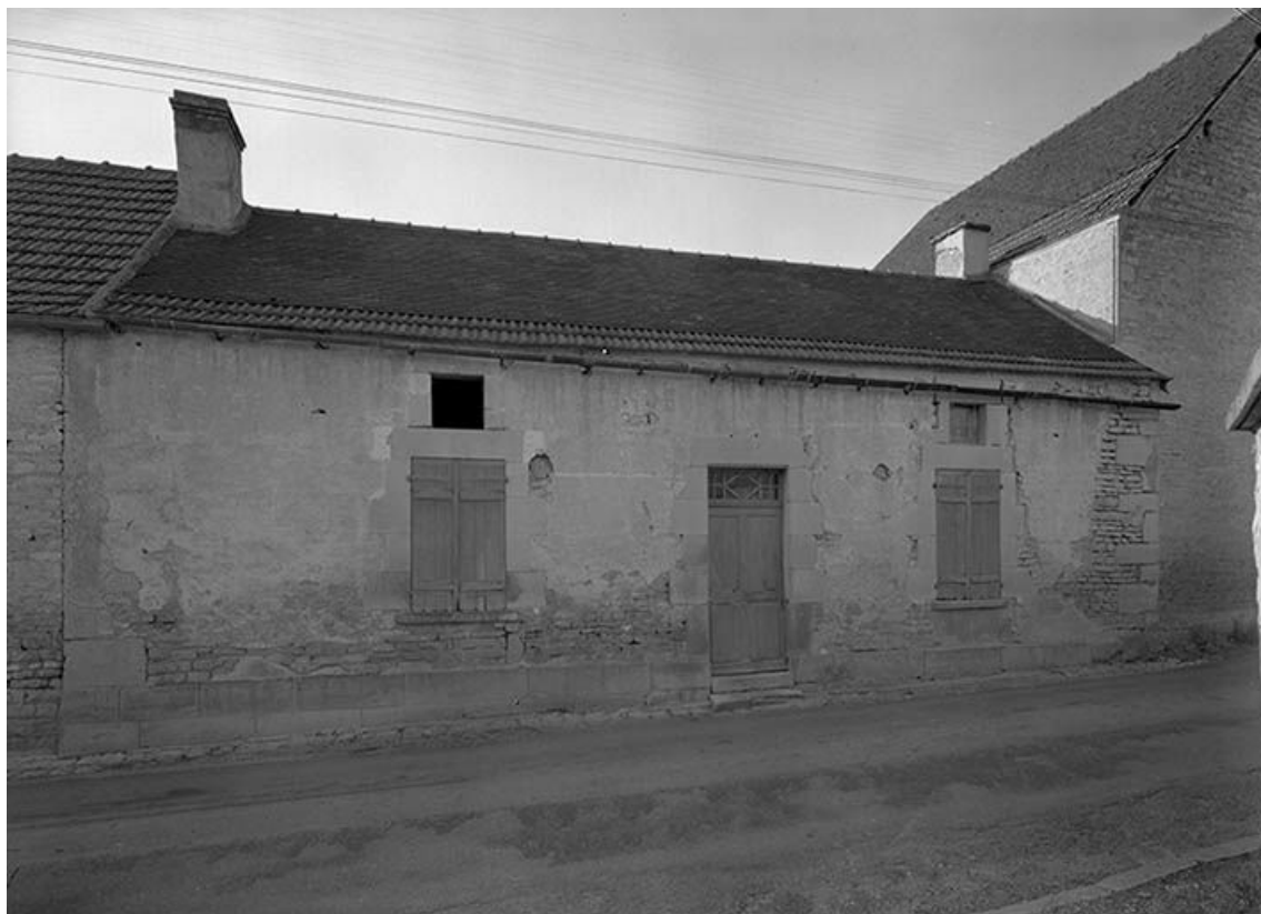
Maison sise parcelle AB 77, du cadastre de 1960 : façade sur rue.
