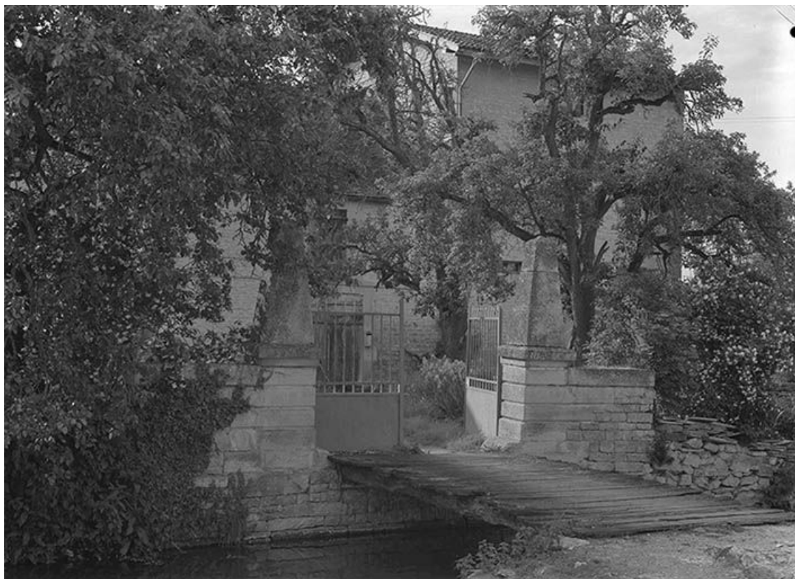
Ferme sise parcelles AB 29, 55, du cadastre de 1960 : vue d'ensemble sur rue. 89, Ancy-le-Libre rue Basse
