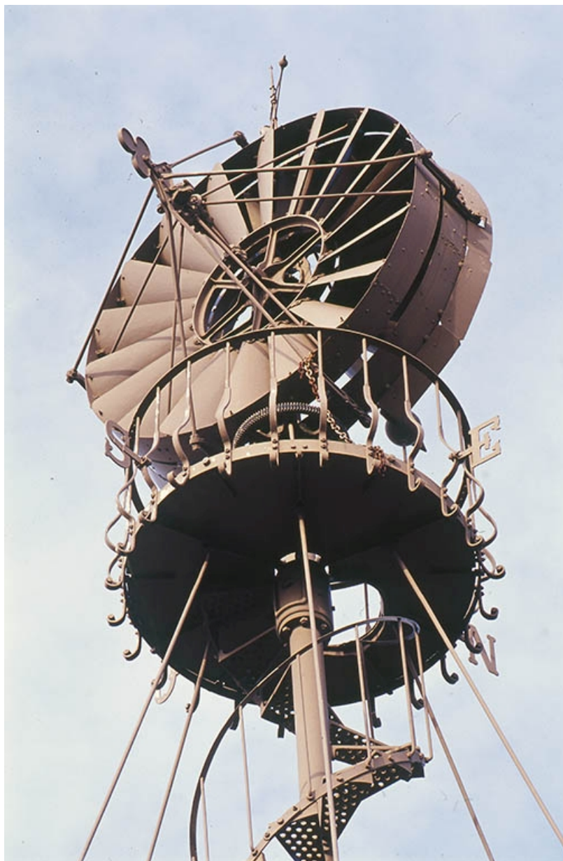
Détail de la partie supérieure, en contre-plongée.
