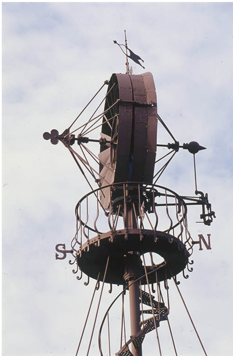
Détail de la partie supérieure. 89, La Postolle route de Courroy
