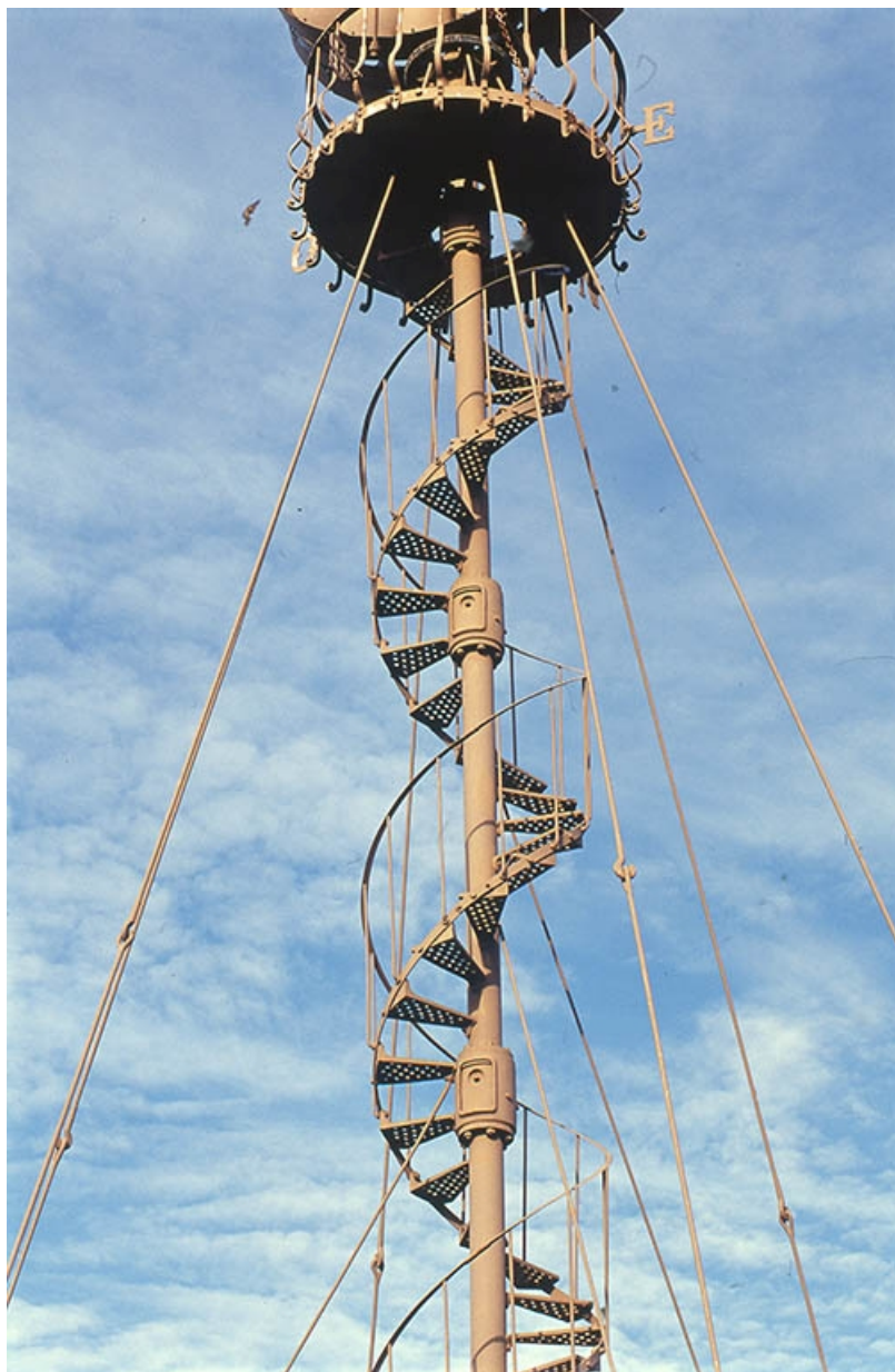
Détail de la colonne et de l'escalier.
