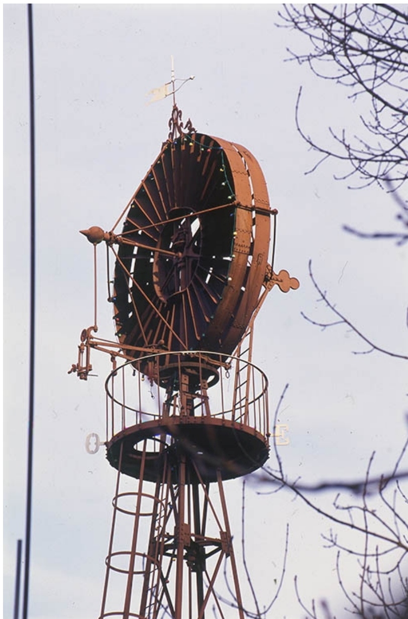
Détail : la passerelle sommitale et l'aéromoteur.
