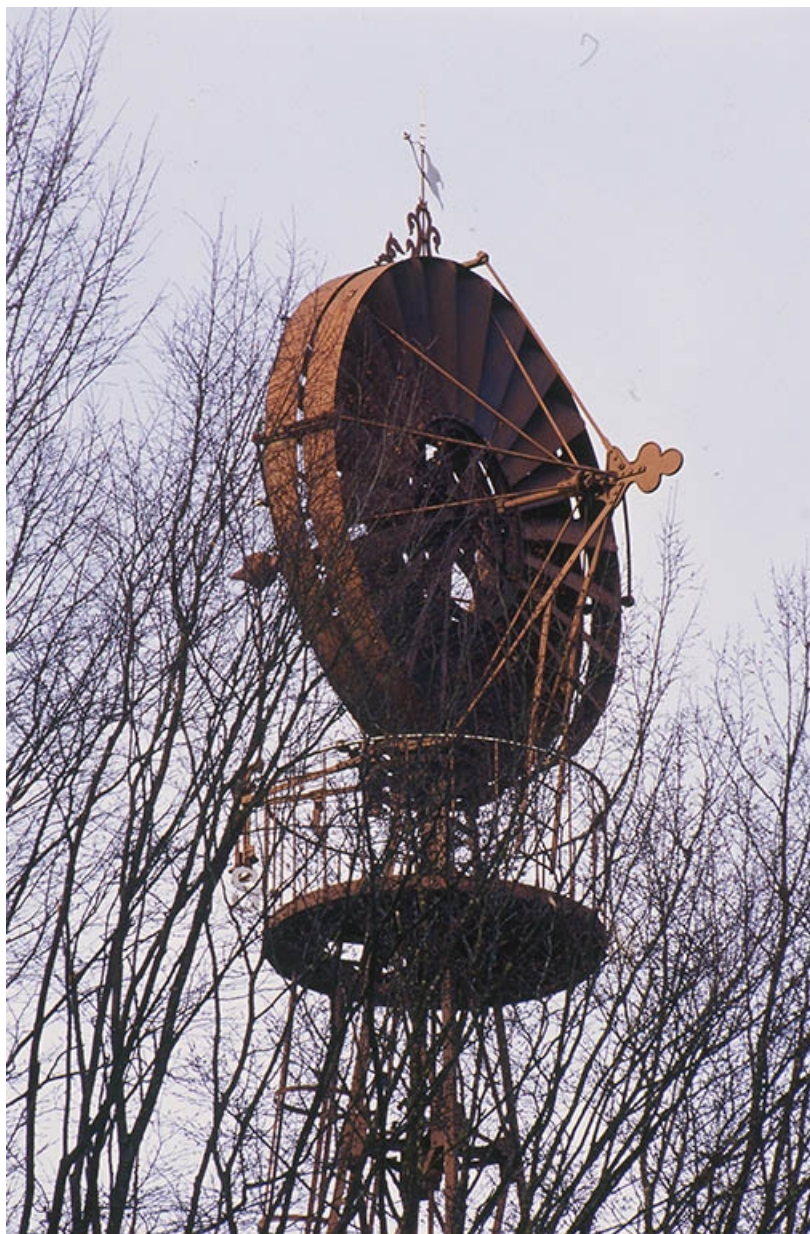
Détail : la passerelle sommitale et l'aéromoteur.
