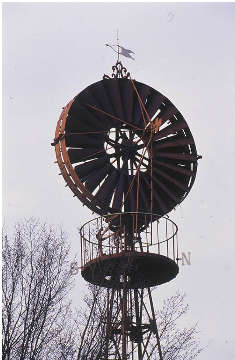
Détail : la passerelle sommitale et l'aéromoteur.
