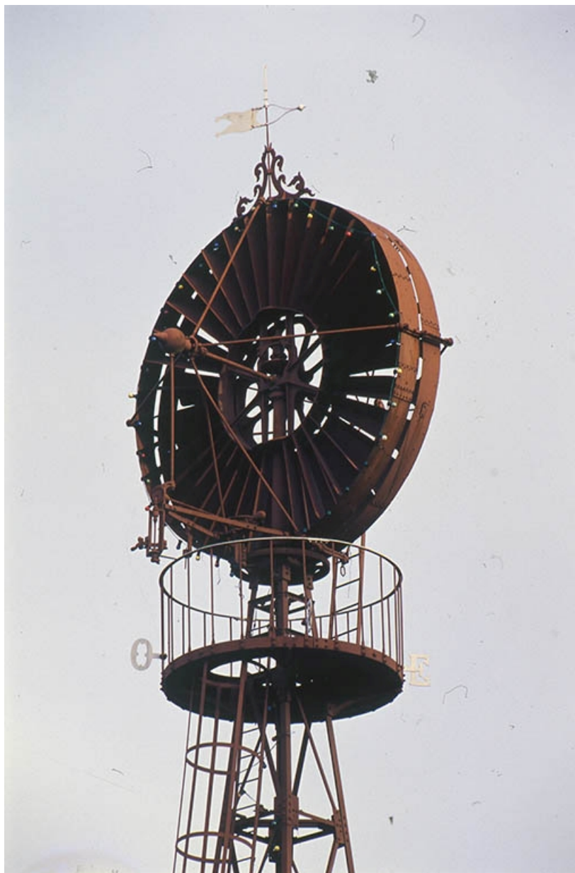
Détail : la passerelle sommitale et l'aéromoteur.
