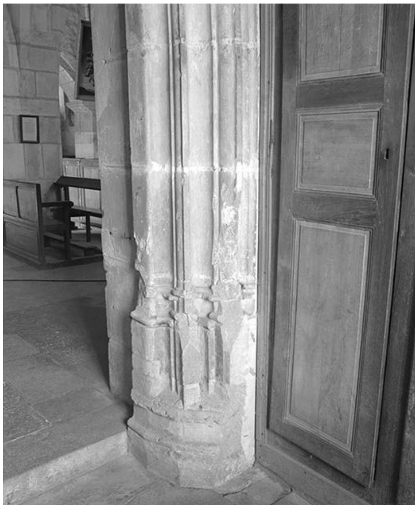
Porte du bas-côté droit : détail d'un piédroit.
