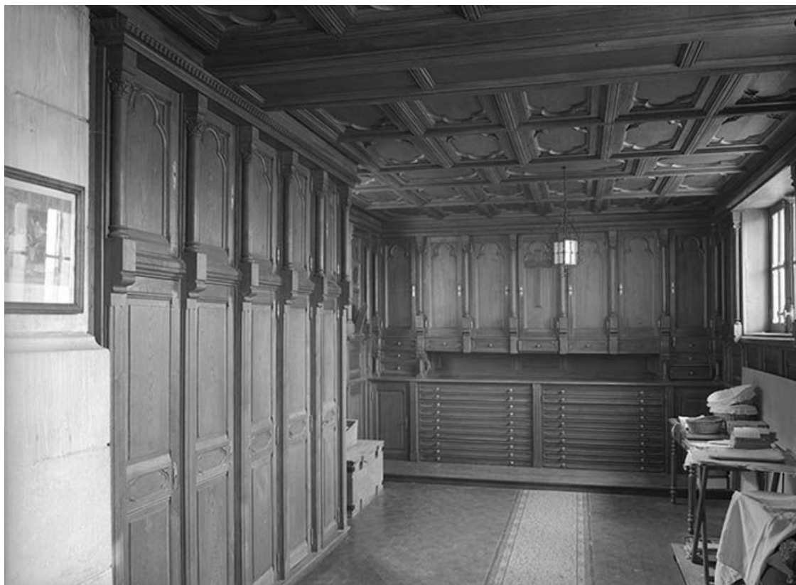
Sacristie depuis l'entrée.
