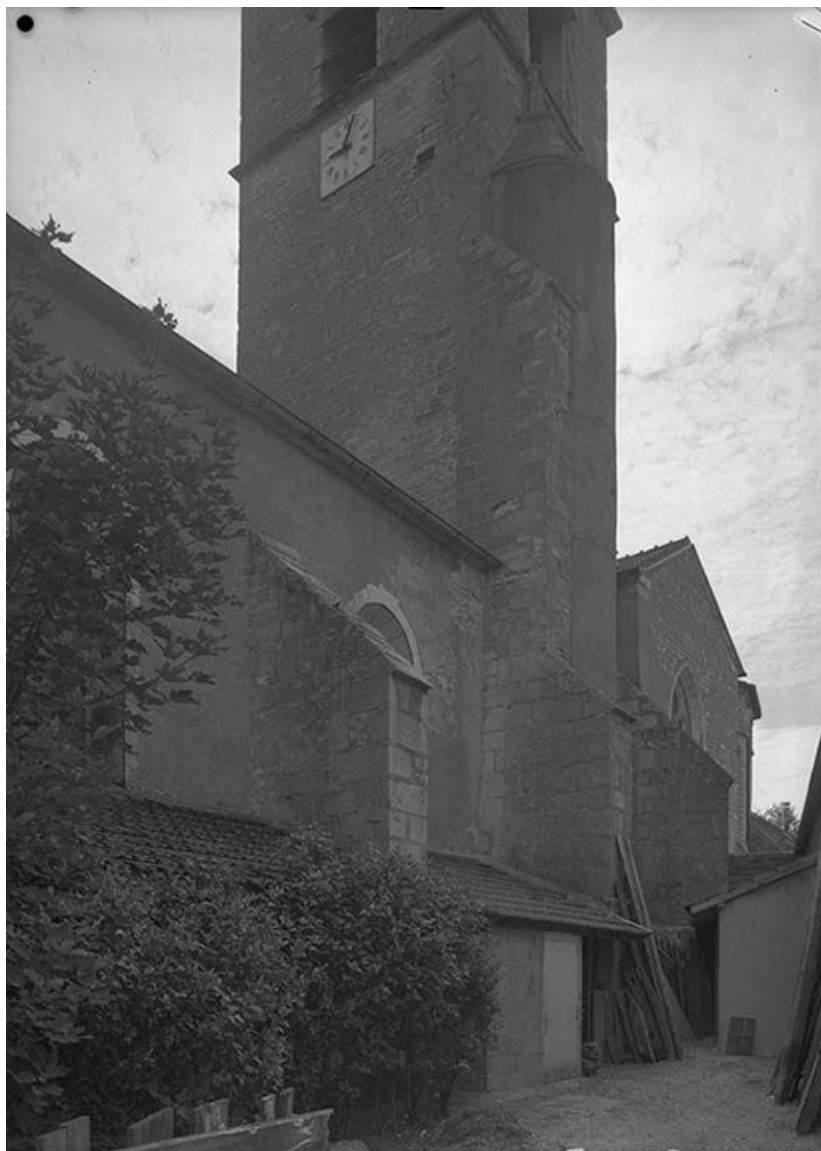
Façade latérale droite.
