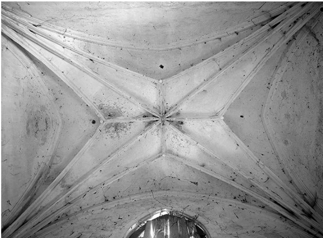
Vue d'ensemble de la voûte.
