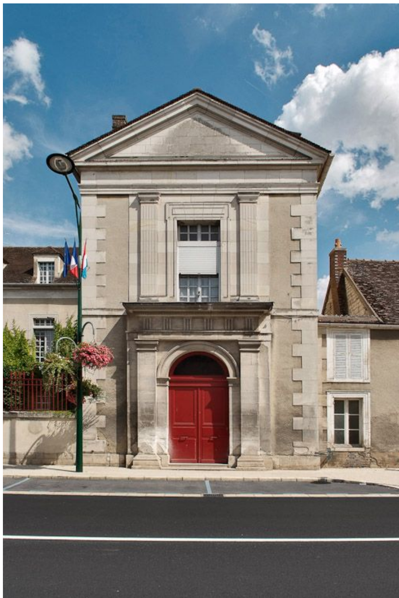
Bâtiment principal : mur de croupe de l'aile droite.
