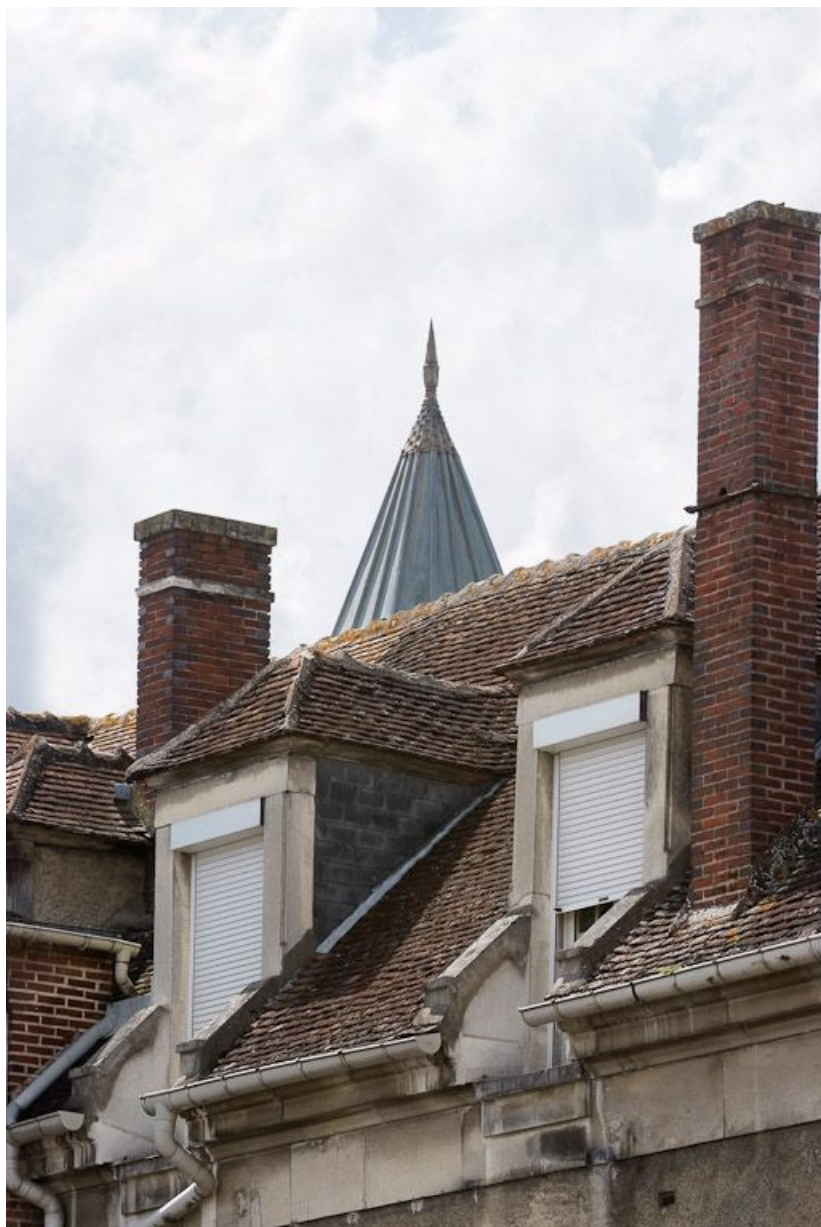
Bâtiment principal : détail des lucarnes rentrantes.
