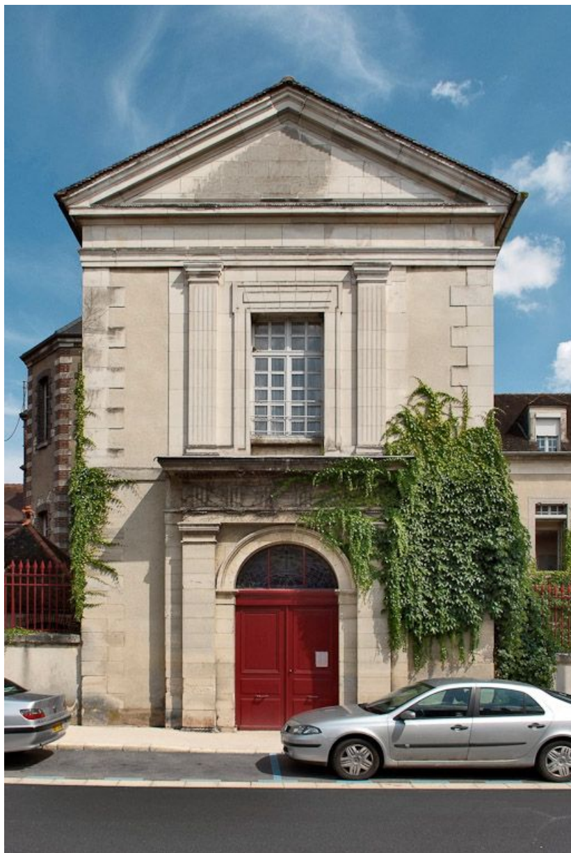
Bâtiment principal : mur de croupe de l'aile gauche.
