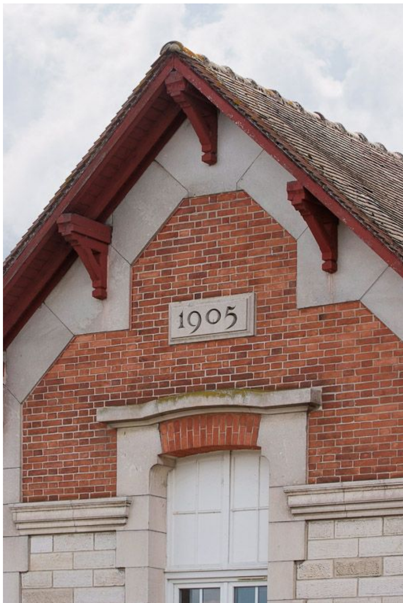
Bâtiment à gauche de l'entrée de la cour : détail du pignon. 89, Joigny quai de l'Hôpital
