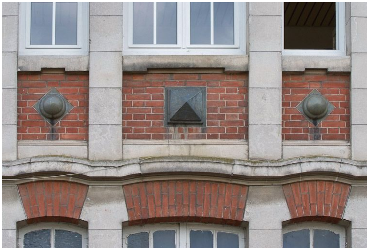
Bâtiment à droite de l'entrée de la cour : détail.
