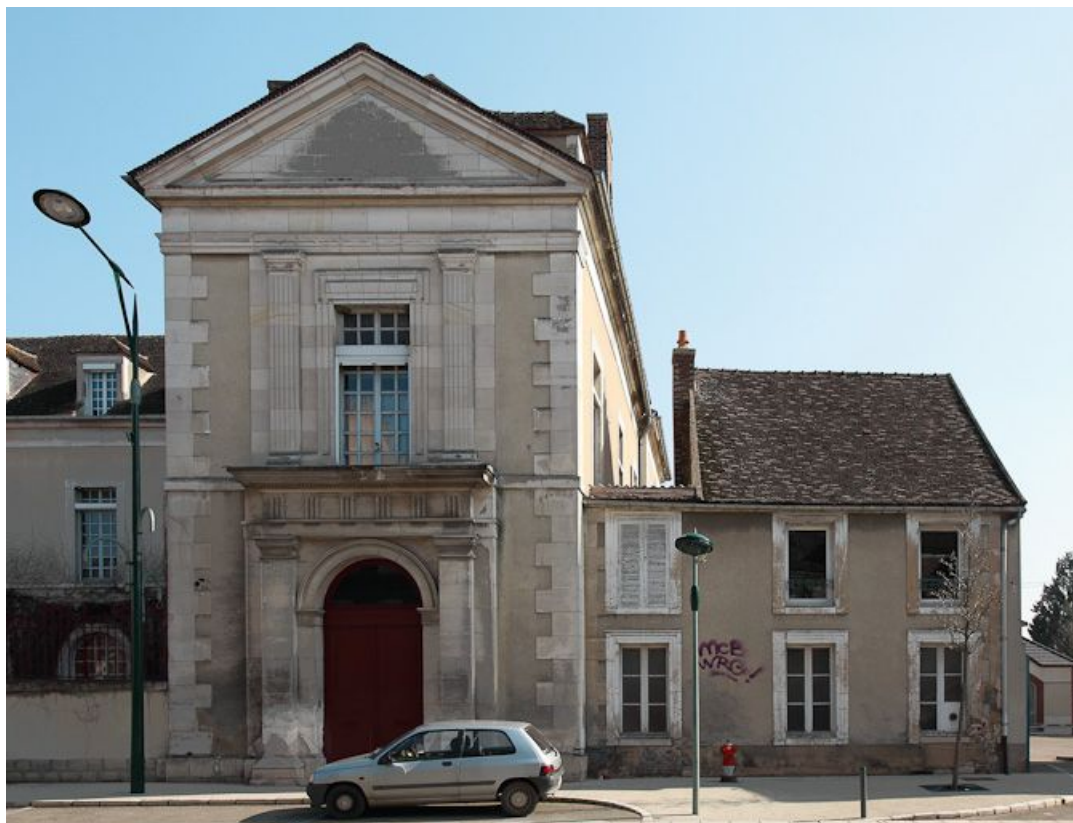
Bâtiment principal : mur de croupe de l'aile droite et bâtiment contigu. 89, Joigny quai de l'Hôpital
