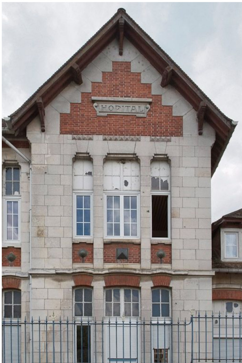
Bâtiment à droite de l'entrée de la cour : mur-pignon.
