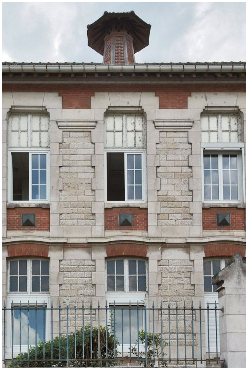
Bâtiment à droite de l'entrée de la cour : détail de l'élévation sur le quai. 89, Joigny quai de l'Hôpital
