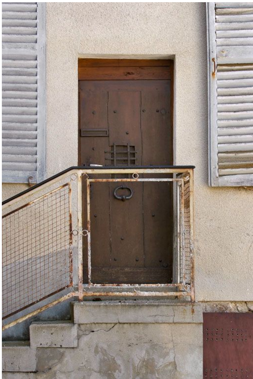
Porte d'origine de l'immeuble nord, remployée sur le bâtiment sud-ouest. 89, Seignelay, 2 rue du Docteur Chauvelot
