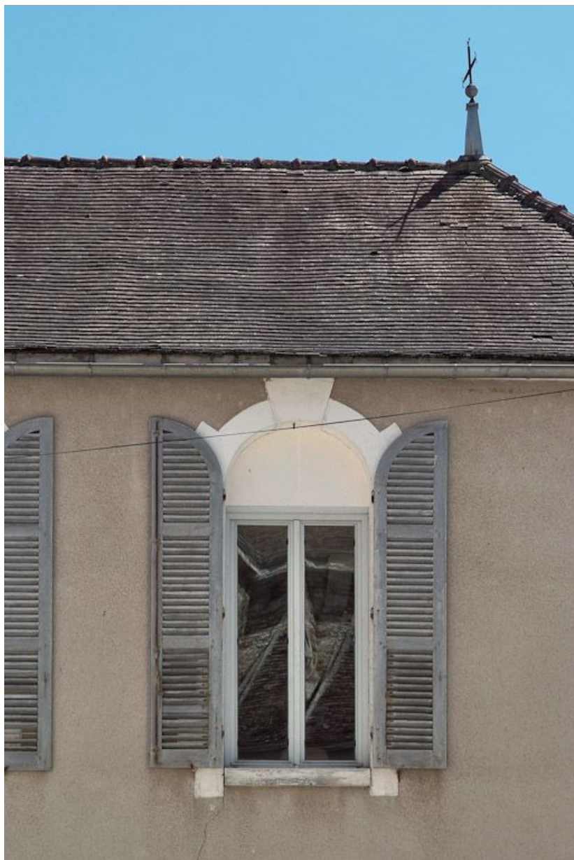
Corps de bâtiment est, ancienne fenêtre de la chapelle.
