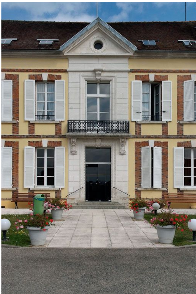
Travée centrale de la façade du bâtiment principal.
