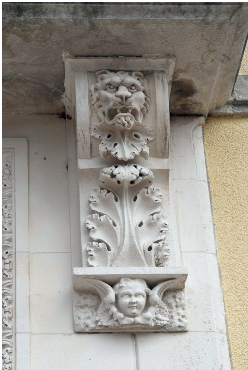
Bâtiment principal : console du balcon. 89, Saint-Julien-du-Sault, 2 avenue Wilson
