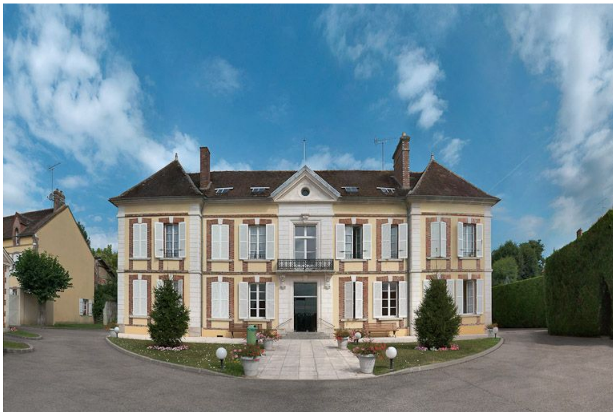
Vue d'ensemble : façade du bâtiment principal.
