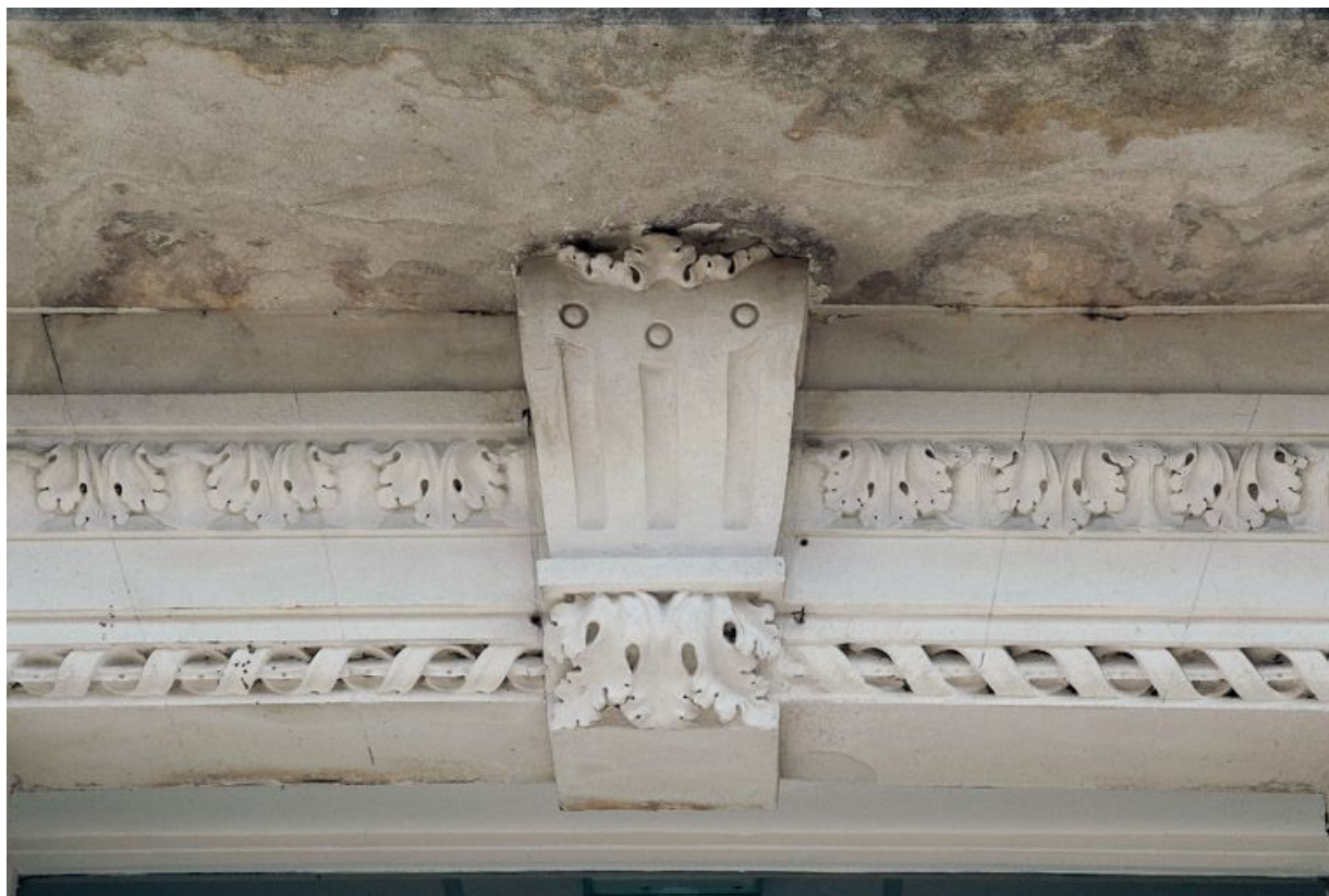
Bâtiment principal : agrafe de la porte d'entrée.
