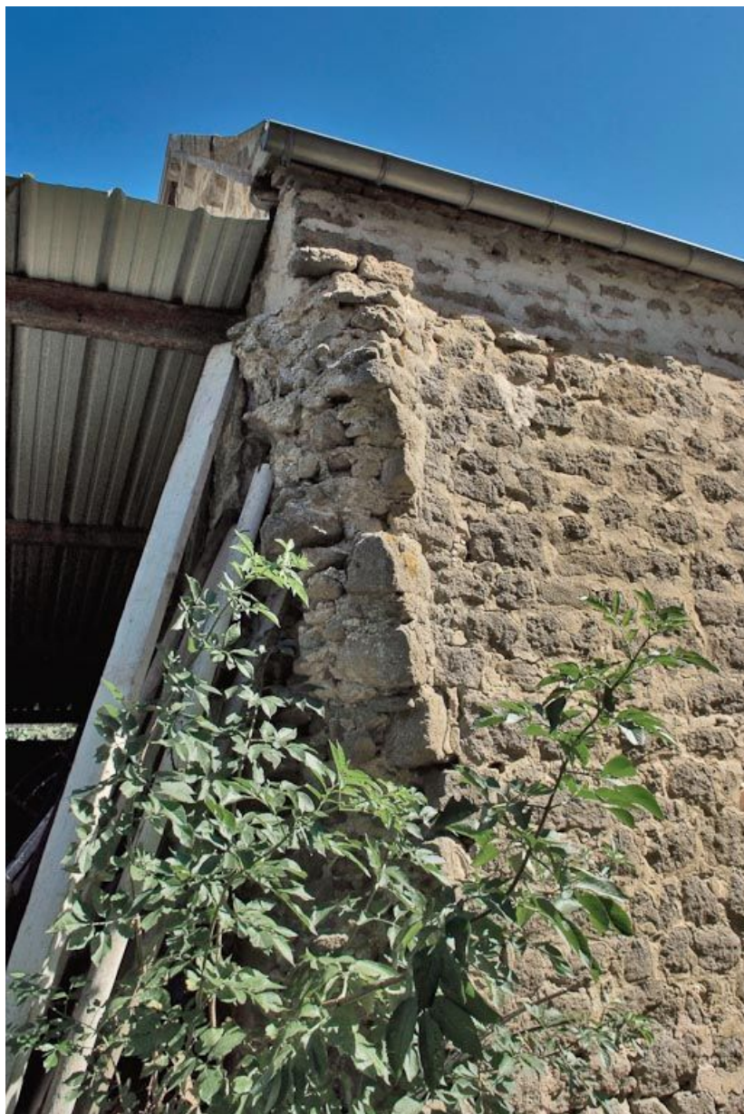
Chapelle : contrefort sur cour du mur-pignon est.
