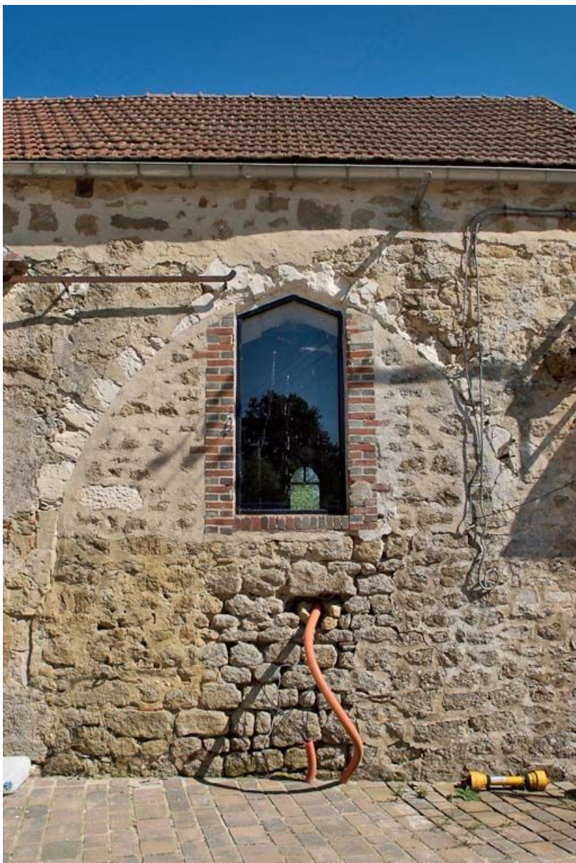
Chapelle : arcade en partie murée du mur de long-pan sur cour. 89, Saint-Florentin, lieudit : la Maladrerie
