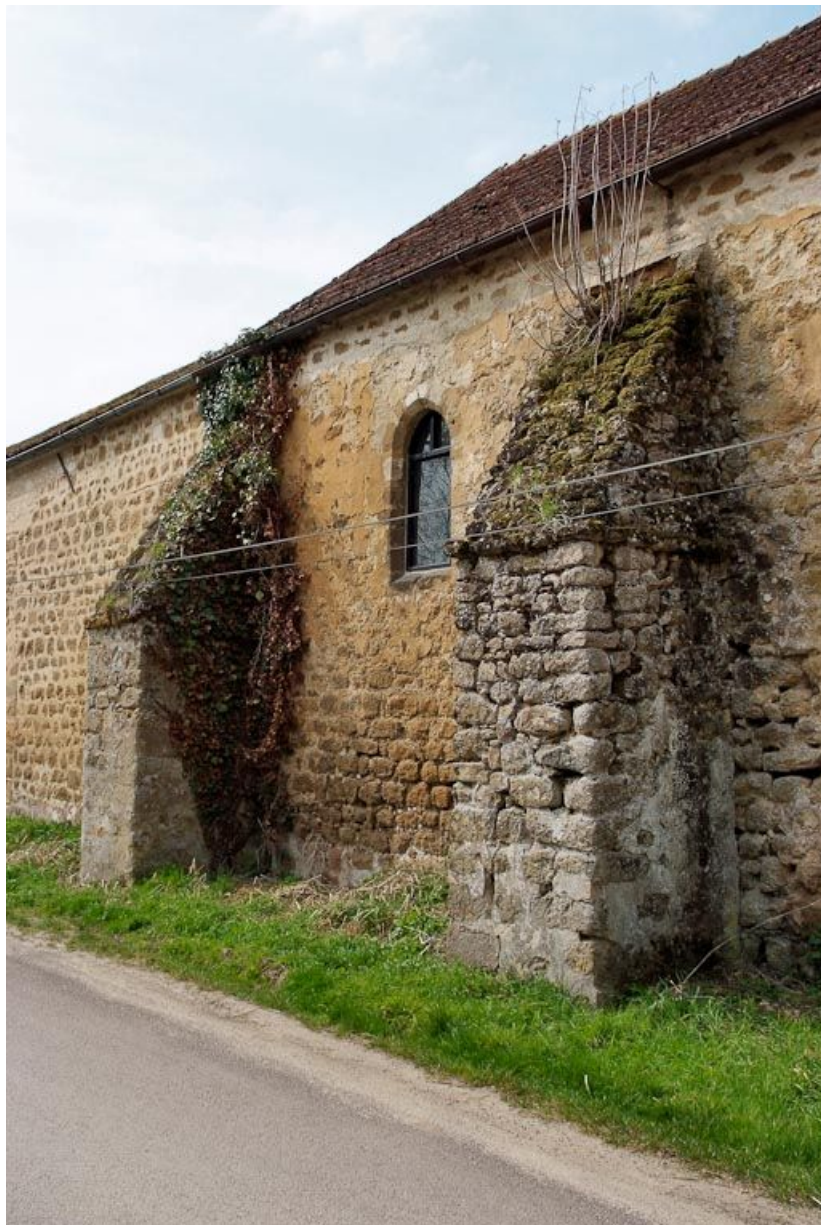
Chapelle : fenêtre entre le premier et le deuxième contrefort du mur de long-pan sur rue. 89, Saint-Florentin, lieudit : la Maladrerie
