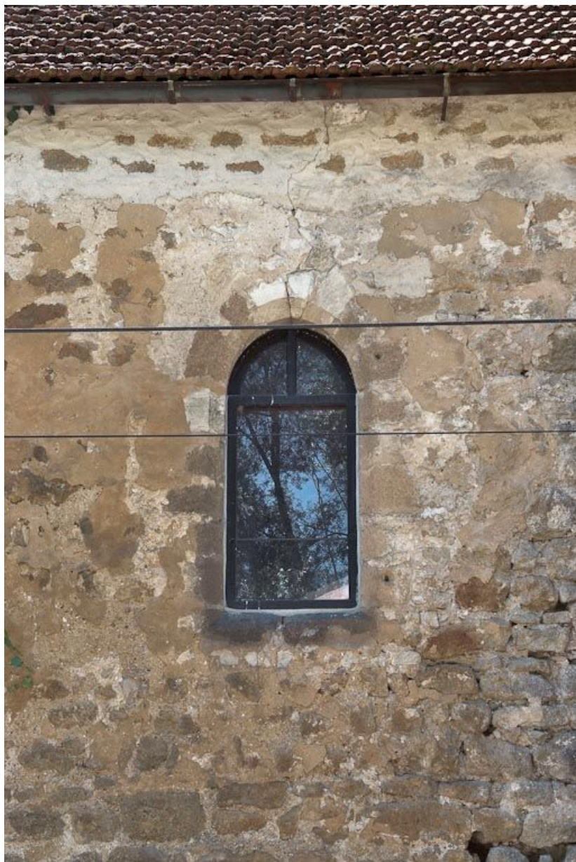
Chapelle : fenêtre en plein-cintre du mur de long-pan sur rue.
