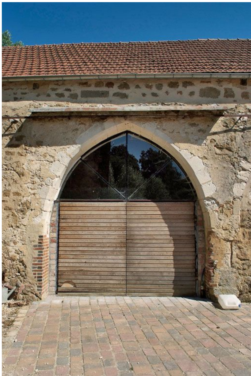
Chapelle : arcade transformée en porte du mur de long-pan sur cour. 89, Saint-Florentin, lieudit : la Maladrerie
