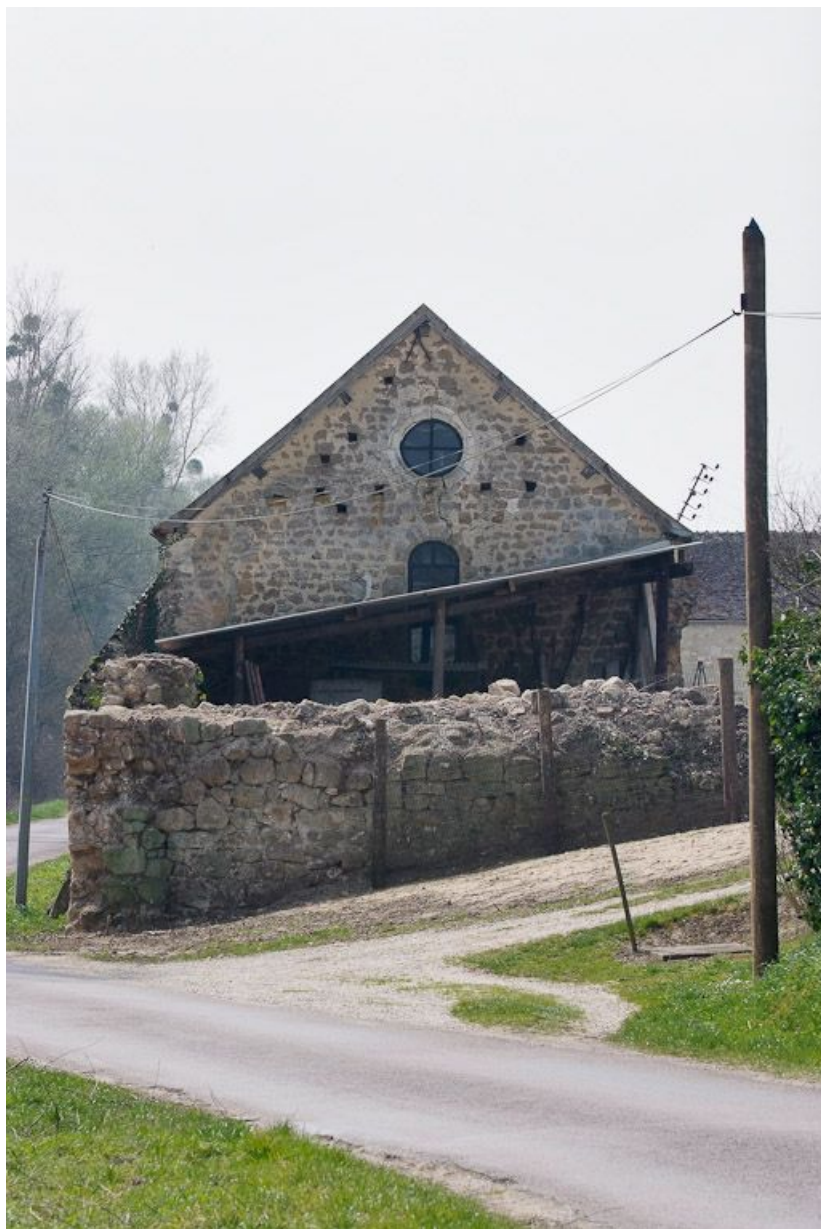
Chapelle : mur-pignon est, vue prise de la rue. 89, Saint-Florentin, lieudit : la Maladrerie
