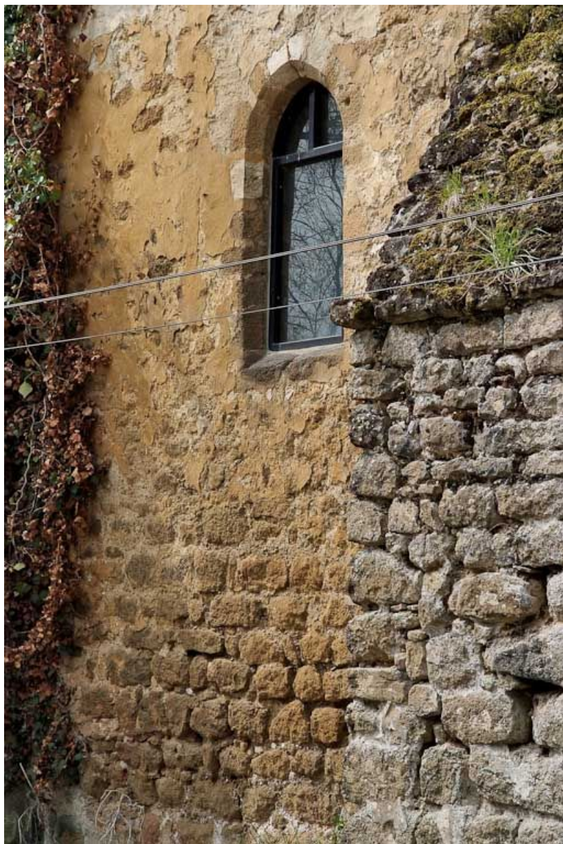
Chapelle : première fenêtre du mur de long-pan sur rue.
