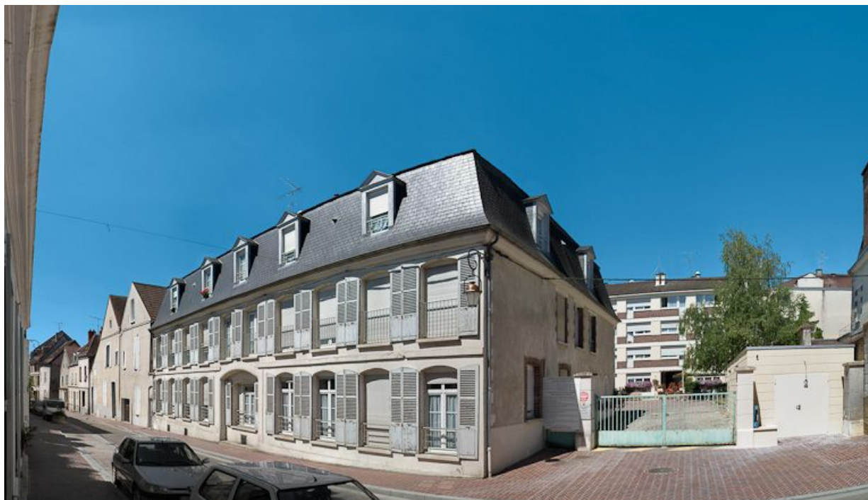
Vue d'ensemble depuis la Grande Rue. 89, Saint-Florentin, 31 avenue Général Leclerc
