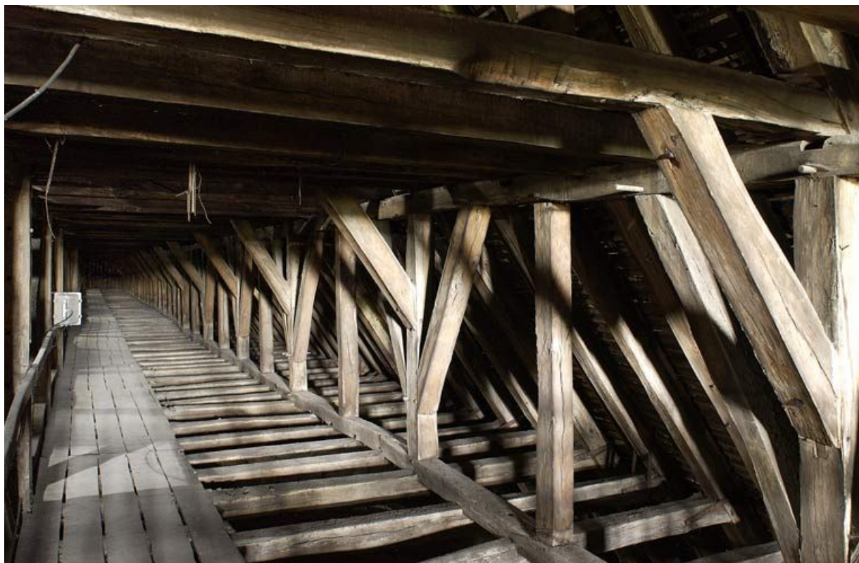
Charpente de l'ancienne salle des malades. 89, Tonnerre Hôpital
