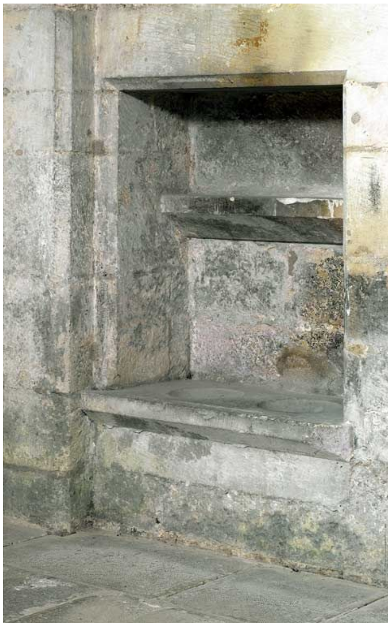
Lavabo de la chapelle latérale nord.
