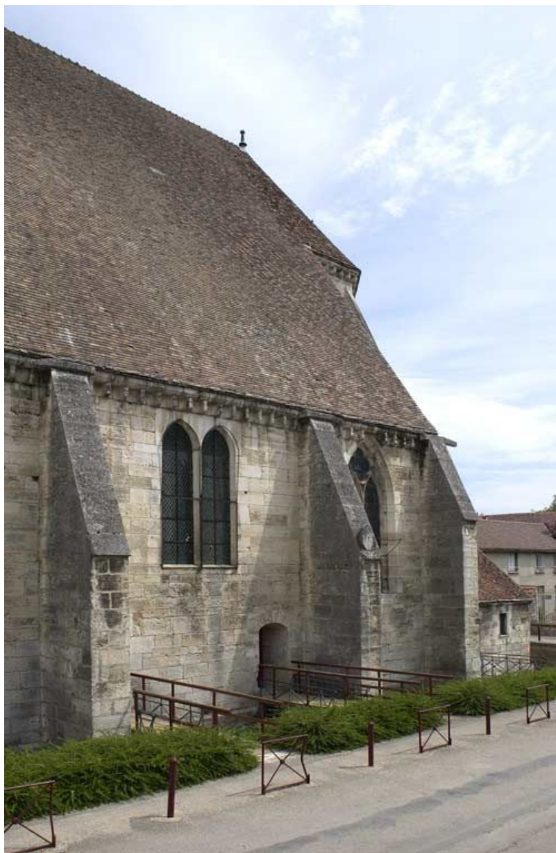
Mur gouttereau sud, chœur et chapelle du revestiaire. 89, Tonnerre Hôpital
