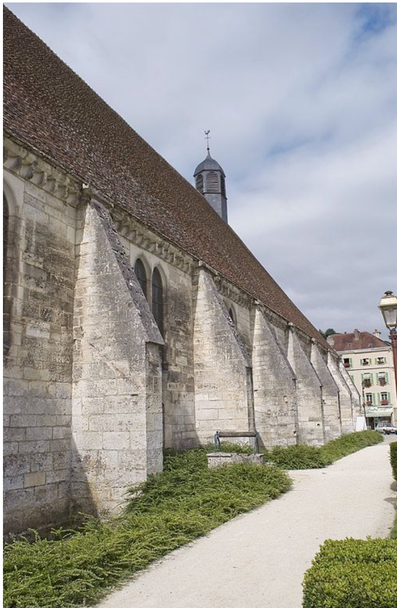
Vue des contreforts de la façade nord.
