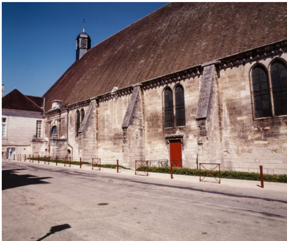
Élévation sud, vue partielle. 89, Tonnerre Hôpital
