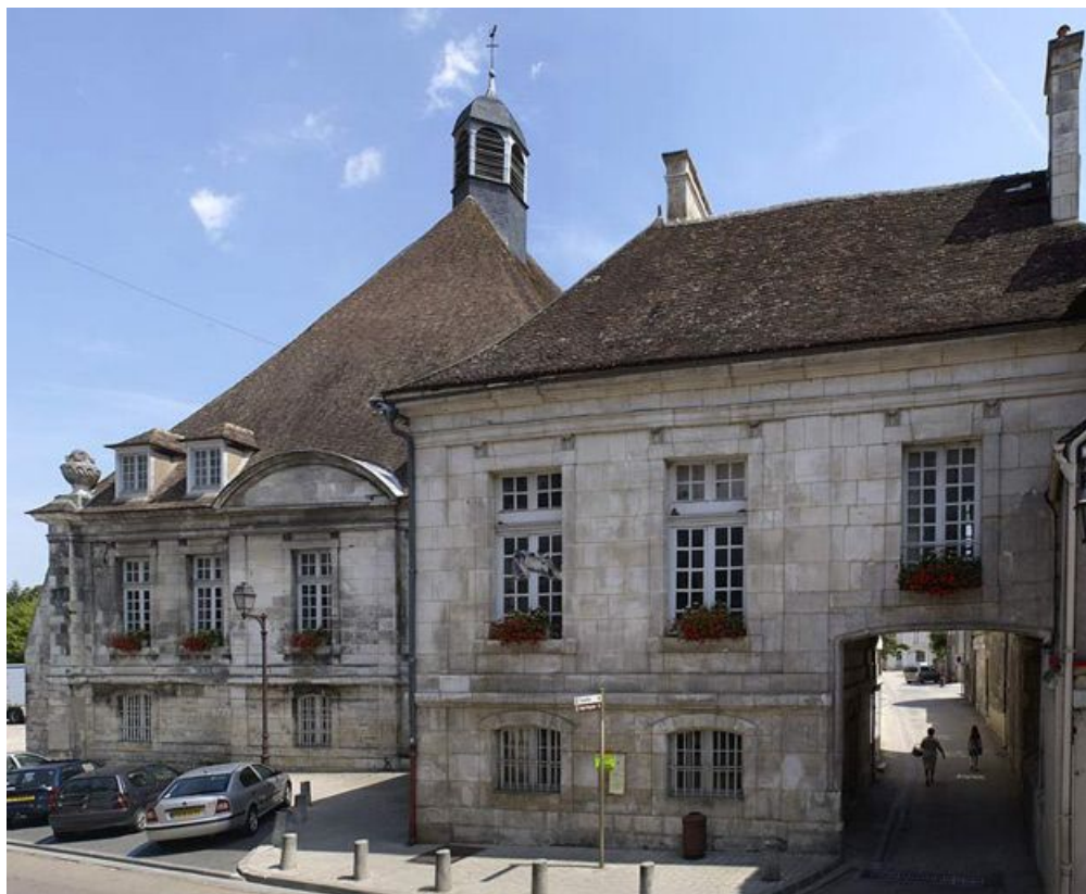
Vue d'ensemble de la façade sur rue, du bâtiment "des salles bourgeoises" et du passage de l'ancienne rue du Prieuré. 89, Tonnerre Hôpital
