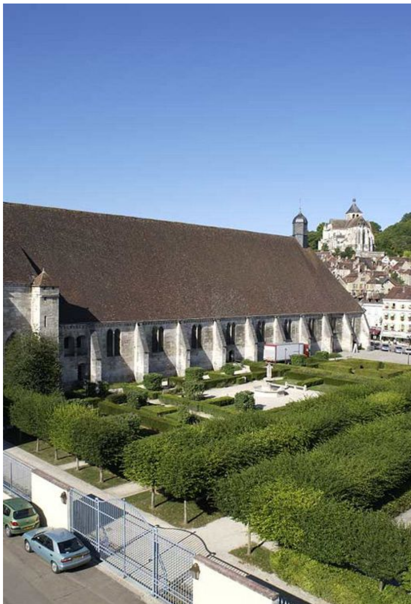
Vue d'ensemble du mur gouttereau nord, prise depuis le pavillon Dormois. 89, Tonnerre Hôpital
