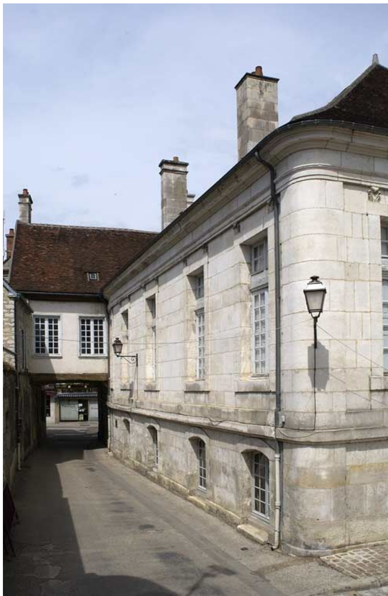
Aile en retour du bâtiment dit "des salles bourgeoises". 89, Tonnerre Hôpital
