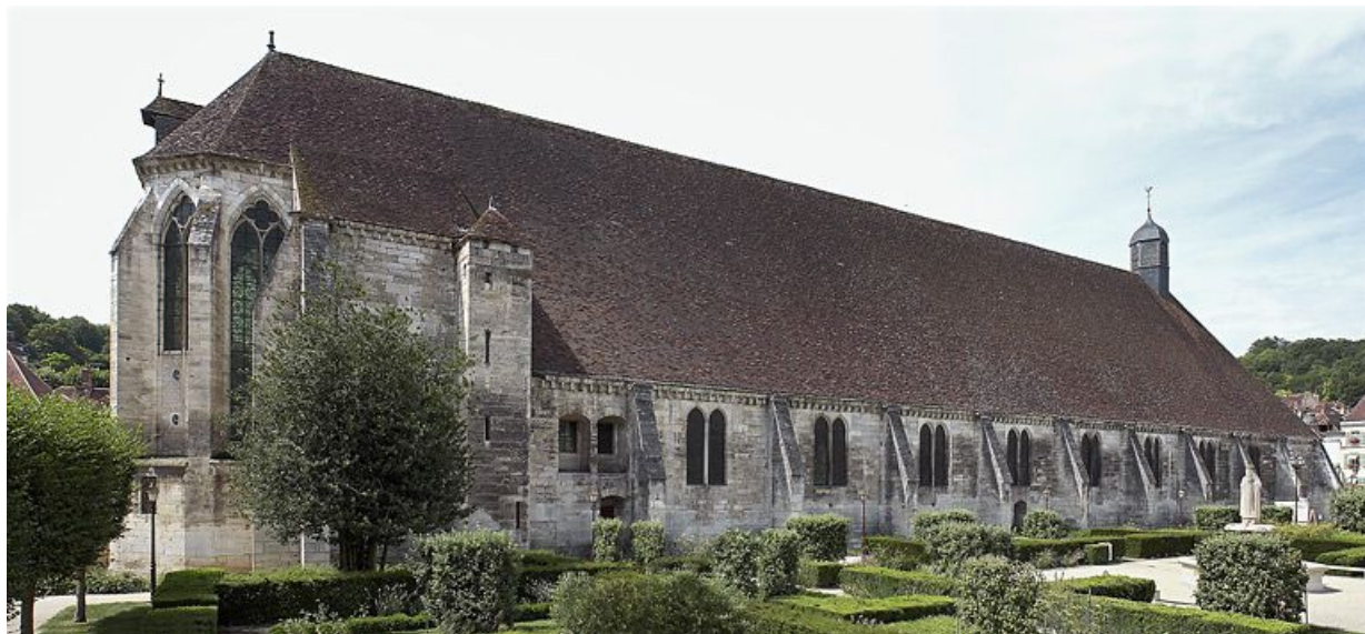
Vue d'ensemble de la façade nord.
