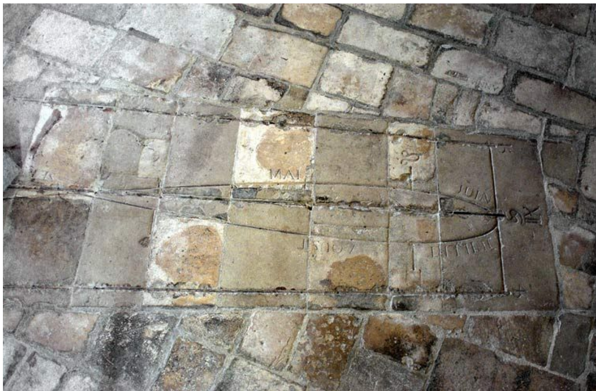
Ancienne salle des malades : le Gnomon, vue partielle.
