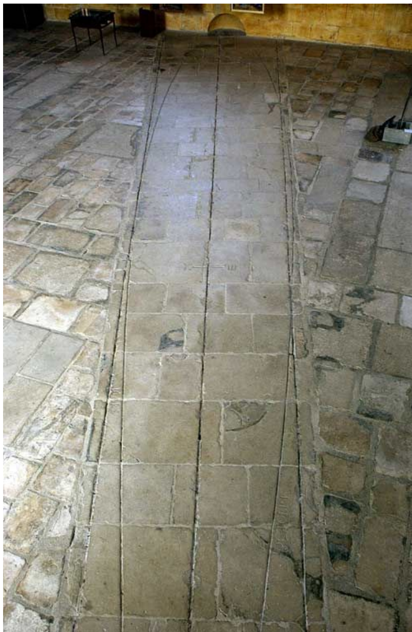
Ancienne salle des malades : le Gnomon, vue partielle. 89, Tonnerre Hôpital
