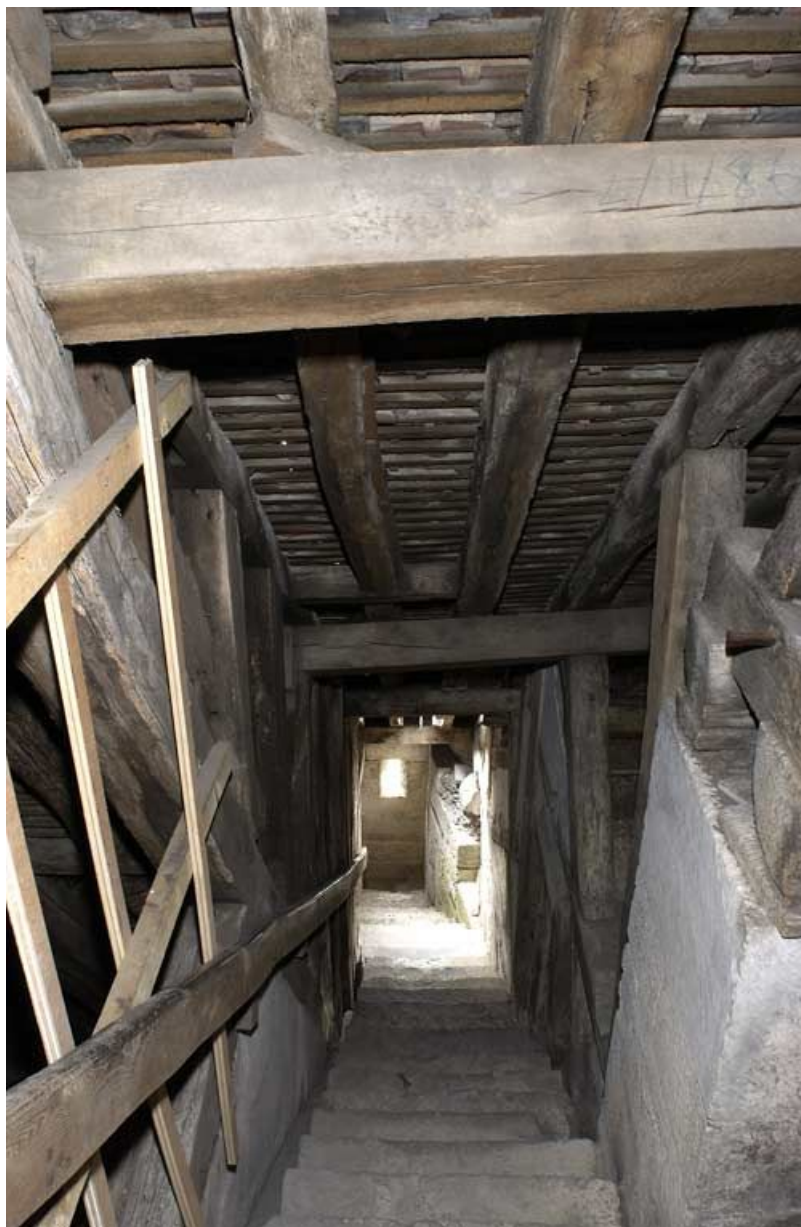
Montée d'escalier conduisant à la charpente. 89, Tonnerre Hôpital
