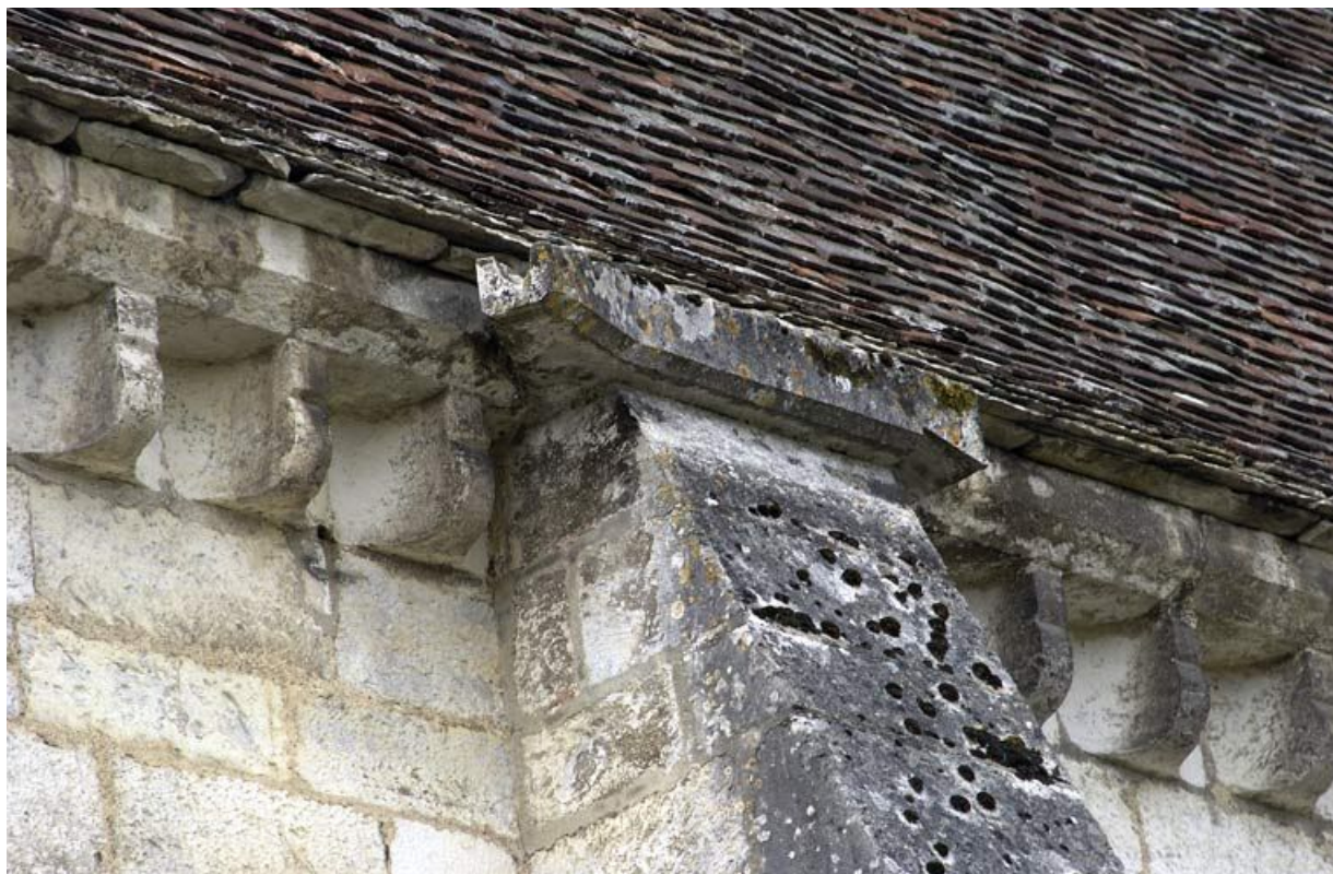
Mur gouttereau nord : jonction du contrefort, corniche sculptée à modillons, évacuation des eaux pluviales. 89, Tonnerre Hôpital
