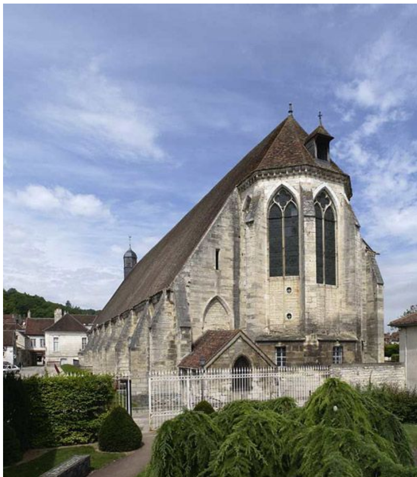
Vue d'ensemble du chœur et de la chapelle du revestiaire.
