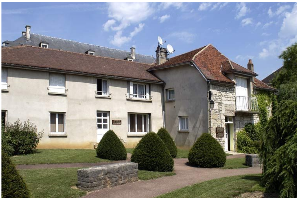
Vestiges restructurés de l'ancien logis du chapelain.
