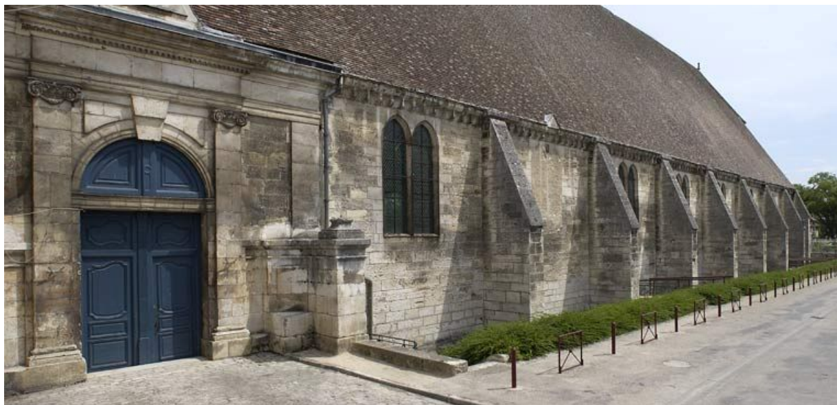
Porte monumentale sud et mur gouttereau.
