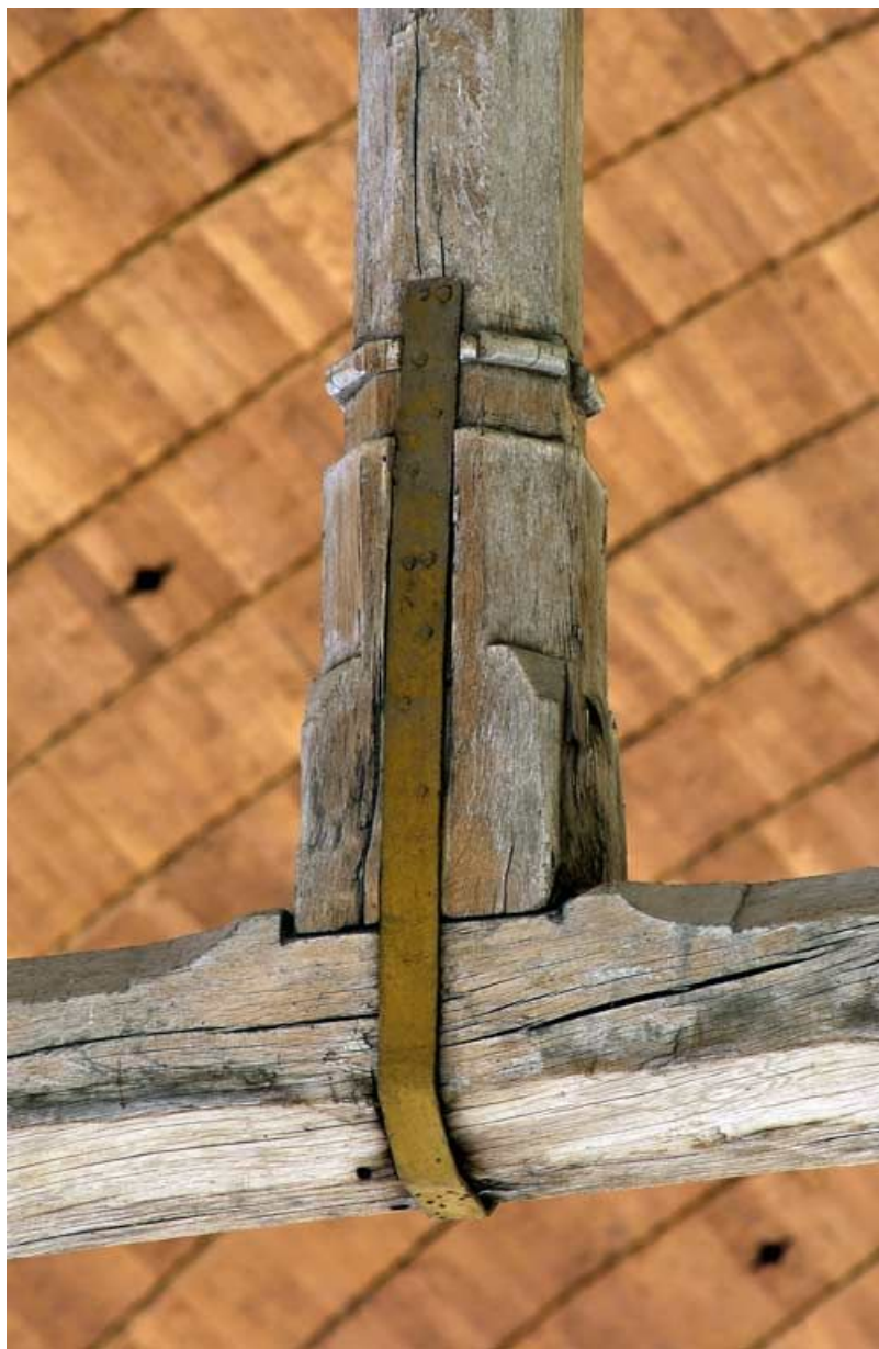
Ancienne salle des malades : poinçon de la charpente. 89, Tonnerre Hôpital
