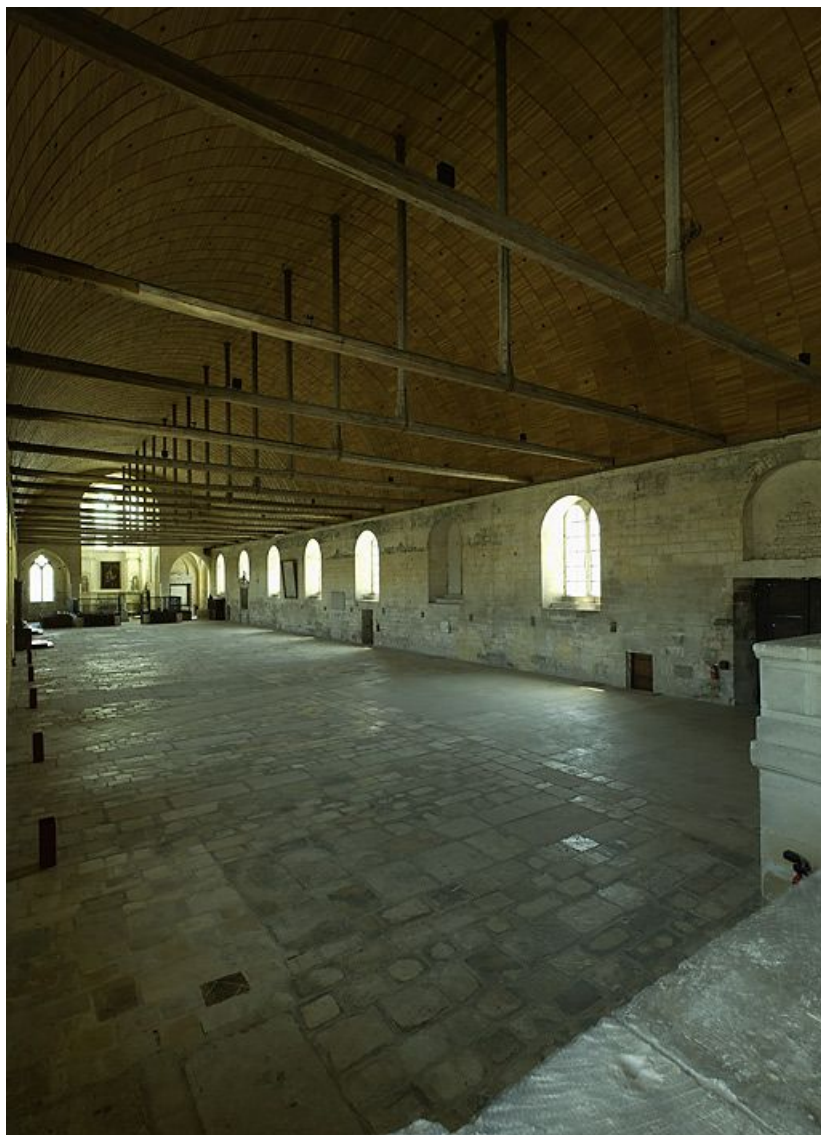
Ancienne salle des malades : vue d'ensemble. 89, Tonnerre Hôpital
