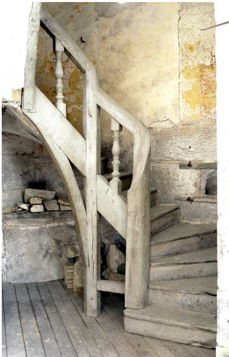
Escalier de la sacristie : limon, balustre et 1ère volée. 89, Tonnerre Hôpital
