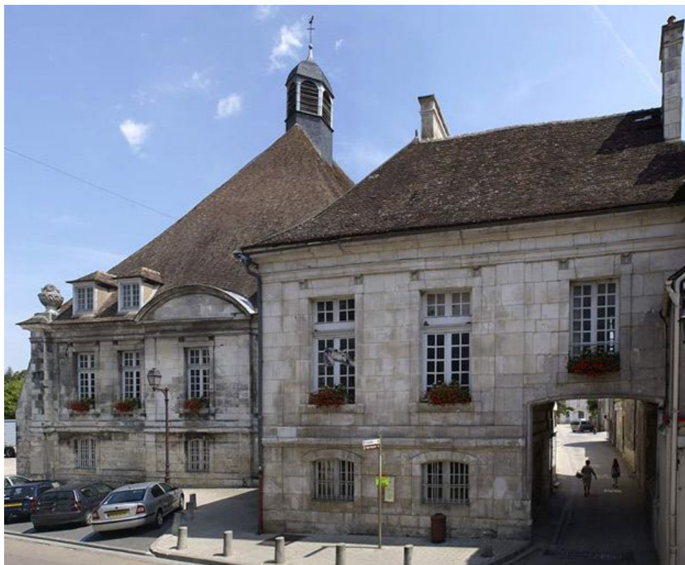
Vue d'ensemble de la façade sur rue, du bâtiment "des salles bourgeoises" et du passage de l'ancienne rue du Prieuré. 89, Tonnerre Hôpital
