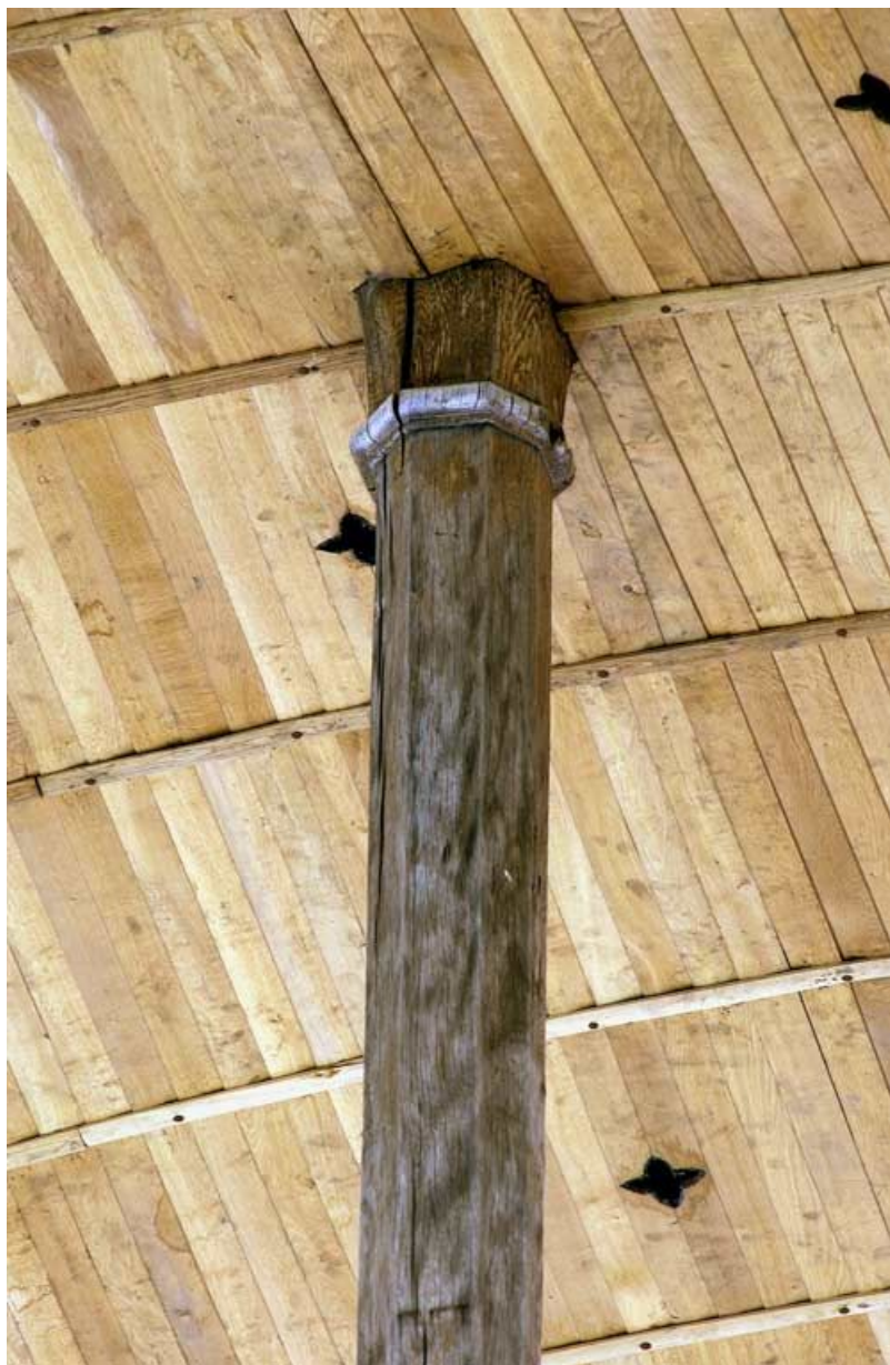
Ancienne salle des malades : départ du poinçon de la charpente. 89, Tonnerre Hôpital
