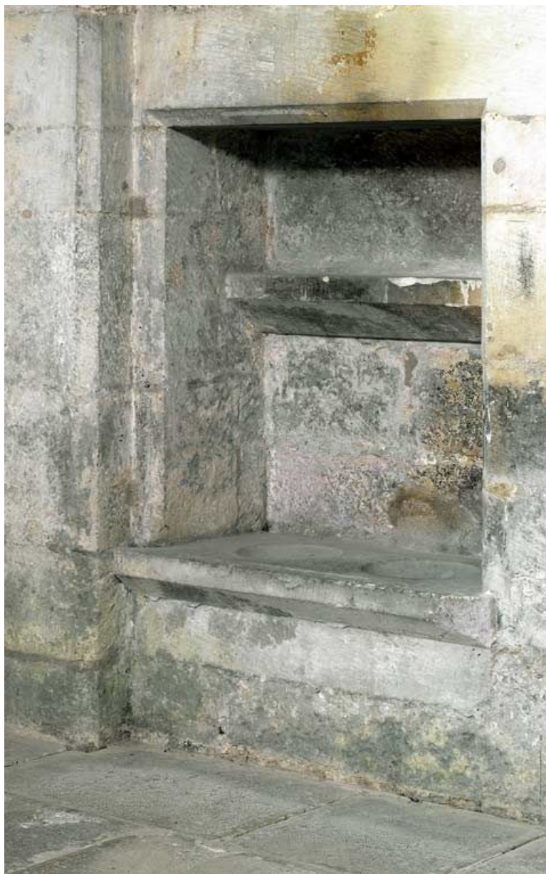
Lavabo de la chapelle latérale nord.
