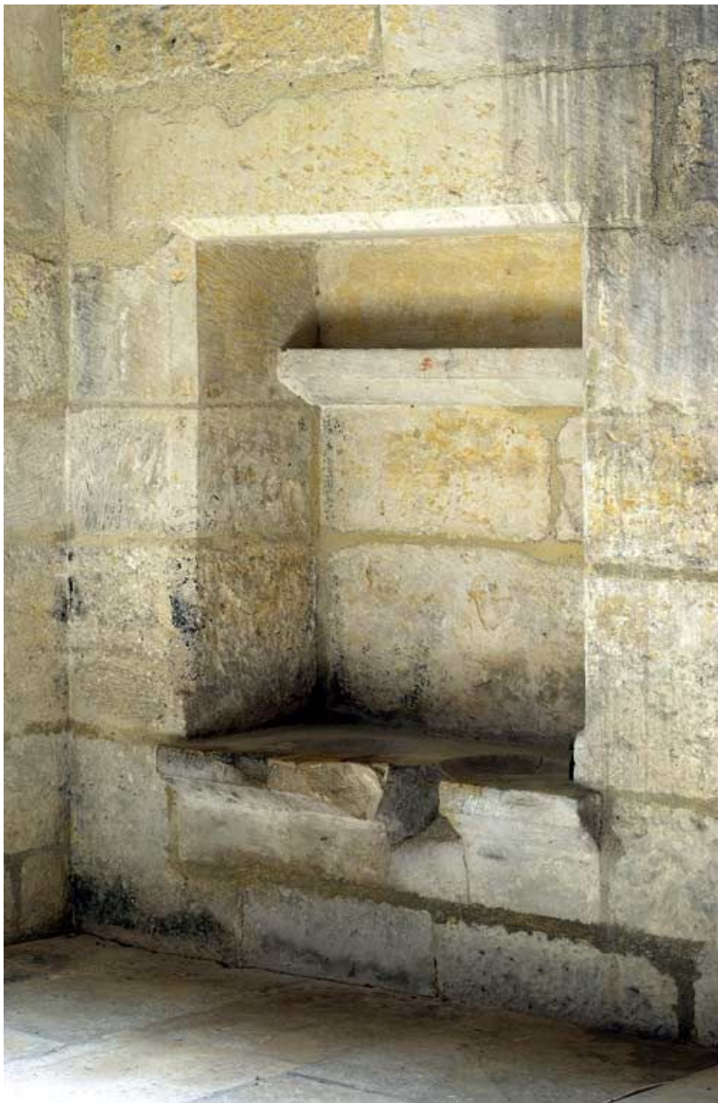
Lavabo de la chapelle latérale sud.
