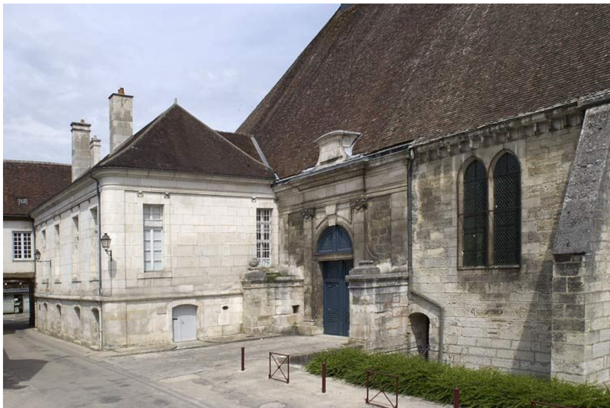
Porte monumentale sud et bâtiment "des salles bourgeoises". 89, Tonnerre Hôpital
