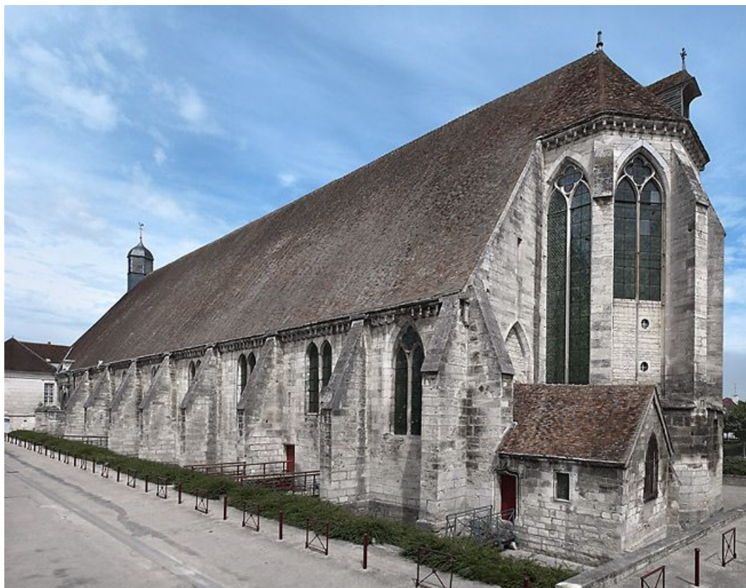
Élévation sud et abside.
