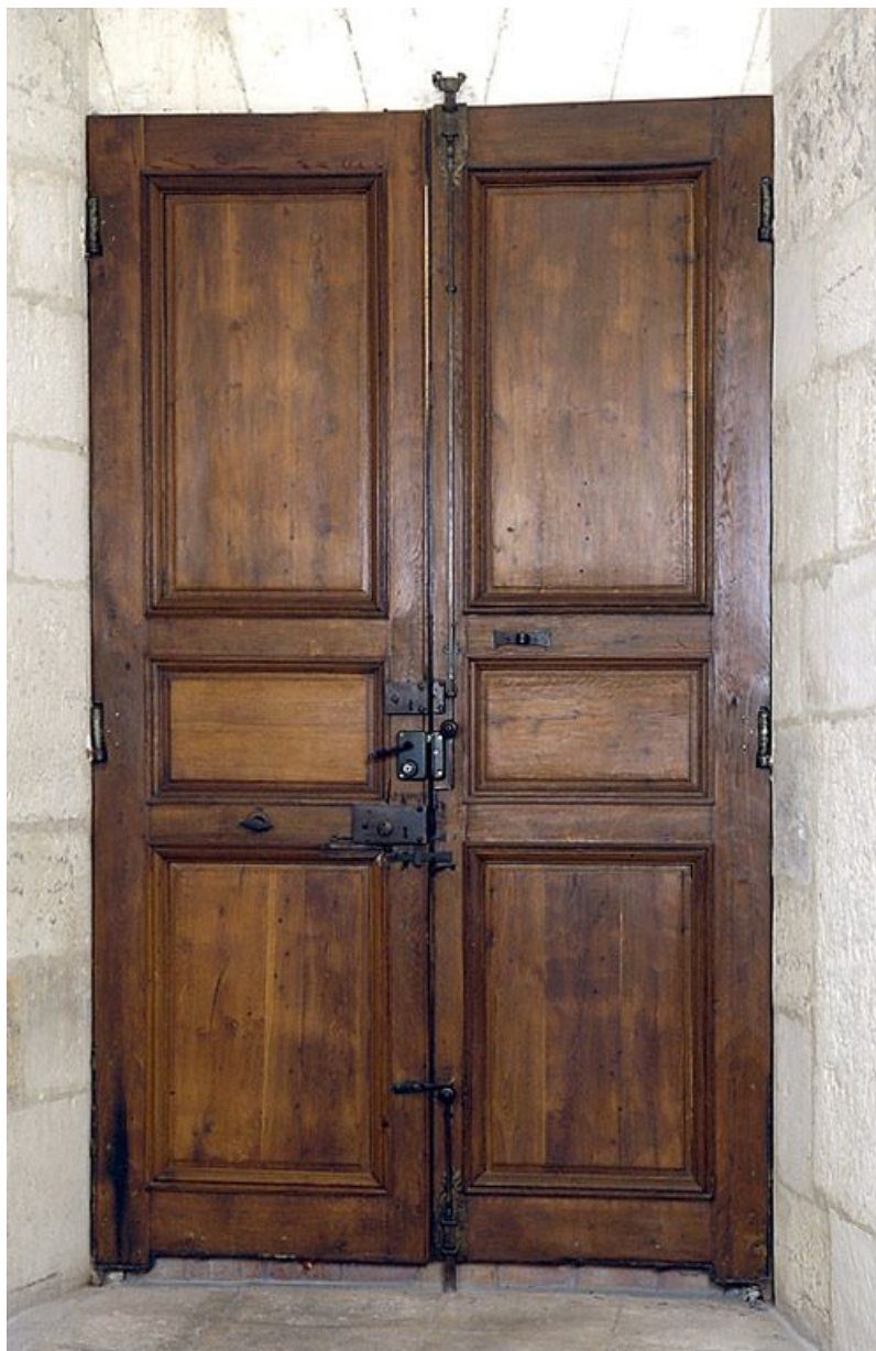
Porte dans la salle Courtauvaux.
