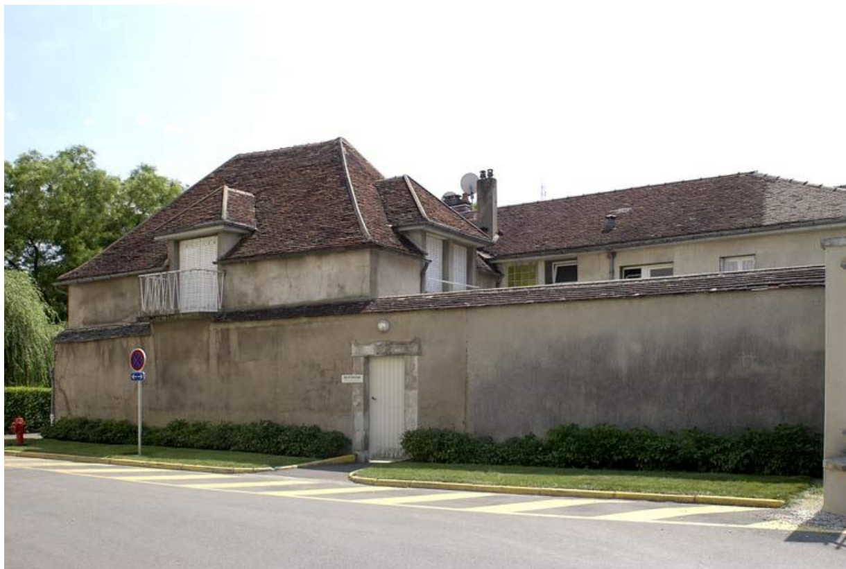
Vue d'ensemble de l'ancien logis du chapelain. 89, Tonnerre Hôpital
