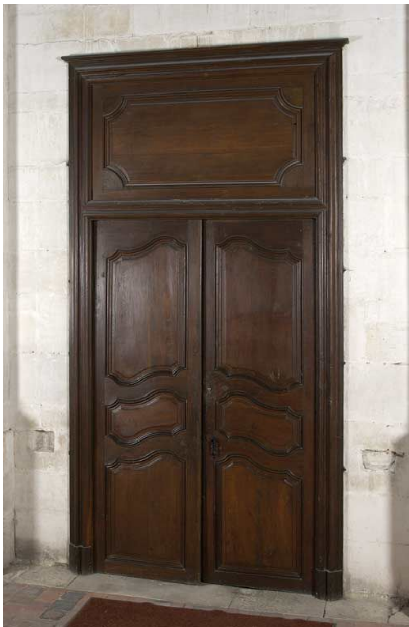
Porte donnant accès à la salle Courtanvaux. 89, Tonnerre Hôpital
