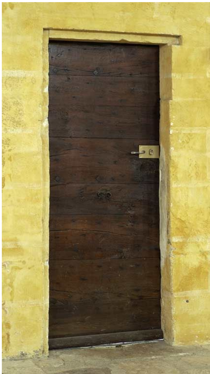
Porte donnant accès aux combles.
