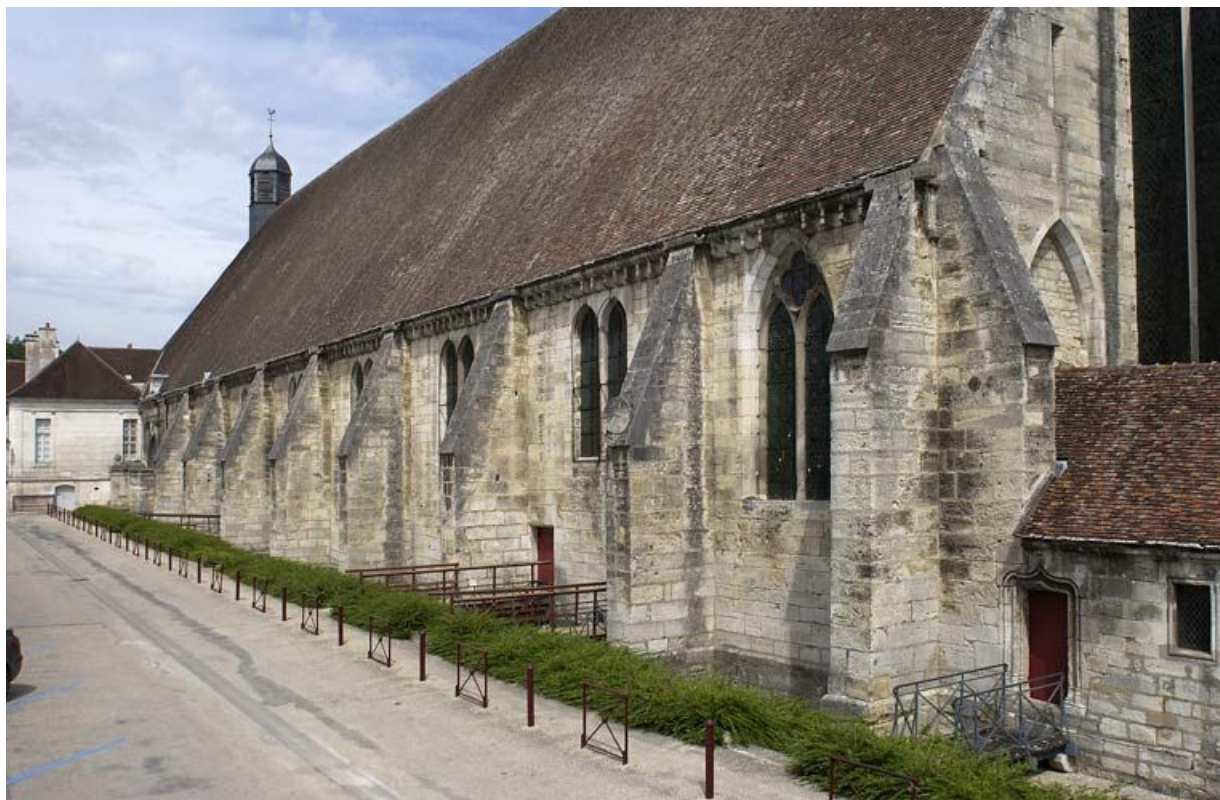
Vue d'ensemble du mur gouttereau sud et de la chapelle du revestiaire. 89, Tonnerre Hôpital
