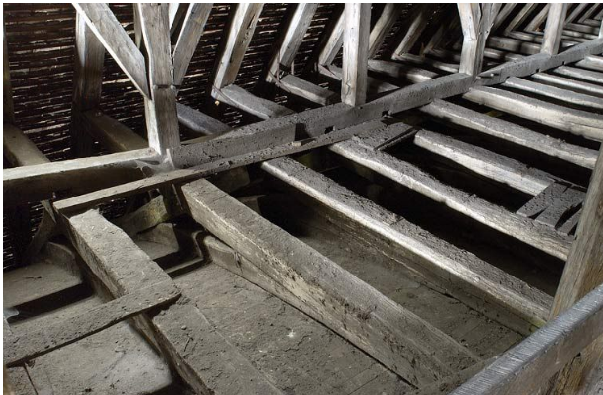
Charpente de l'ancienne salle des malades : détail des pannes. 89, Tonnerre Hôpital
