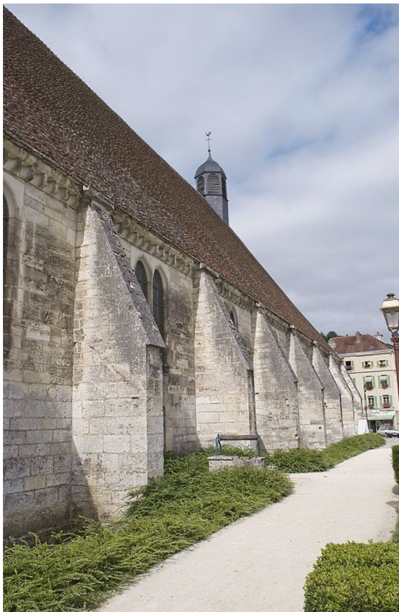
Vue des contreforts de la façade nord.
