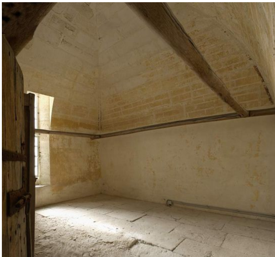
Vue intérieure de l'ancienne pièce des archives.
