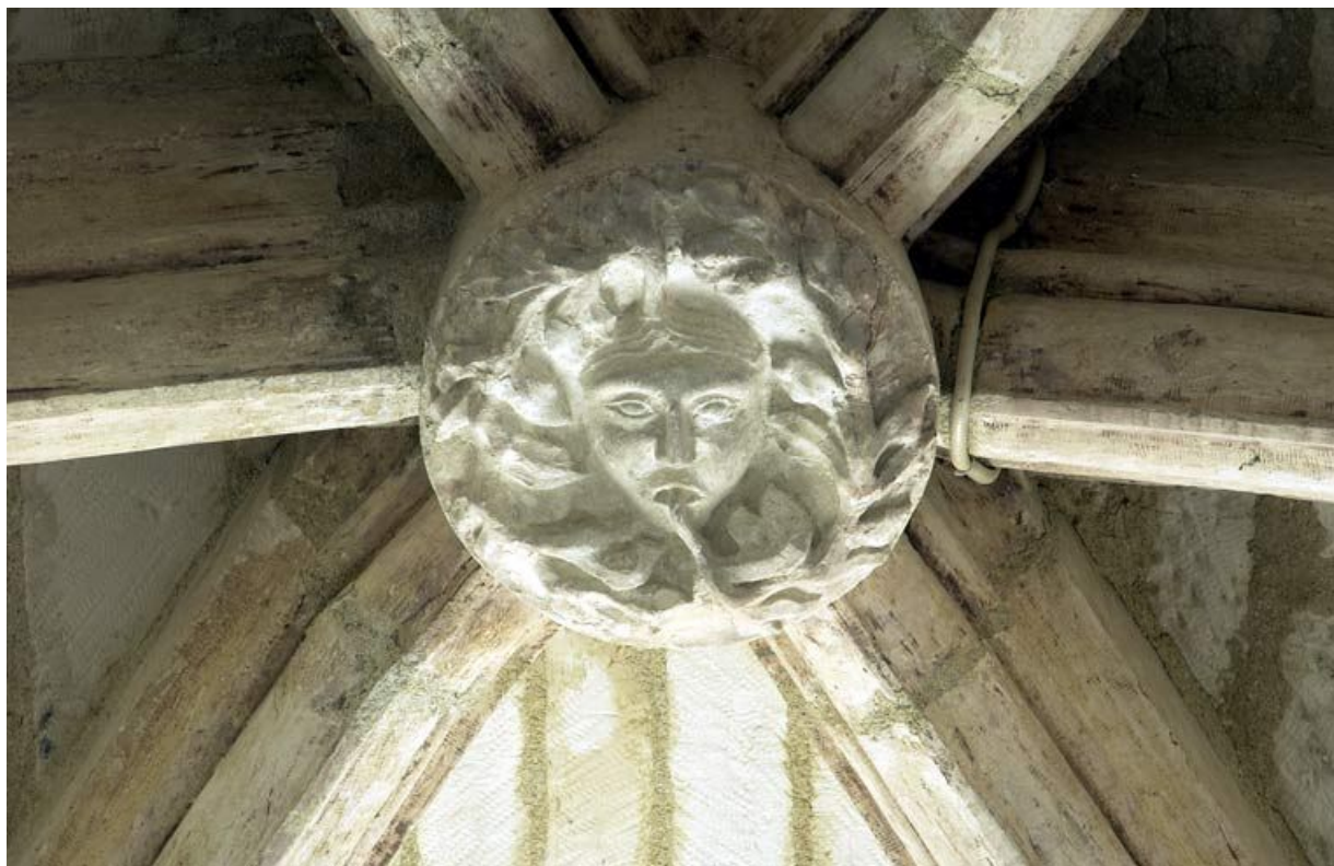
Chapelle du revestiaire : clé de voûte.
