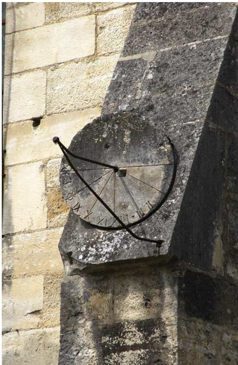
Mur gouttereau sud : cadran solaire.
