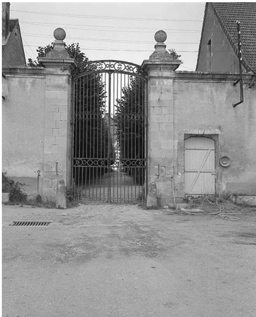
Grille d'entrée de la cour des communs.
