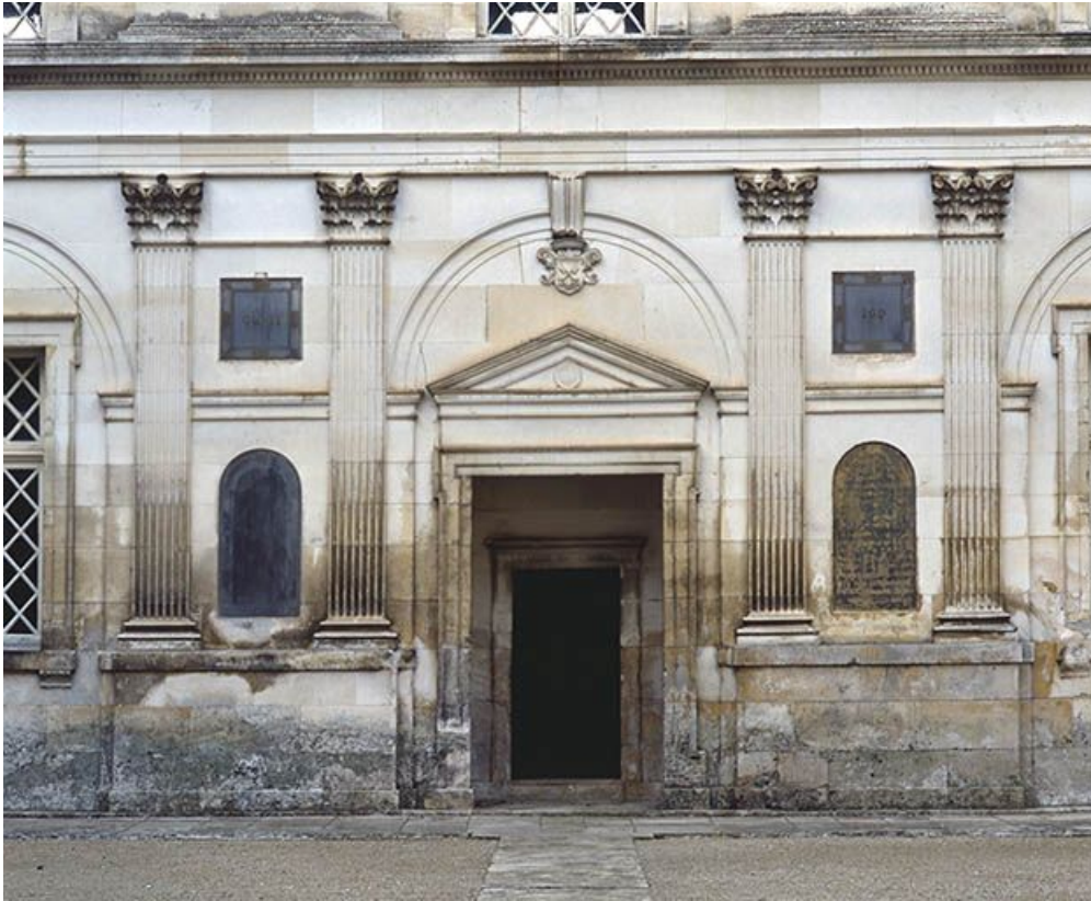
Façade sur cour, détail 89, Ancy-le-Franc
