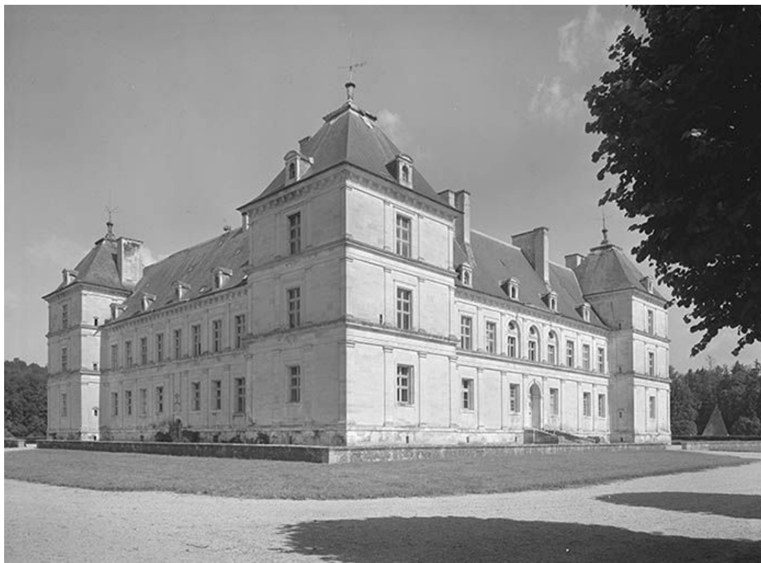
Façades sud et ouest.
