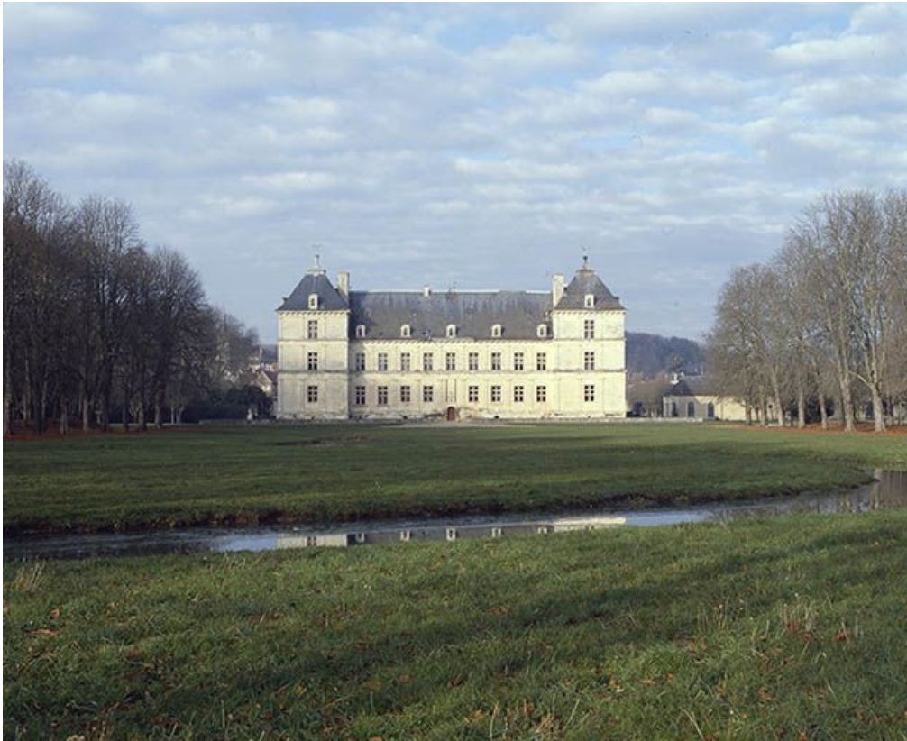
Vue d'ensemble de l'élévation sud.
