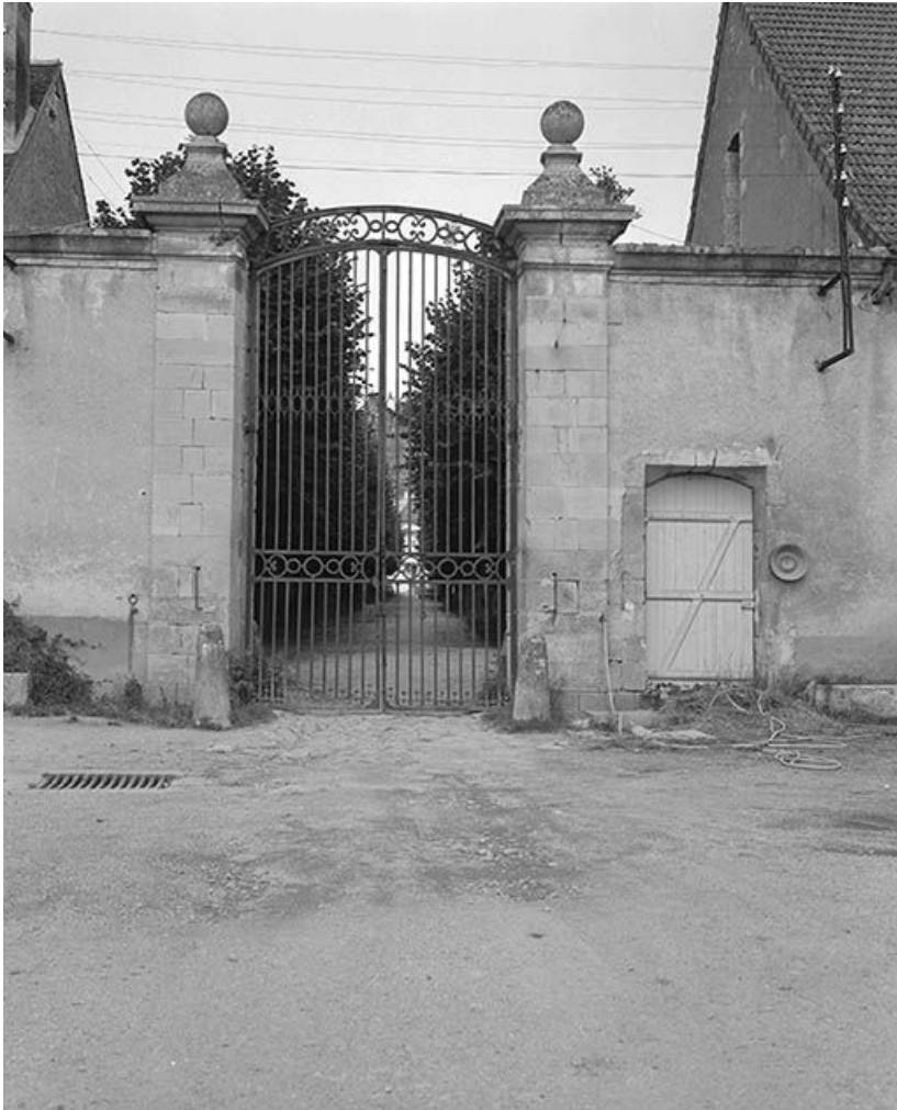
Grille d'entrée de la cour des communs.
