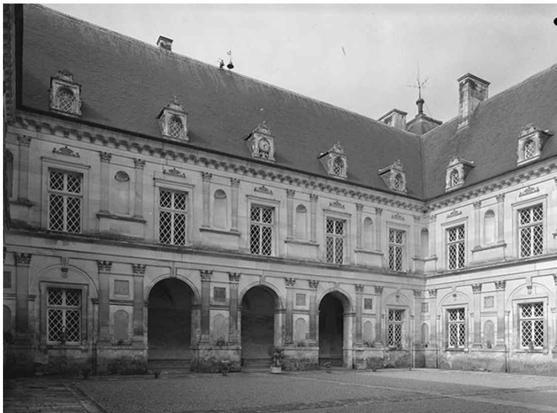
Façades sur cour (sud et ouest).
