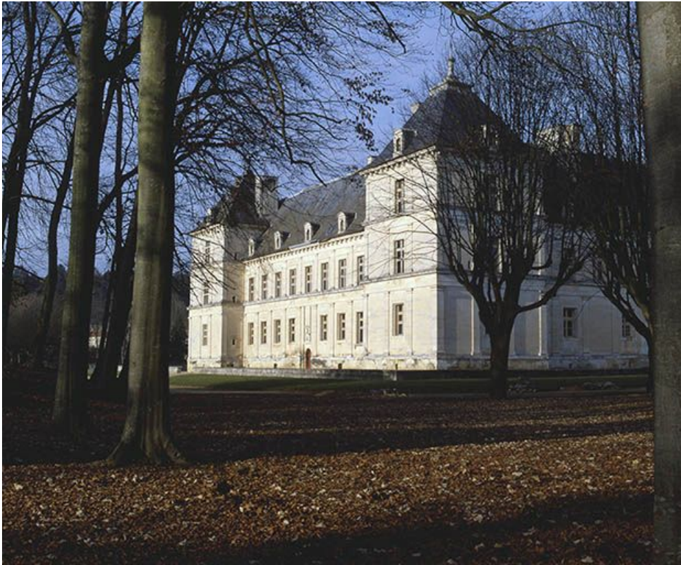
Élévation sud, vue de trois-quarts.
