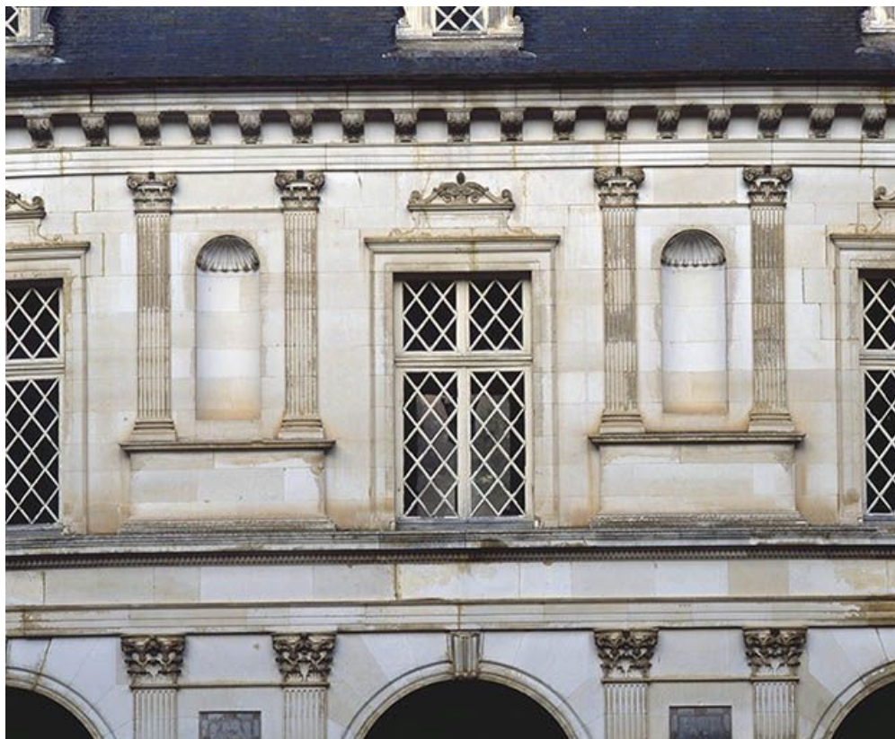
Façade sur cour, détail 89, Ancy-le-Franc
