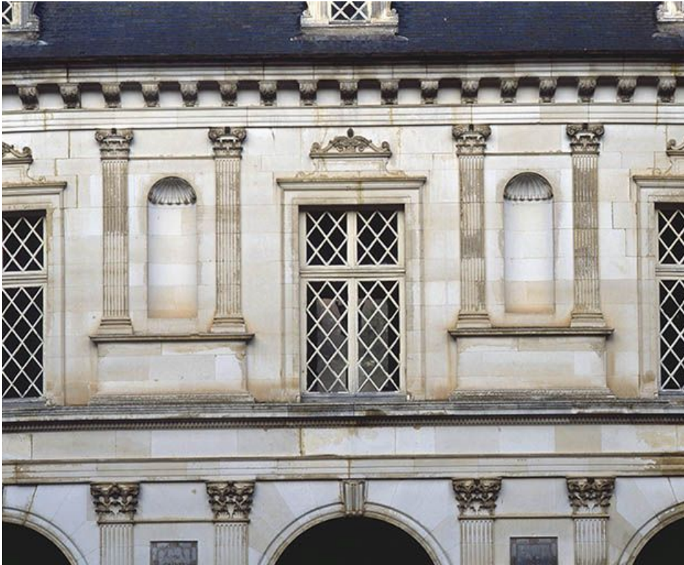
Façade sur cour, détail 89, Ancy-le-Franc
