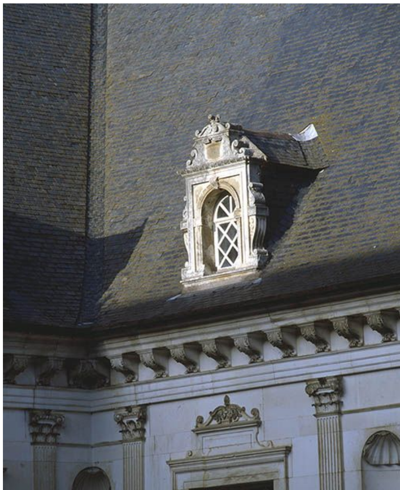
Façade sur cour, détail : lucarne 89, Ancy-le-Franc
