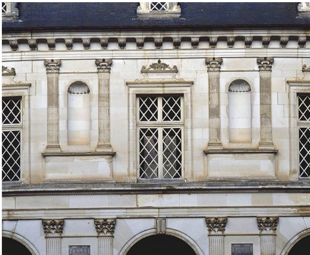
Façade sur cour, détail 89, Ancy-le-Franc
