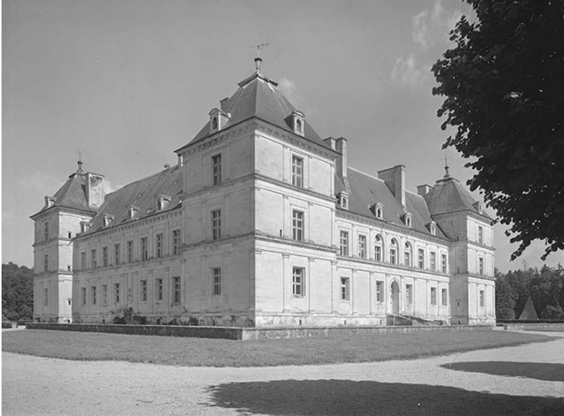
Façades sud et ouest.
