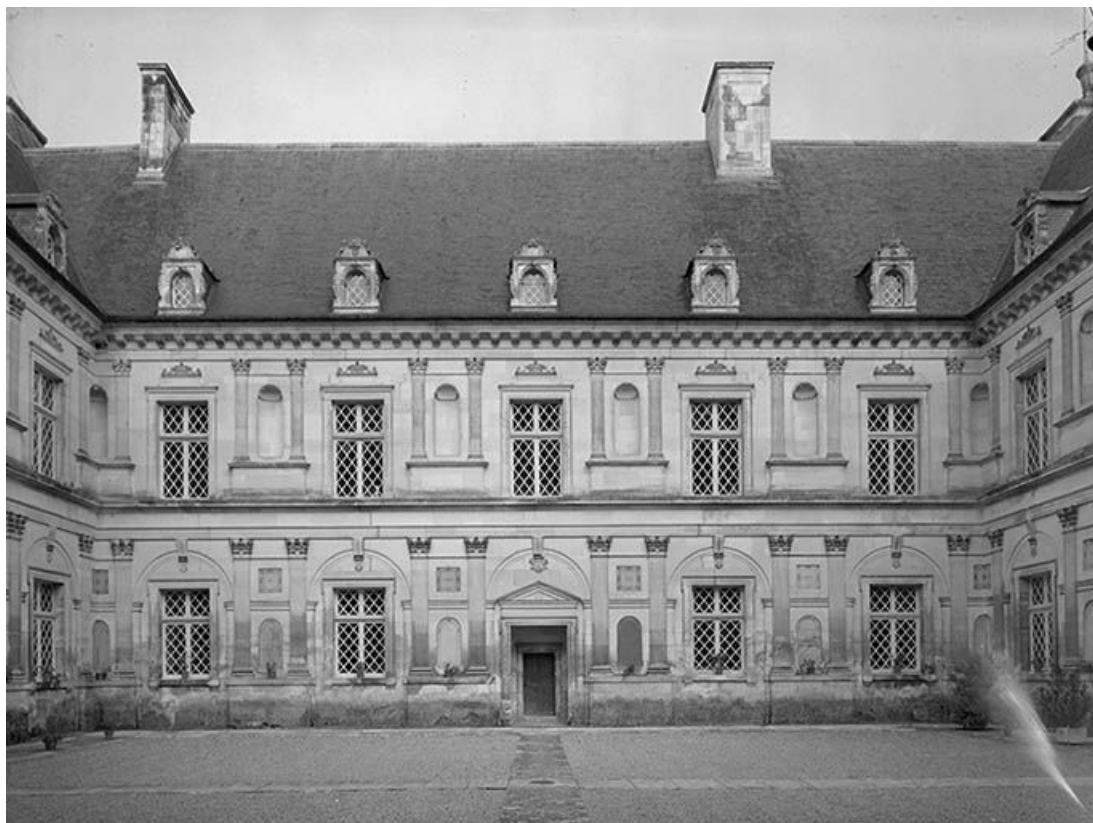
Façade sur cour (ouest). 89, Ancy-le-Franc
