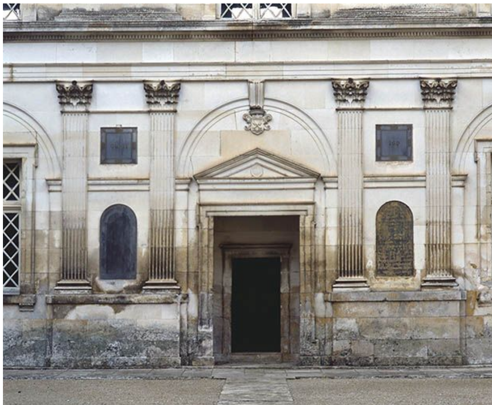
Façade sur cour, détail 89, Ancy-le-Franc
