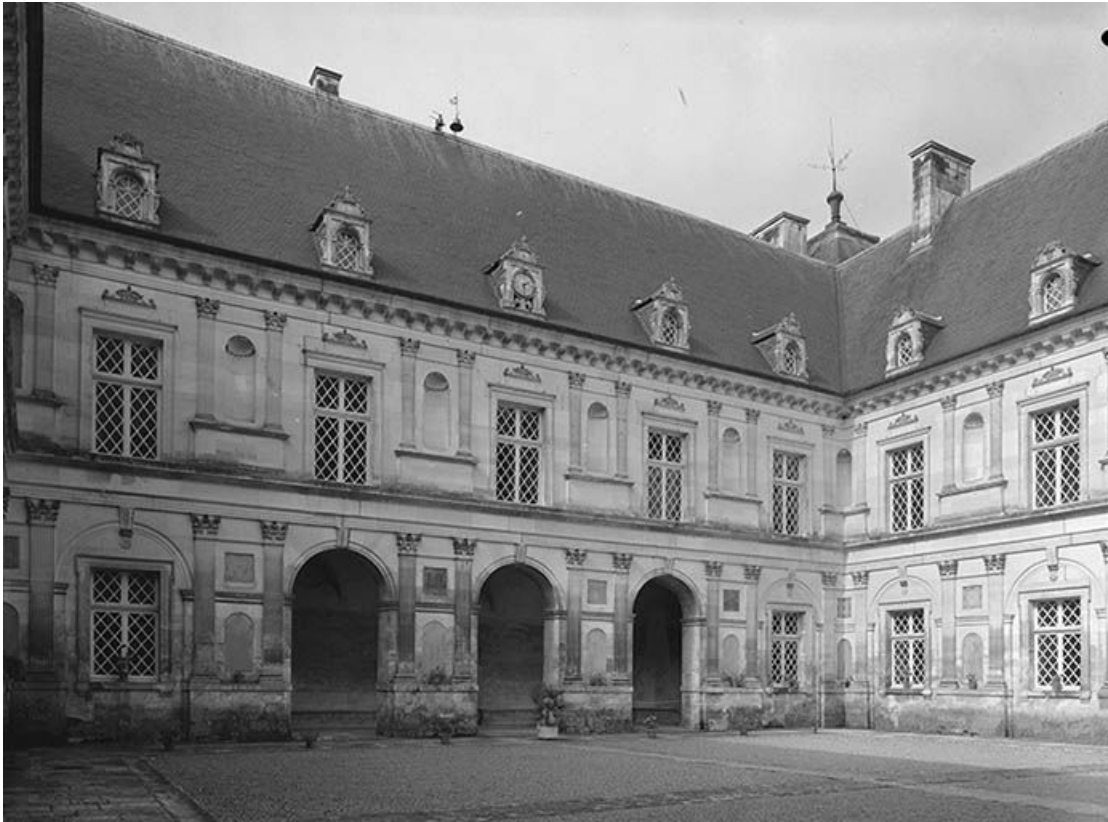
Façades sur cour (sud et ouest).
