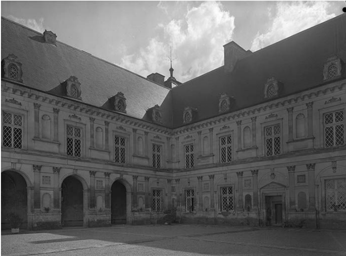
Façades sur cour (nord et est).
