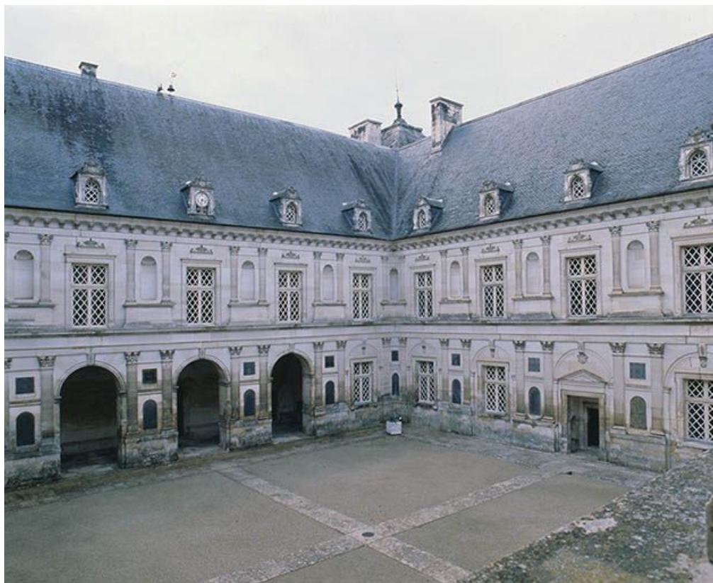
Cour intérieure, vue de trois-quarts. 89, Ancy-le-Franc
