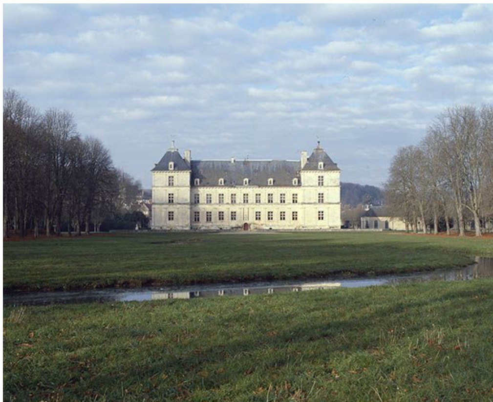
Vue d'ensemble de l'élévation sud.
