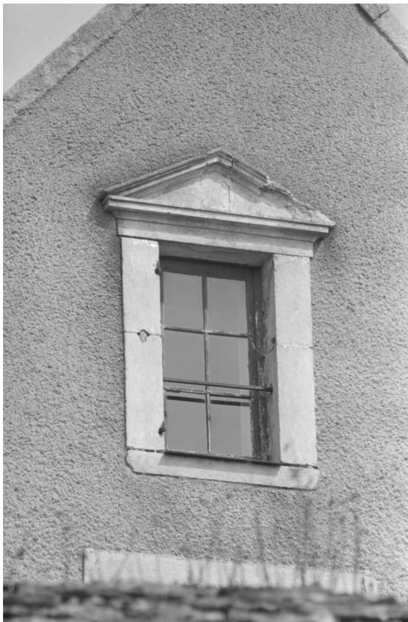
Détail d'une fenêtre donnant sur la cour fermée rue Venoise.
