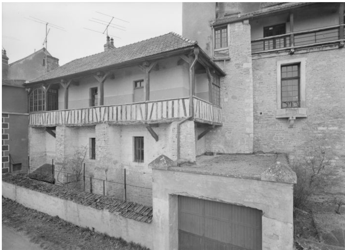
Élévation d'un des corps de bâtiment sur la promenade des fossés (côté Serein). 89, Noyers Venoise
