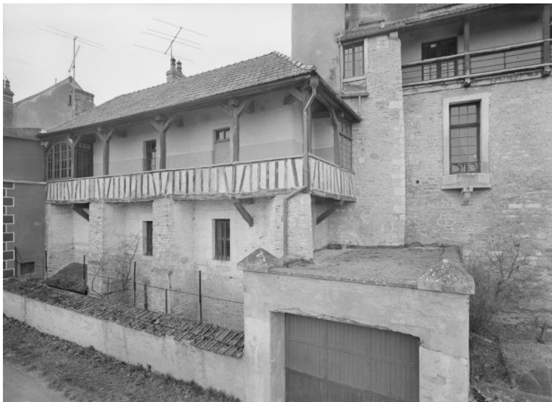
Élévation d'un des corps de bâtiment sur la promenade des fossés (côté Serein). 89, Noyers Venoise
