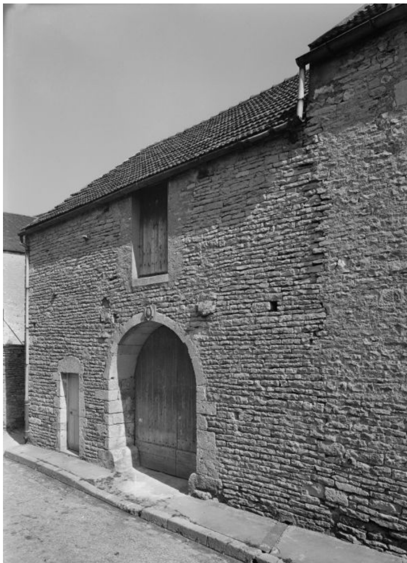
Façade de la grange. 89, Noyers Petite Rue
