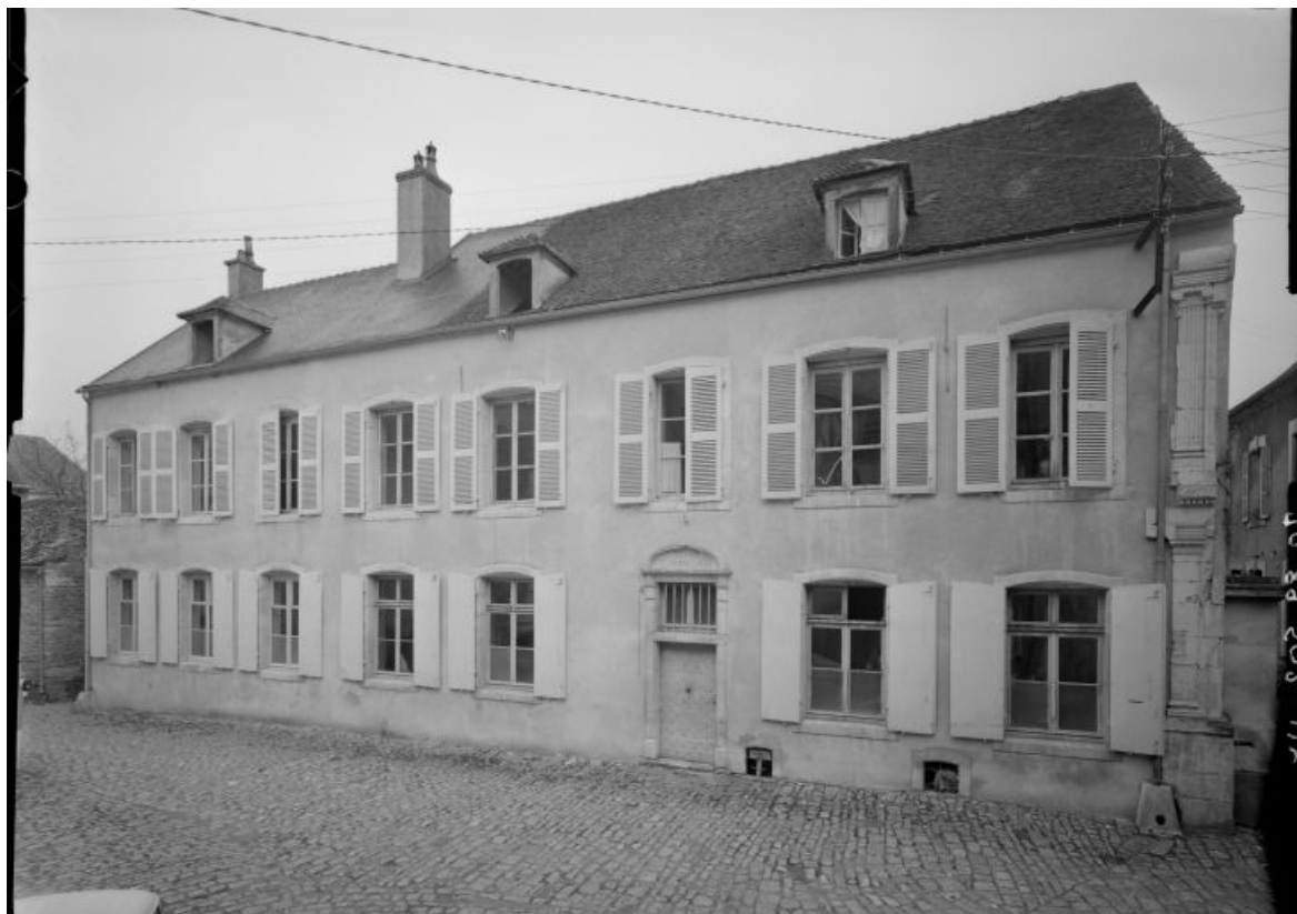
Façade sur la Petite Rue.
