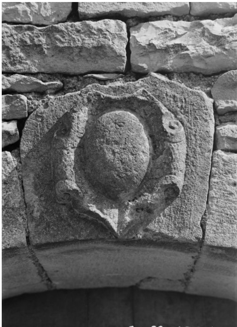
Façade de la grange, détail de la porte. 89, Noyers Petite Rue
