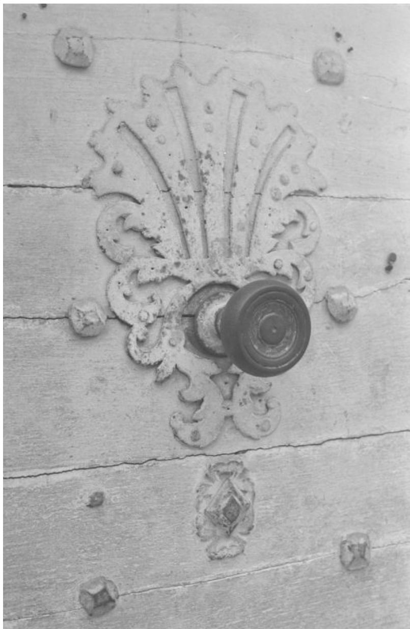
Porte d'entrée, détail de la poignée.
