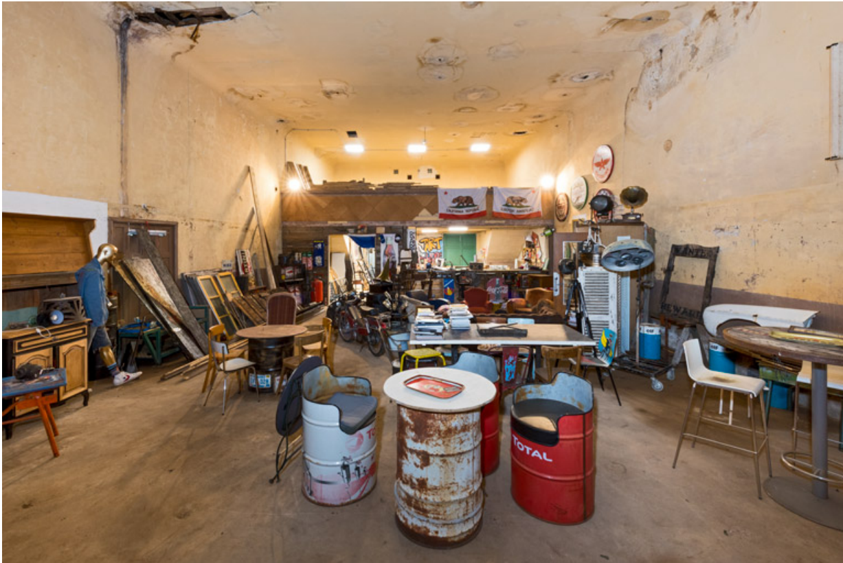
La salle, vue vers le balcon.
