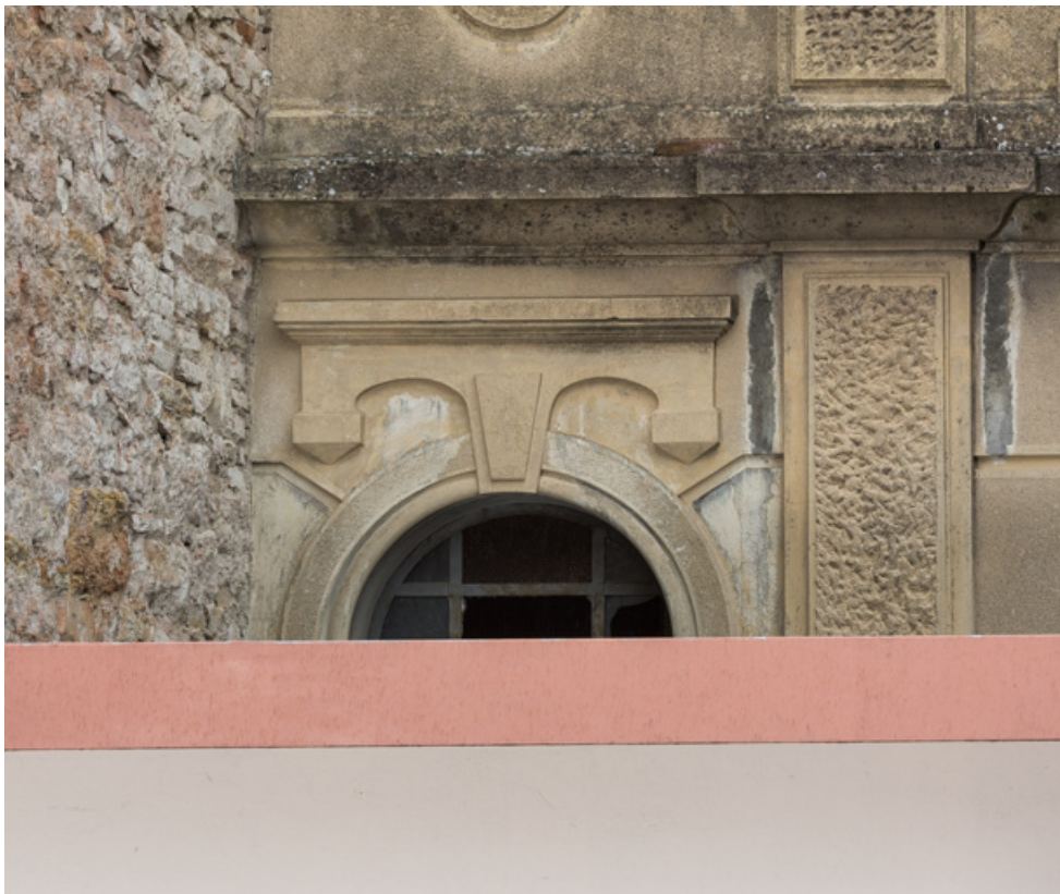
Façade antérieure : décor surmontant une fenêtre.
