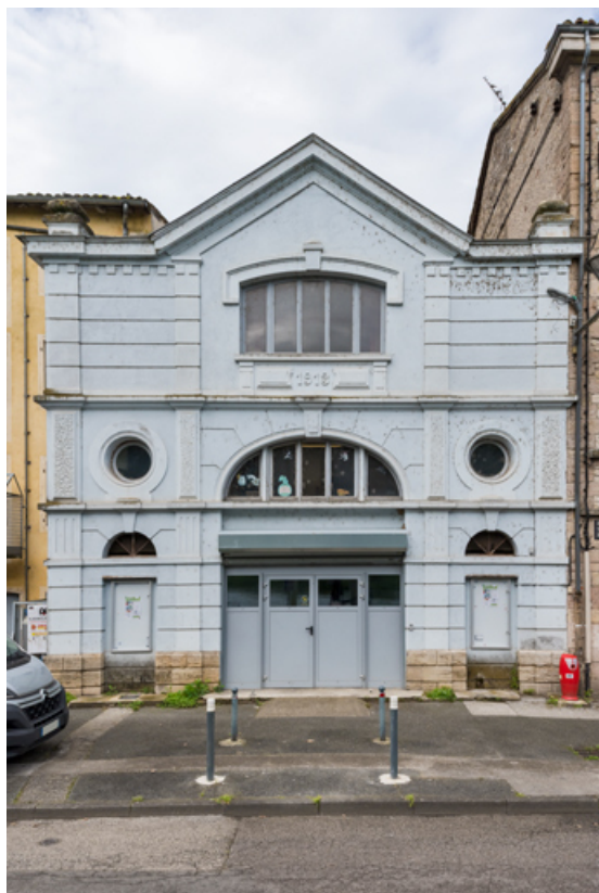
Façade postérieure, quai de Verdun.
