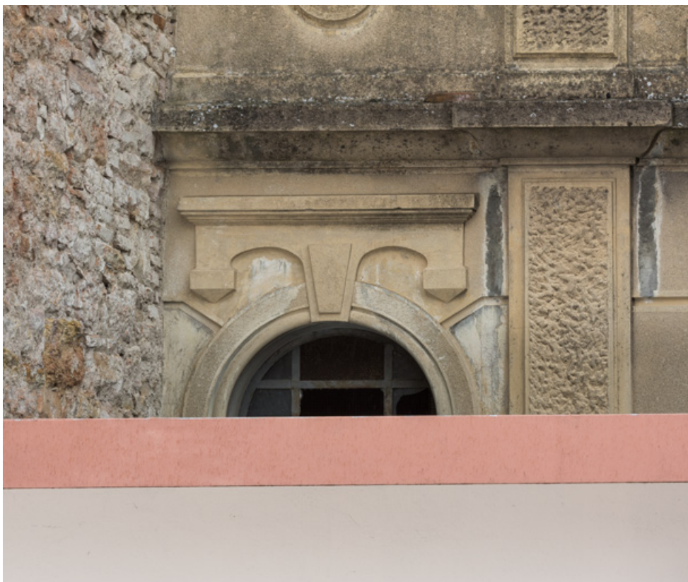
Façade antérieure : décor surmontant une fenêtre.
