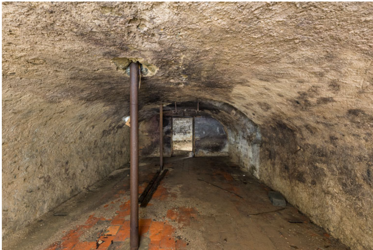
Cave voûtée sous la salle.
