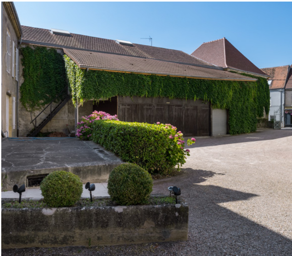
Façade latérale gauche, depuis une cour à l'est. 71, Digoin, 24 rue Nationale
