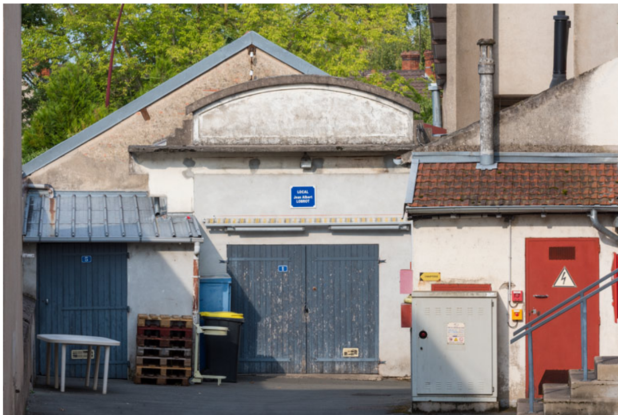
Garage en fond de cour, au nord-est.
