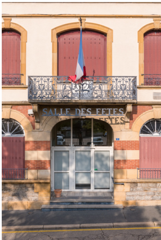
Façade antérieure : travée centrale.
