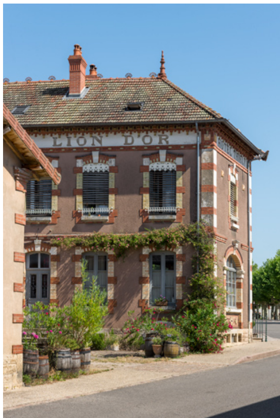
Hôtel-restaurant, vu du sud (vue rapprochée).
