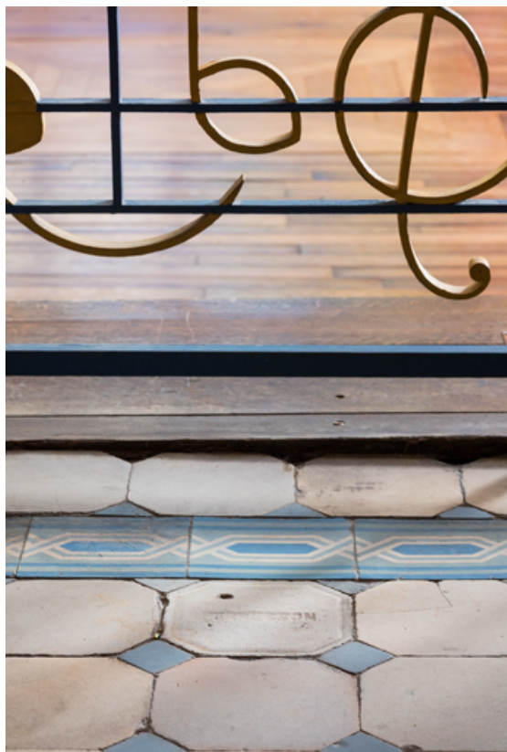
Salle de bal : sol de l'ancienne buvette.
