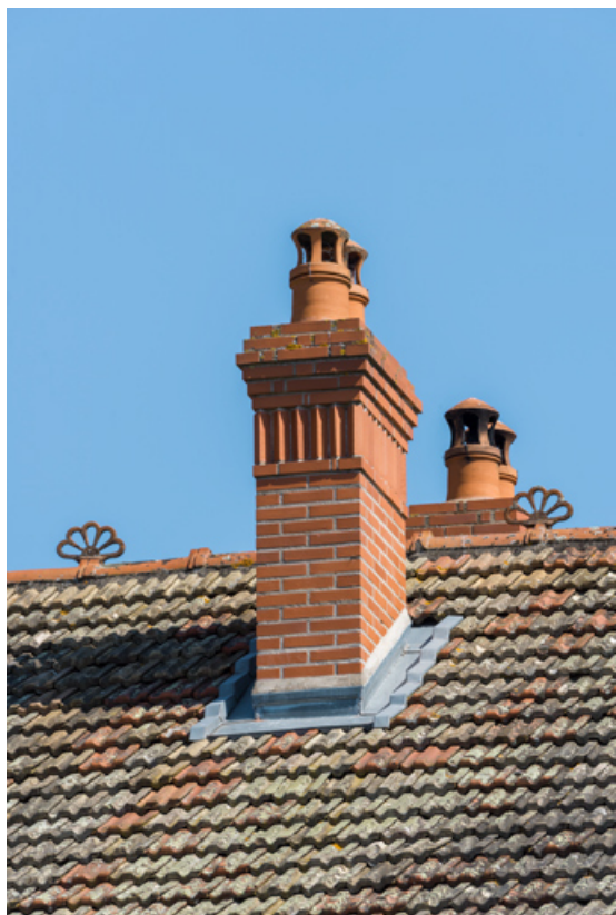
Hôtel-restaurant : souches de cheminée.
