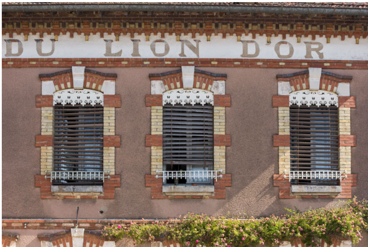
Hôtel-restaurant : façade postérieure, baies à à l'étage.
