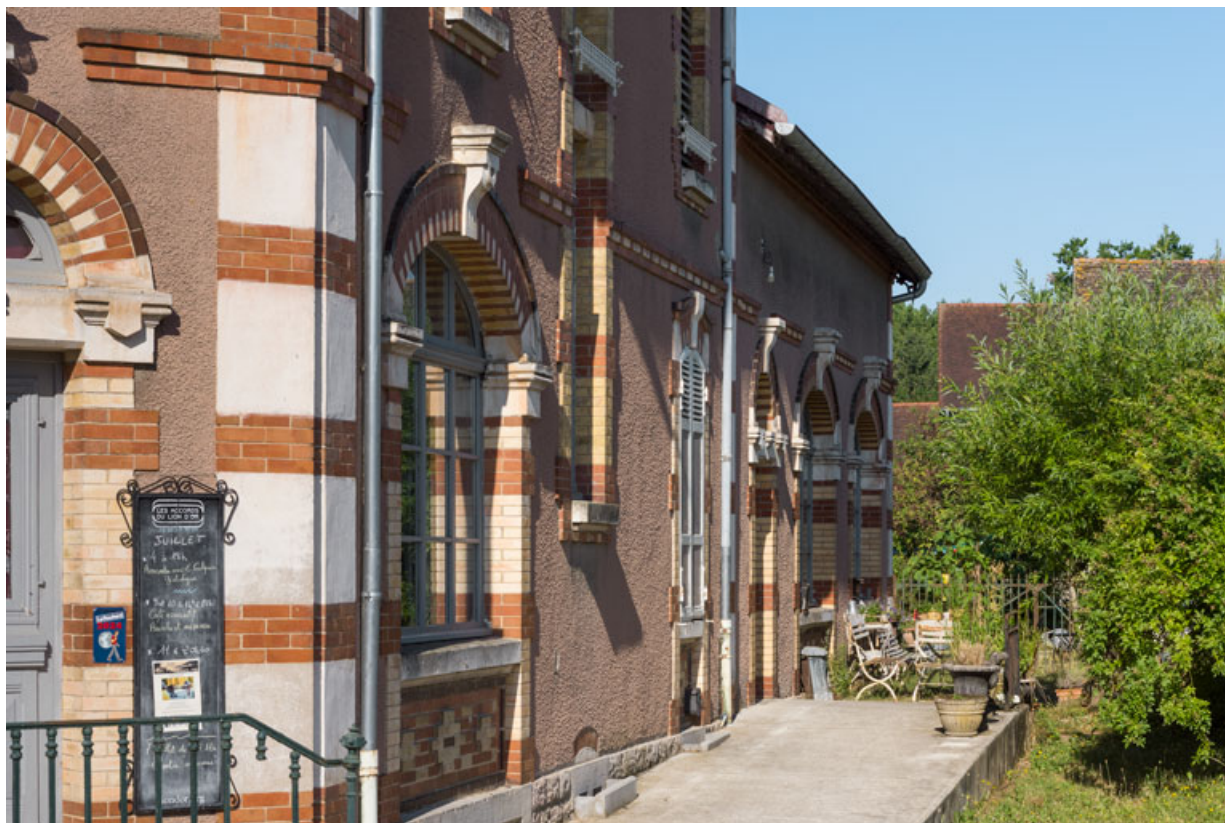
Hôtel-restaurant et salle de bal : façade antérieure, au rez-de-chaussée. 71, Simandre, 87 rue du 19 Mars 1962
