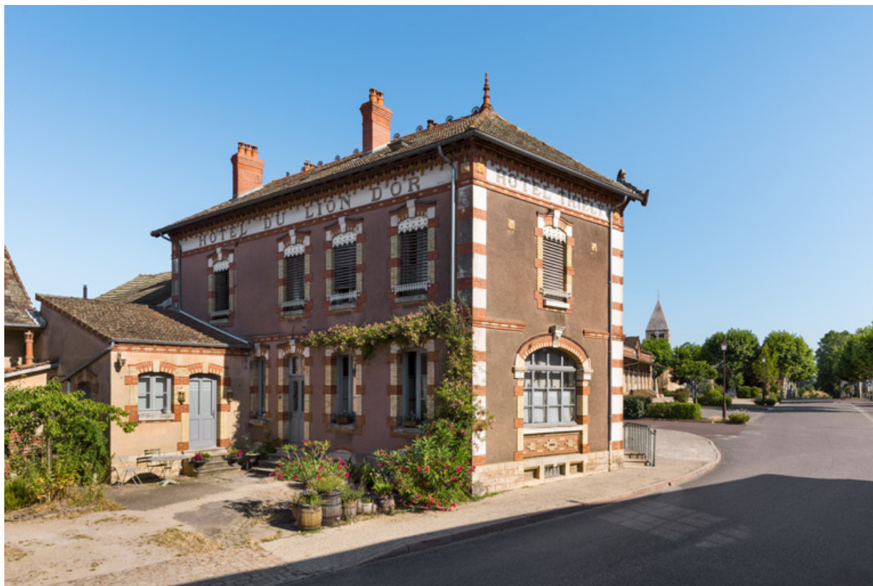
Hôtel-restaurant : façades postérieure et latérale droite. A gauche, la cuisine. 71, Simandre, 87 rue du 19 Mars 1962
