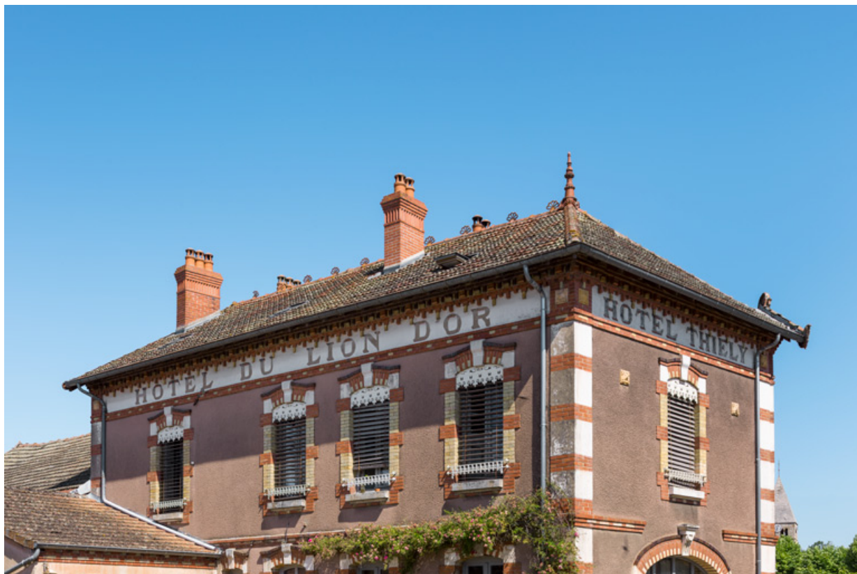
Hôtel-restaurant : façades postérieure et latérale droite, à l'étage.
