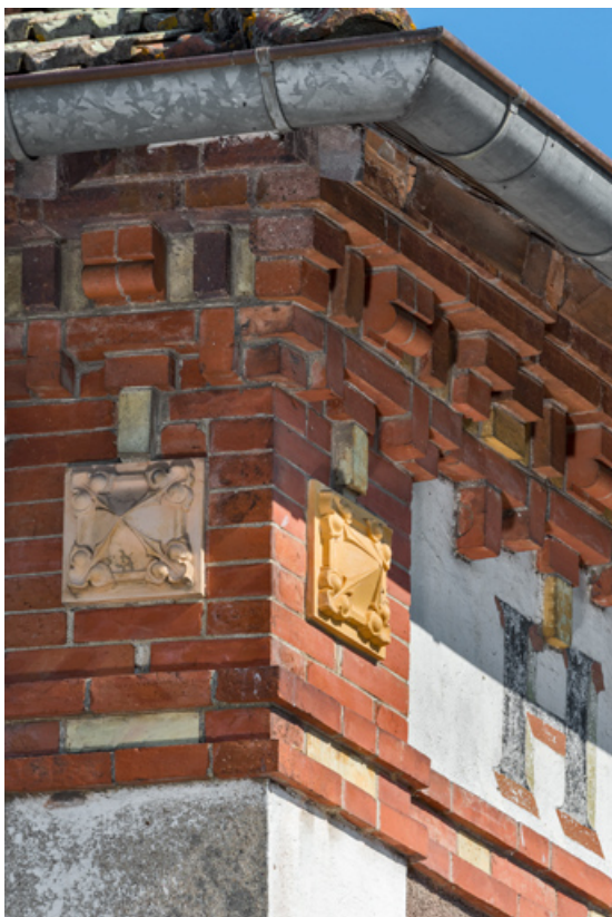
Hôtel-restaurant : décor en partie supérieure des façades postérieure et latérale droite. 71, Simandre, 87 rue du 19 Mars 1962
