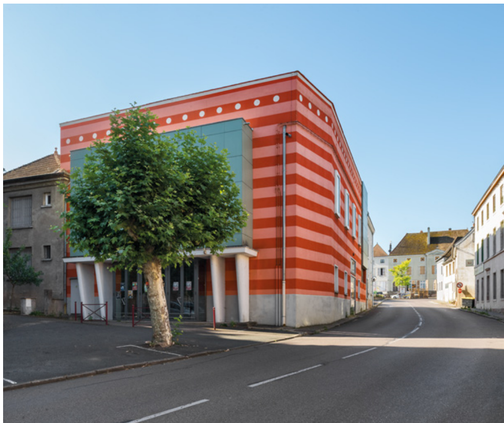
Vue d'ensemble, depuis la place des Lilas au nord : la salle de spectacle.
