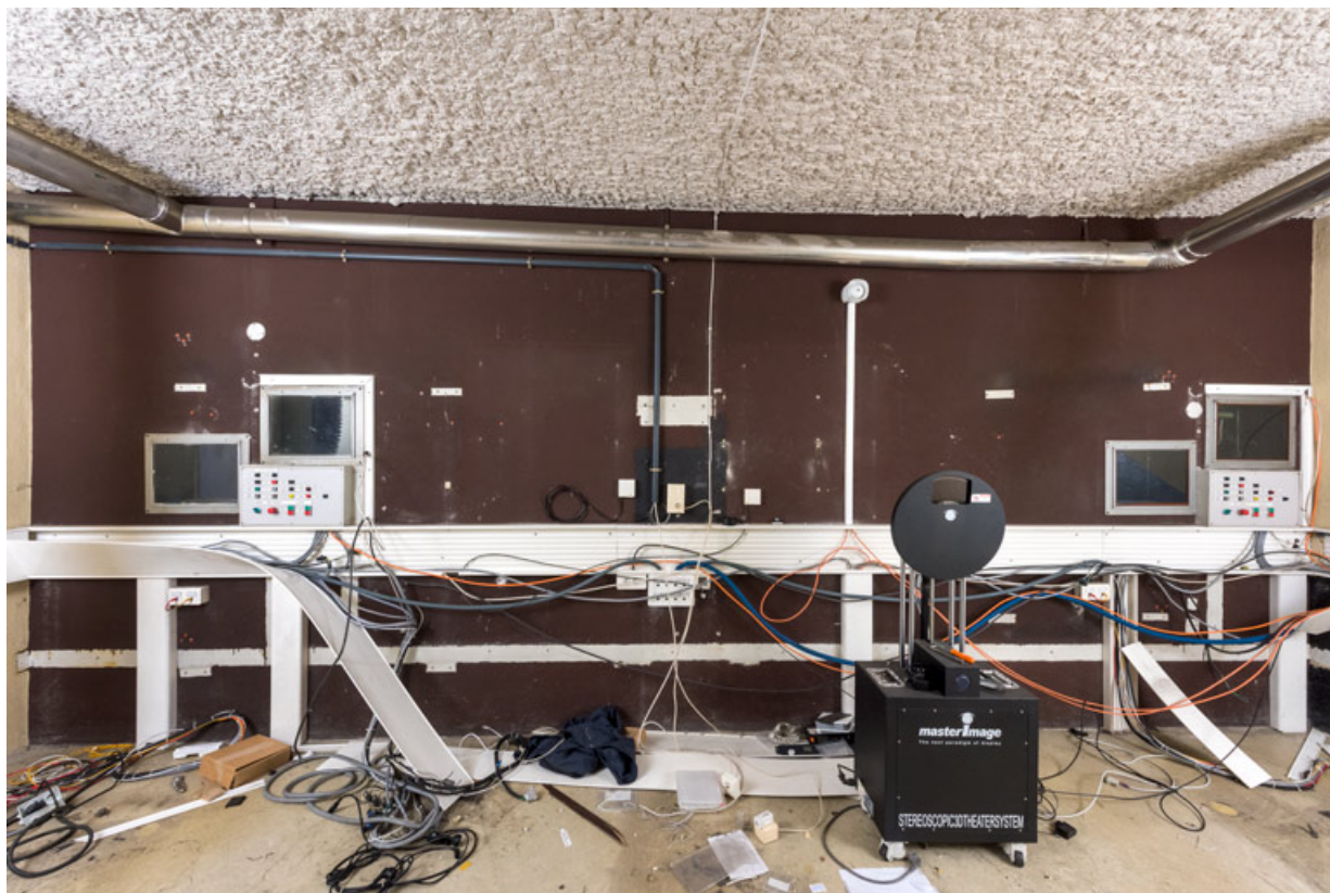
Cinéma : cabine de projection des salles 2 et 3. 71, Montceau-les-Mines, 13 rue Ferrer
