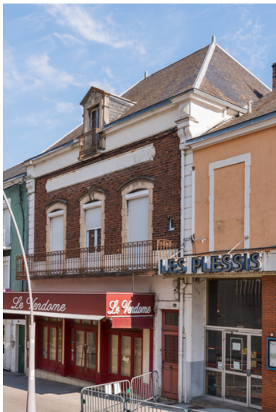
Café : façade antérieure, de trois quarts droite. 71, Montceau-les-Mines, 13 rue Ferrer
