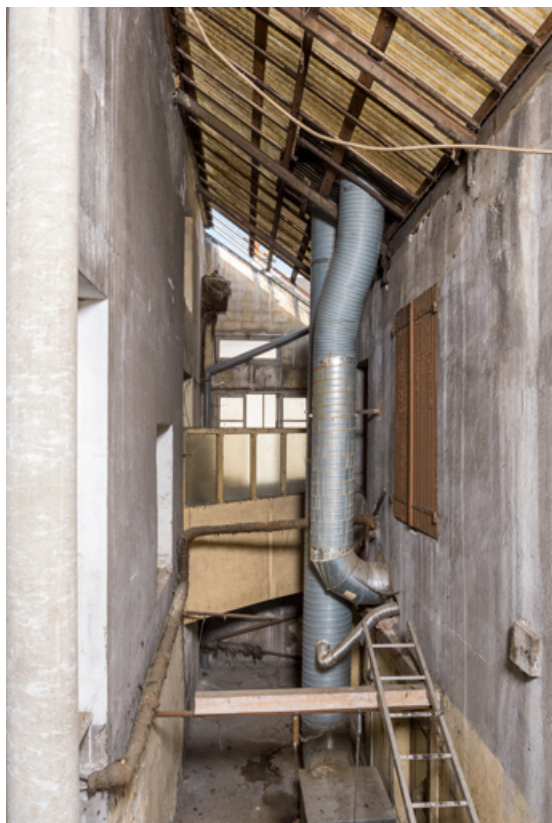
Cour couverte entre le café (à gauche) et le troisième corps de bâtiment (à droite), à usage de bureaux. 71, Montceau-les-Mines, 13 rue Ferrer
