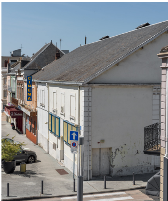
Vue d'ensemble en enfilade, depuis le pont enjambant la voie ferrée. 71, Montceau-les-Mines, 13 rue Ferrer
