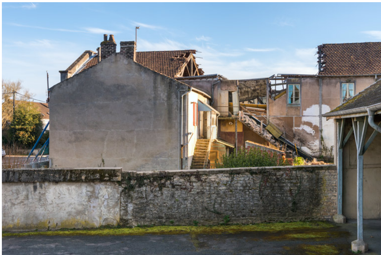
Maison et façade latérale droite du cinéma (vue rapprochée).
