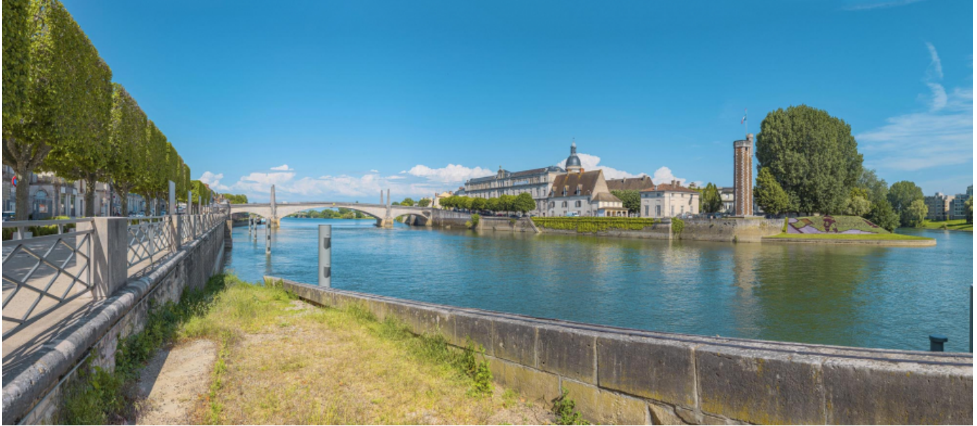
Vue d'ensemble du quai depuis la rive droite. Au premier plan, la rampe du quai des Messageries. 71, Chalon-sur-Saône, lieudit : Ile île Saint-Laurent
