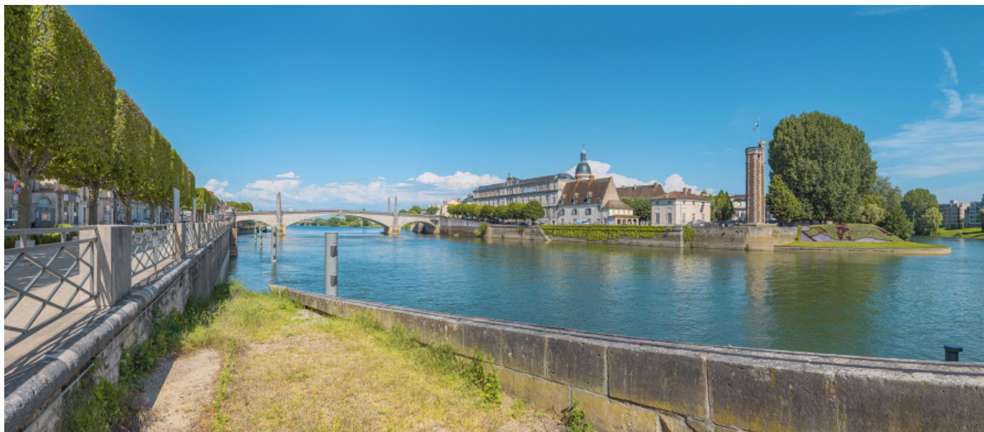
Vue d'ensemble du quai depuis la rive droite. Au premier plan, la rampe du quai des Messageries. 71, Chalon-sur-Saône, lieudit : Ile île Saint-Laurent
