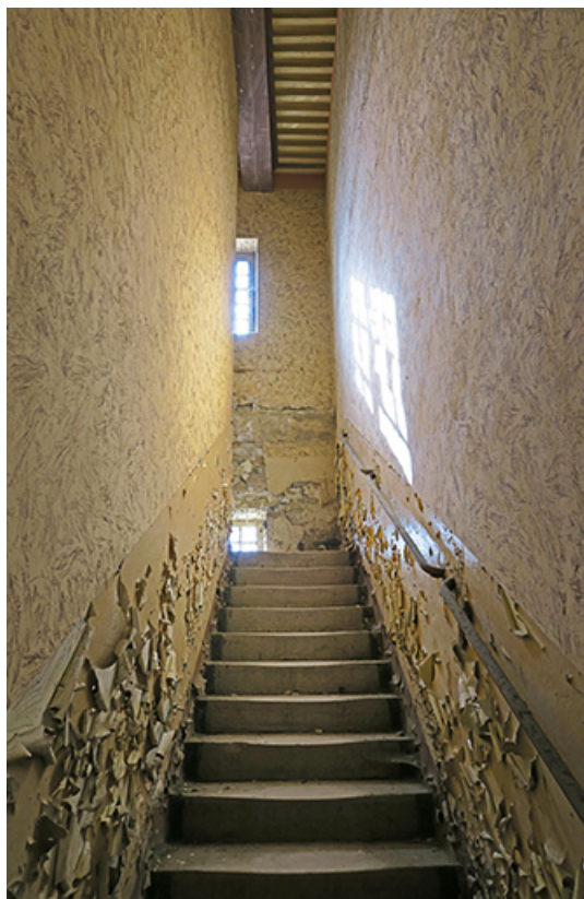
Première volée de l'escalier nord des prisonniers.
