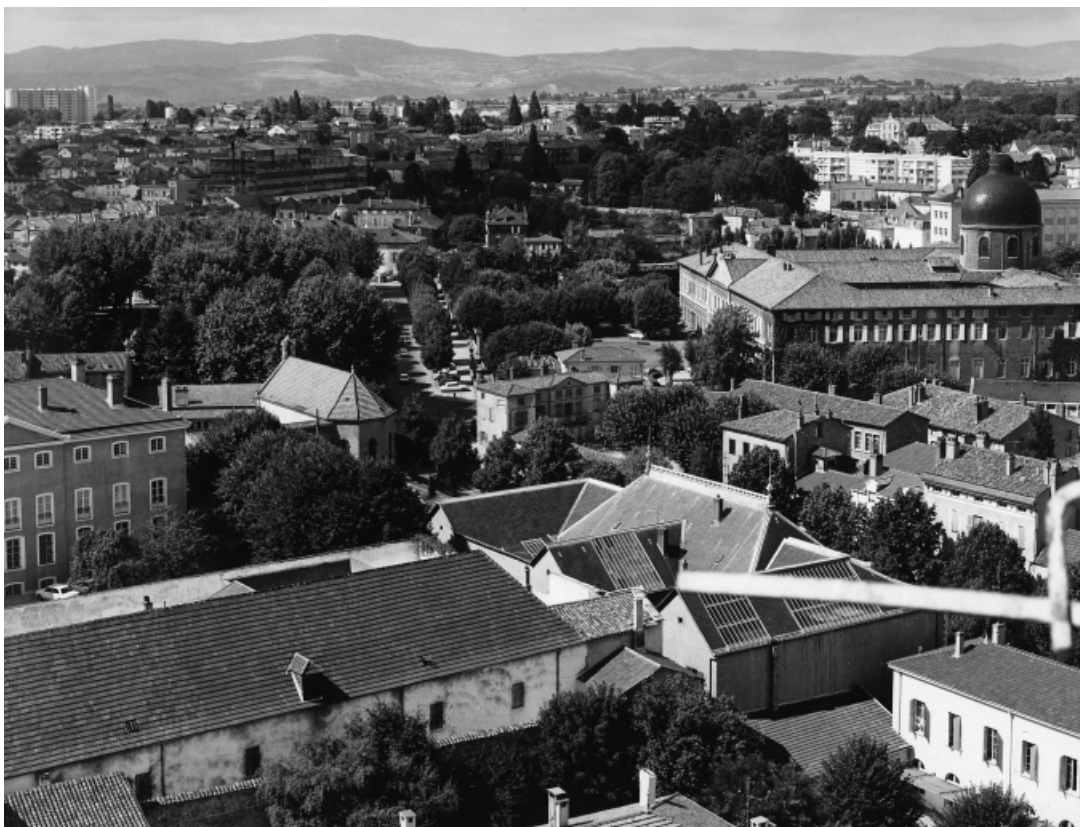
Vue aérienne de la façade postérieure de la prison (en bas à gauche). 71, Mâcon, 8 rue de la Préfecture
