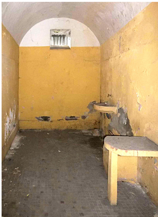
Rez-de-chaussée, cellule de sûreté nord.
