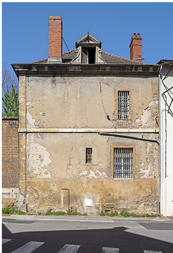
Pignon sud vu depuis la place des Carmélites.
