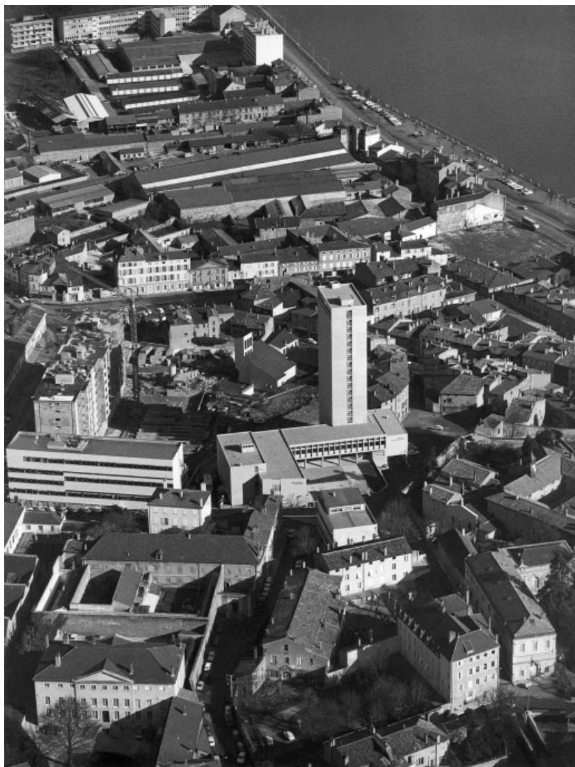
Vue aérienne de la prison avec les constructions de la cour démolies après 1990. 71, Mâcon, 8 rue de la Préfecture
