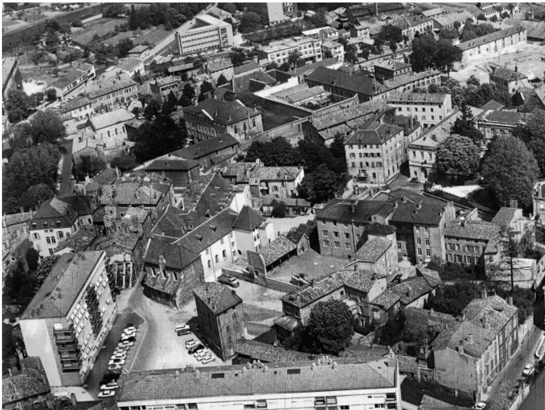
Vue aérienne du tribunal et de la prison de Mâcon (en haut). 71, Mâcon, 8 rue de la Préfecture
