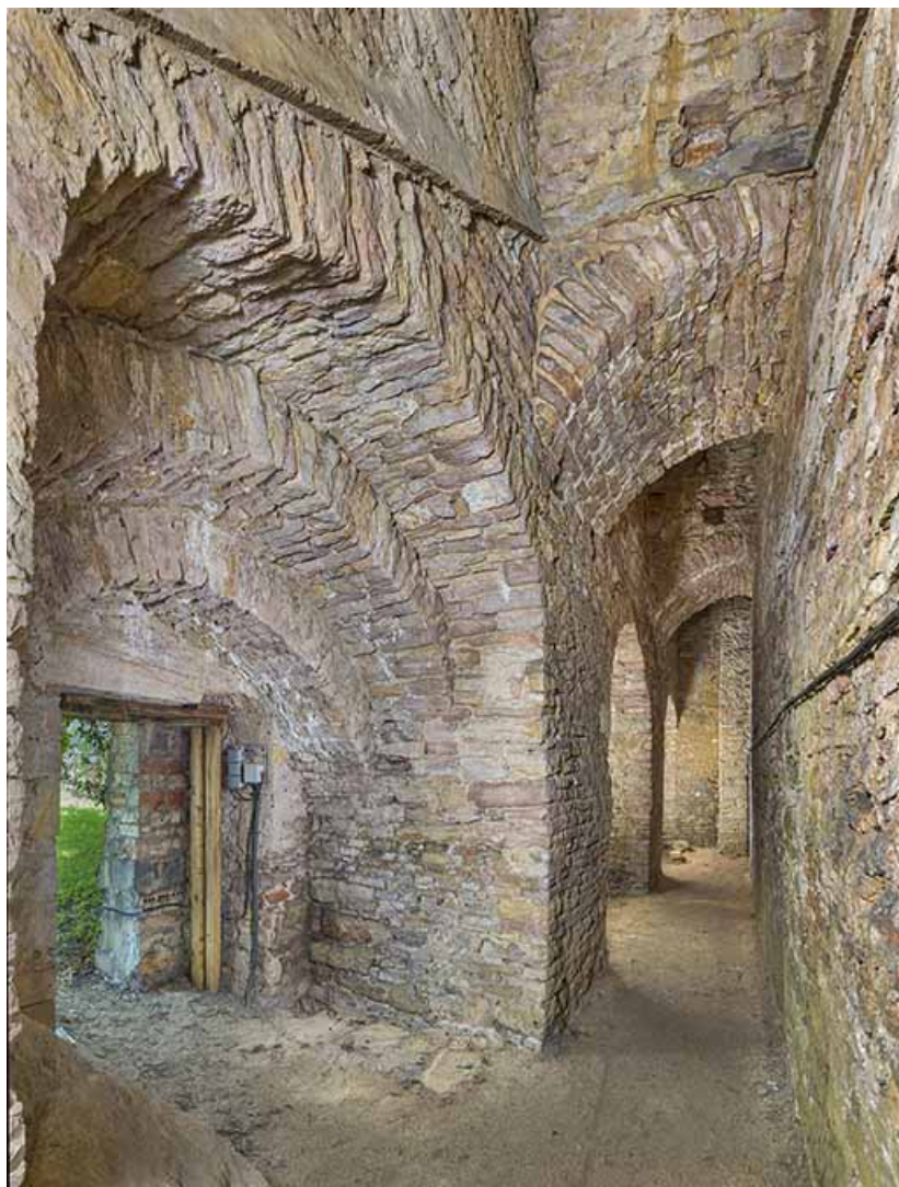
Poterne d'accès à la galerie.
