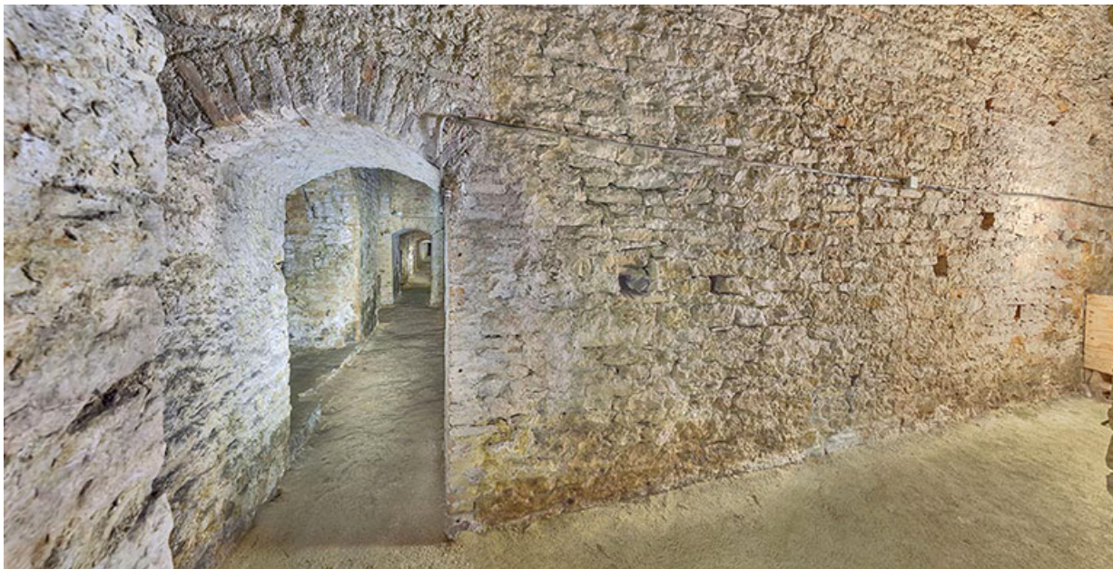
La galerie au niveau de l'angle du flanc et de la face.
