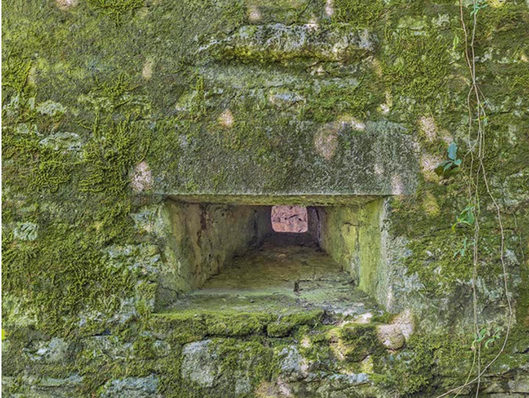
Vue extérieure d'une embrasure de tir de la galerie d'escarpe.
