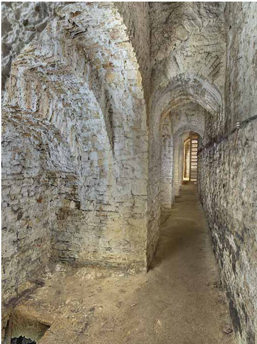
La galerie et sur la gauche, une casemate. 71, Chalon-sur-Saône rue Professeur Leriche
