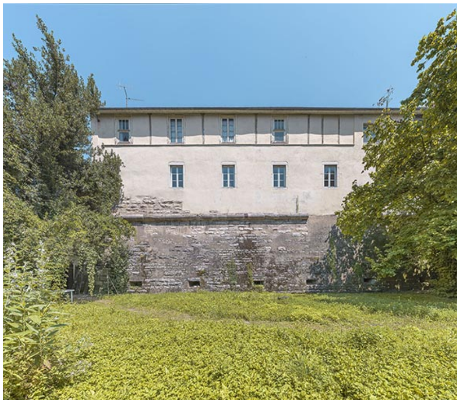
Flanc ouest du bastion et les embrasures de la galerie d'escarpe.
