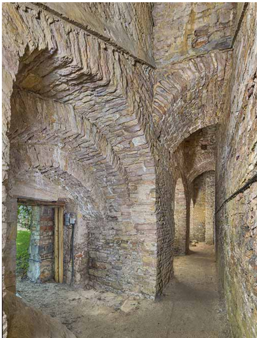
Poterne d'accès à la galerie.
