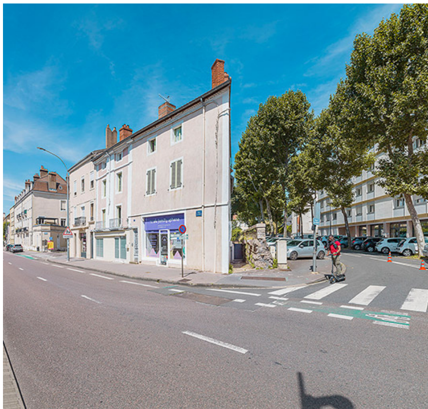
Avenue de Paris, perçant l'ancienne courtine Saint-Pierre.
