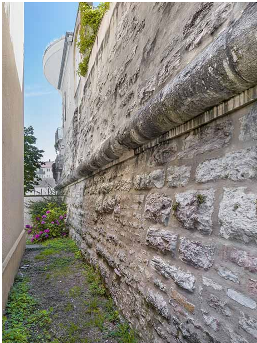
Mur d'une des faces du bastion Saint-Pierre.
