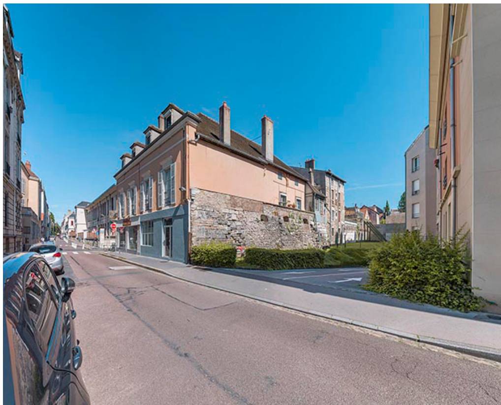
Portion du rempart et ancienne porte murée, rue de Thiard. 71, Chalon-sur-Saône
