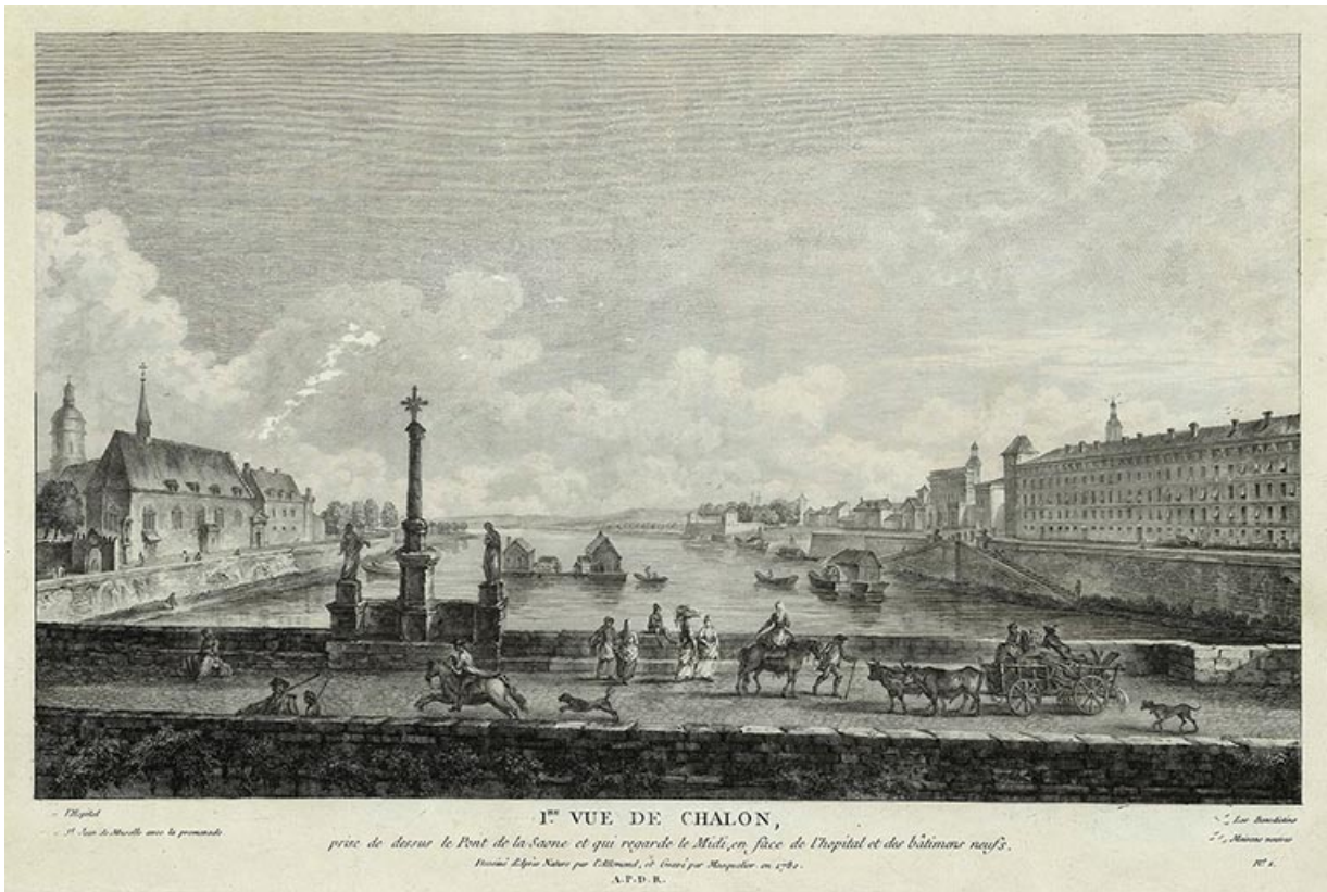
Chalon-sur-Saône.- Première vue prise de dessus le pont de la Saône et qui regarde le midi, en face de l'hôpital et des bâtiments neufs. 1780.
