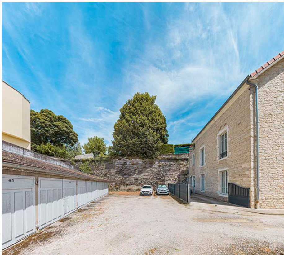
Portion du bastion Saint-Paul.
