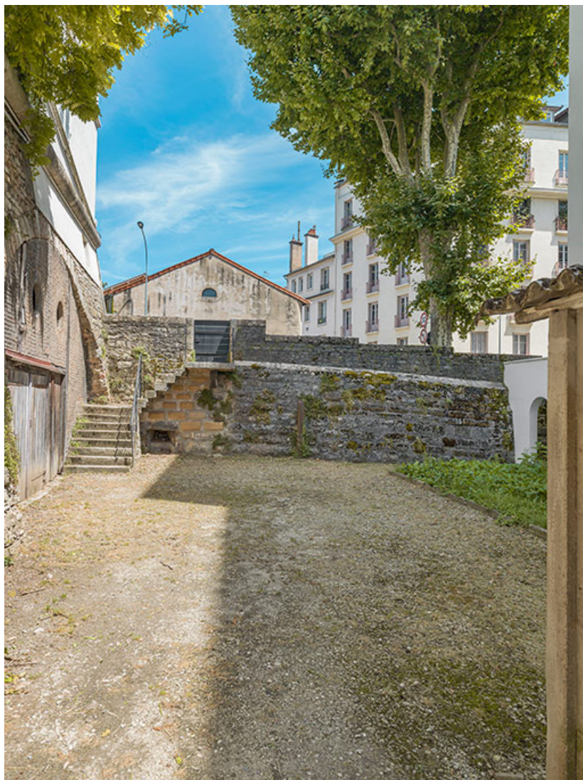
Raccord entre la courtine et le flanc sud du bastion Saint-Paul, rempart Saint-Pierre. 71, Chalon-sur-Saône
