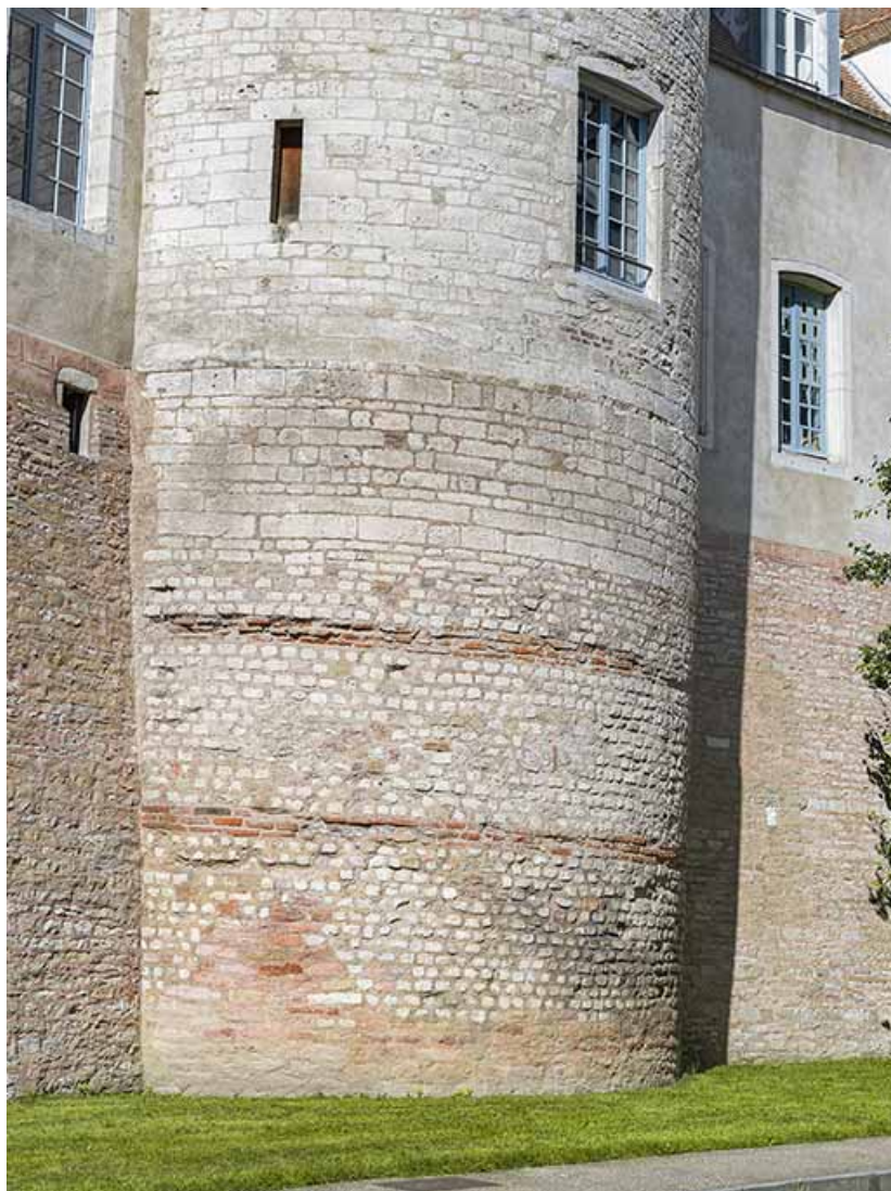
Détail de la maçonnerie, tour de l'Evêché. 71, Chalon-sur-Saône
