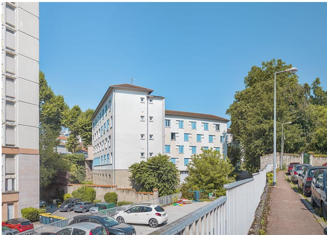
Immeubles construits dans l'ancien fossé aux remparts Saint-Vincent. 71, Chalon-sur-Saône
