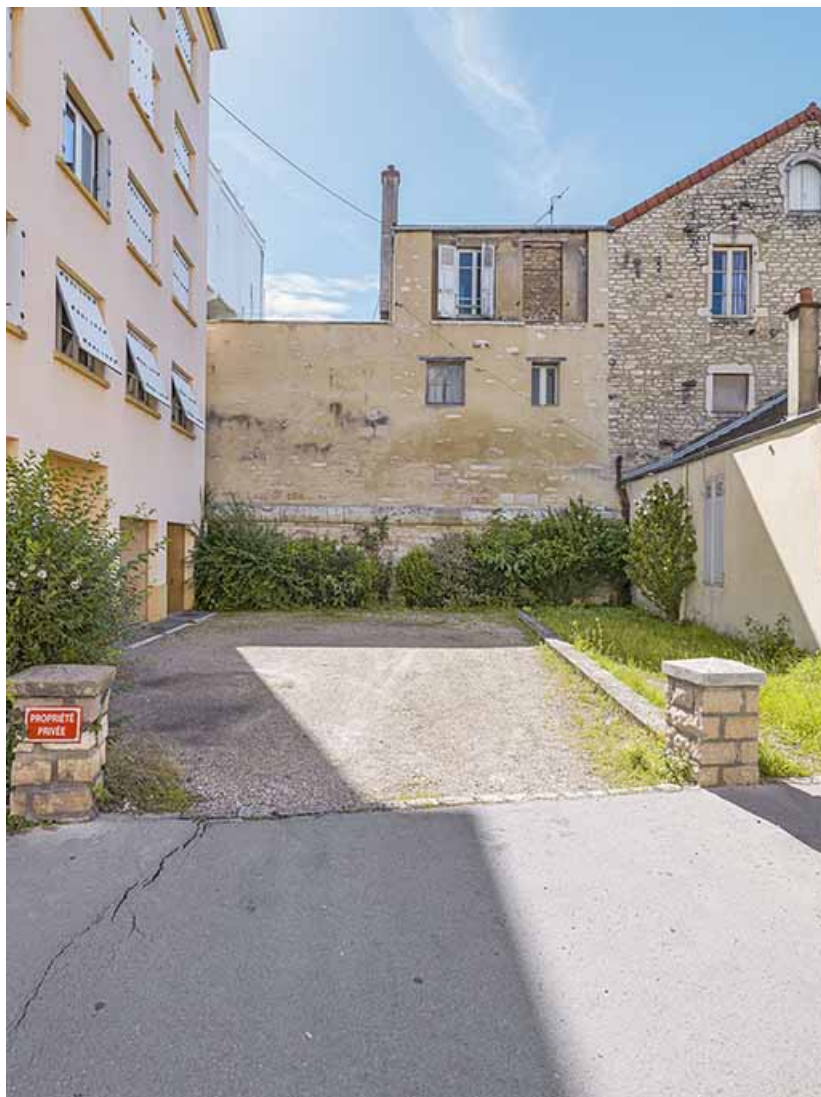
Mur d'une des faces du bastion Saint-Pierre, rue Professeur Leriche. 71, Chalon-sur-Saône
