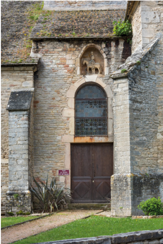
Situation de la statue, dans une niche au-dessus d'une baie (flanc nord).
