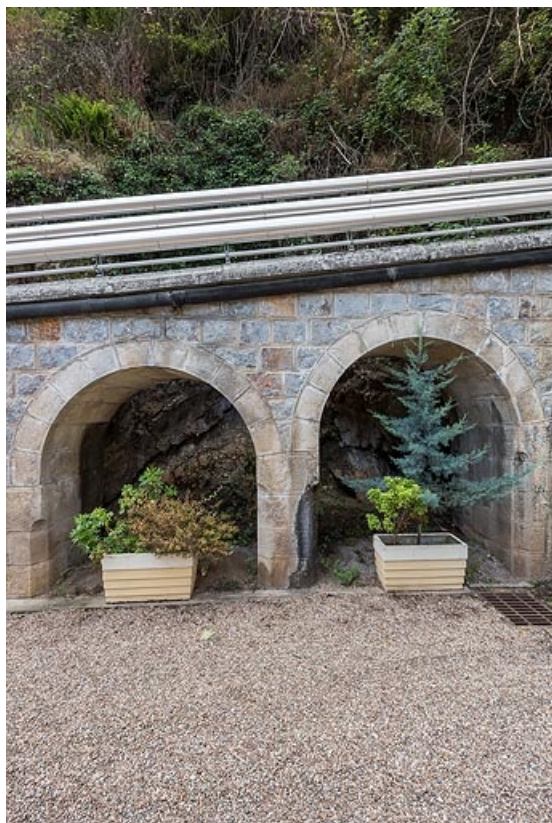
Aqueduc, détail de deux arcades contre le rocher.
