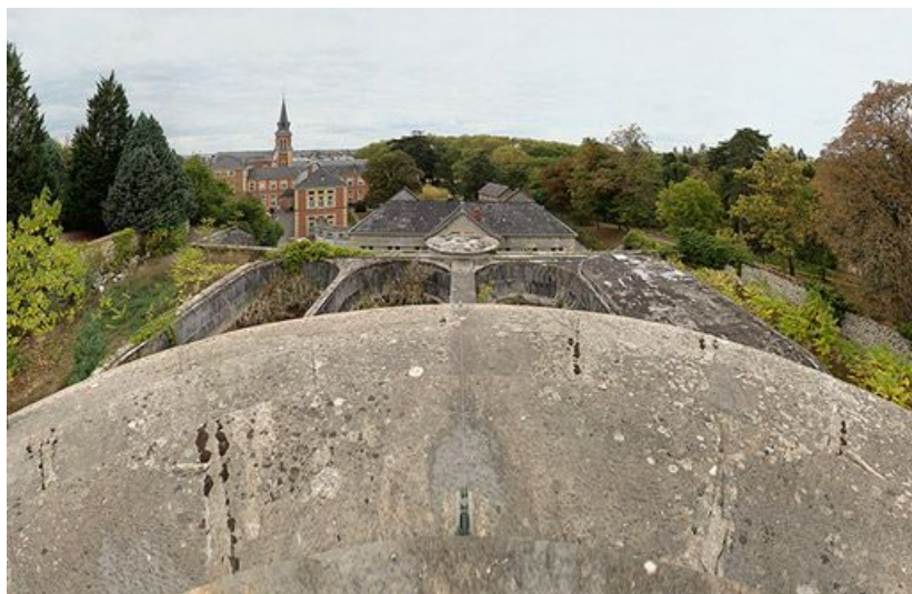
Vue d'ensemble de l'hôpital avec le dessus du château d'eau et les réservoirs au premier plan. 71, Bourbon-Lancy rue de la Chaumière
