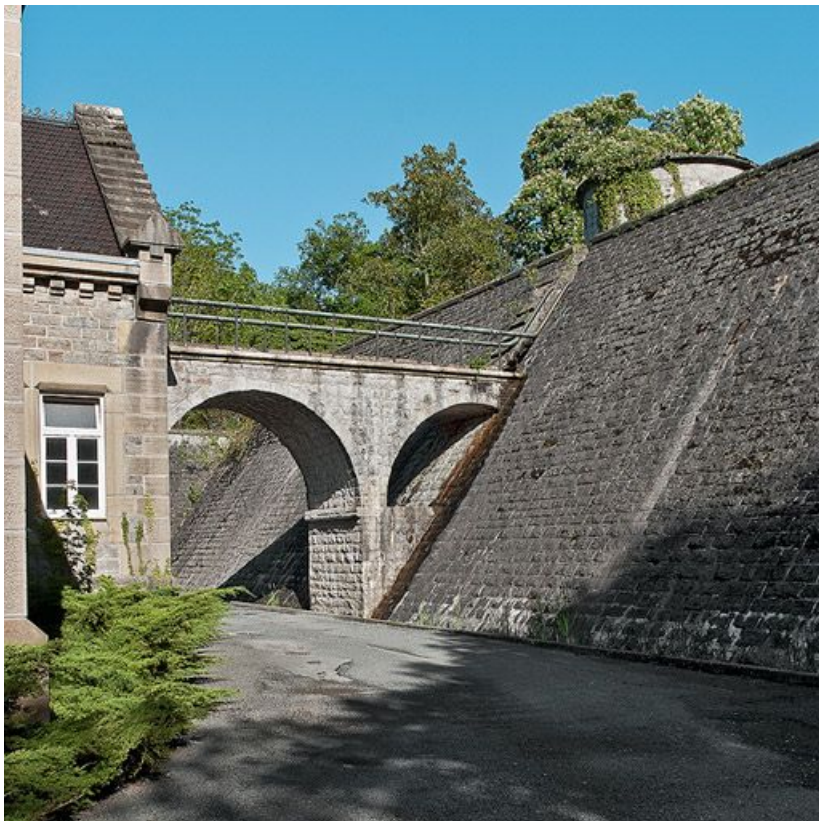
Pont-aqueduc et mur de soutènement.
