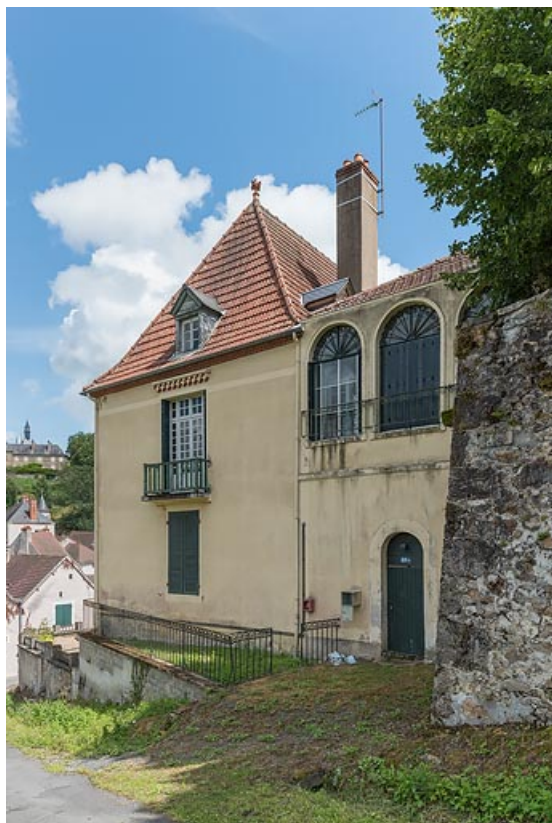
Vue depuis la rue de La Roche.
