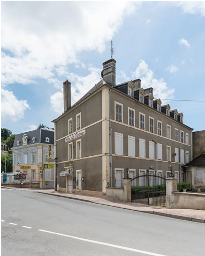
Façade est et façade nord.
