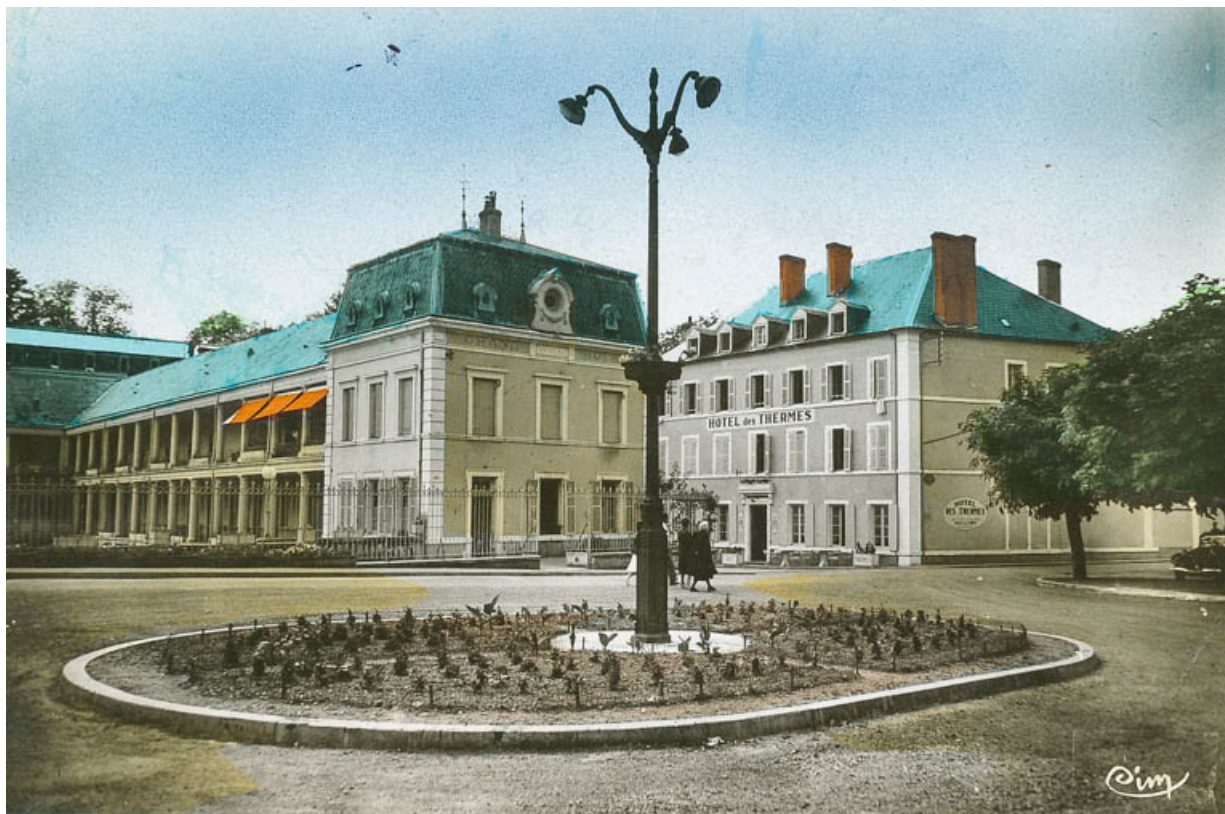
Situation de l'hôtel des Thermes (à droite), près de l'établissement thermal (à gauche).
