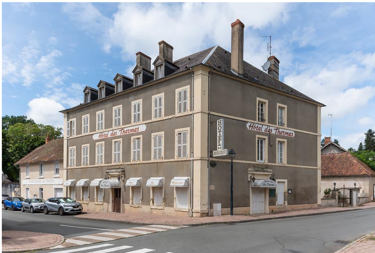
Façade sud et façade est.
