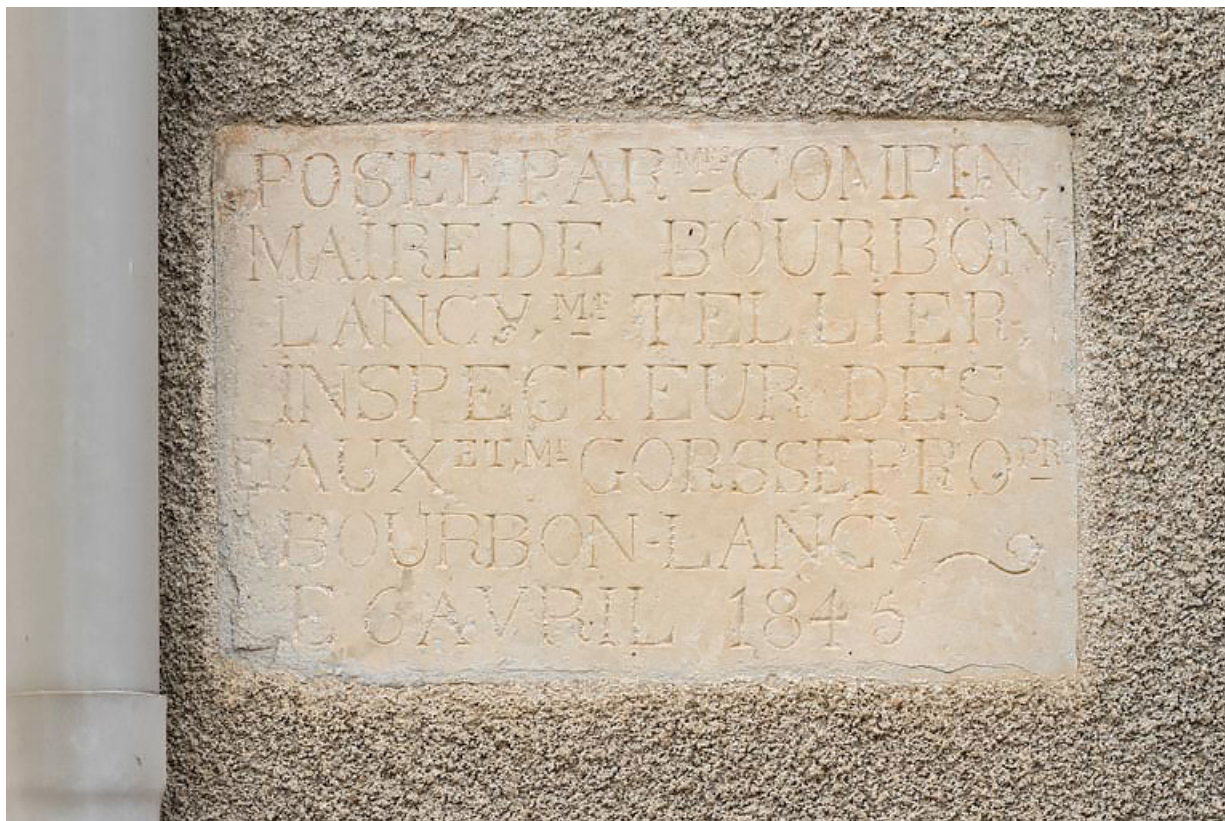
Inscription relative à la construction de l'édifice, 6 avril 1845.
