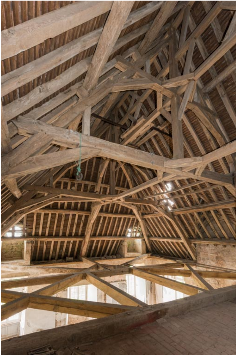
Charpente à chevrons portant-fermes, croupe sud-ouest, vue depuis l'étage de comble.
