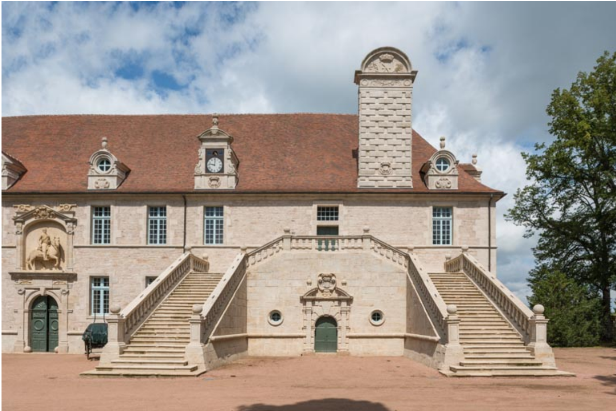
Façade sud-est, partie droite, grand-degré.
