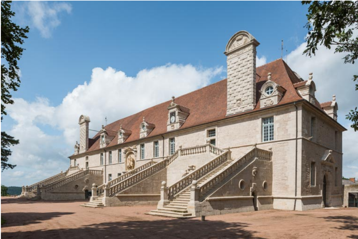
Façade sud-est, vue d'ensemble depuis l'est.
