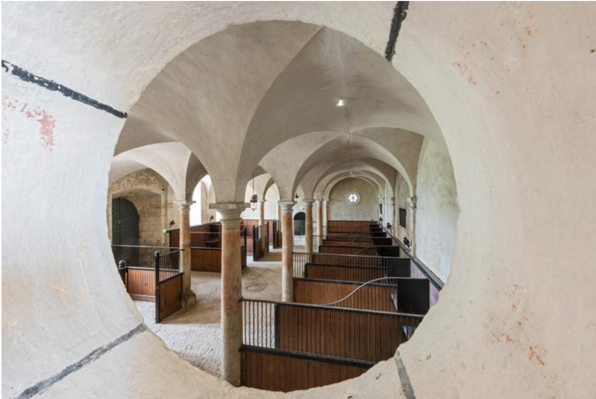
Pièce entresolée entre la salle centrale et la salle nord-est, oculus avec vue sur la salle centrale.
