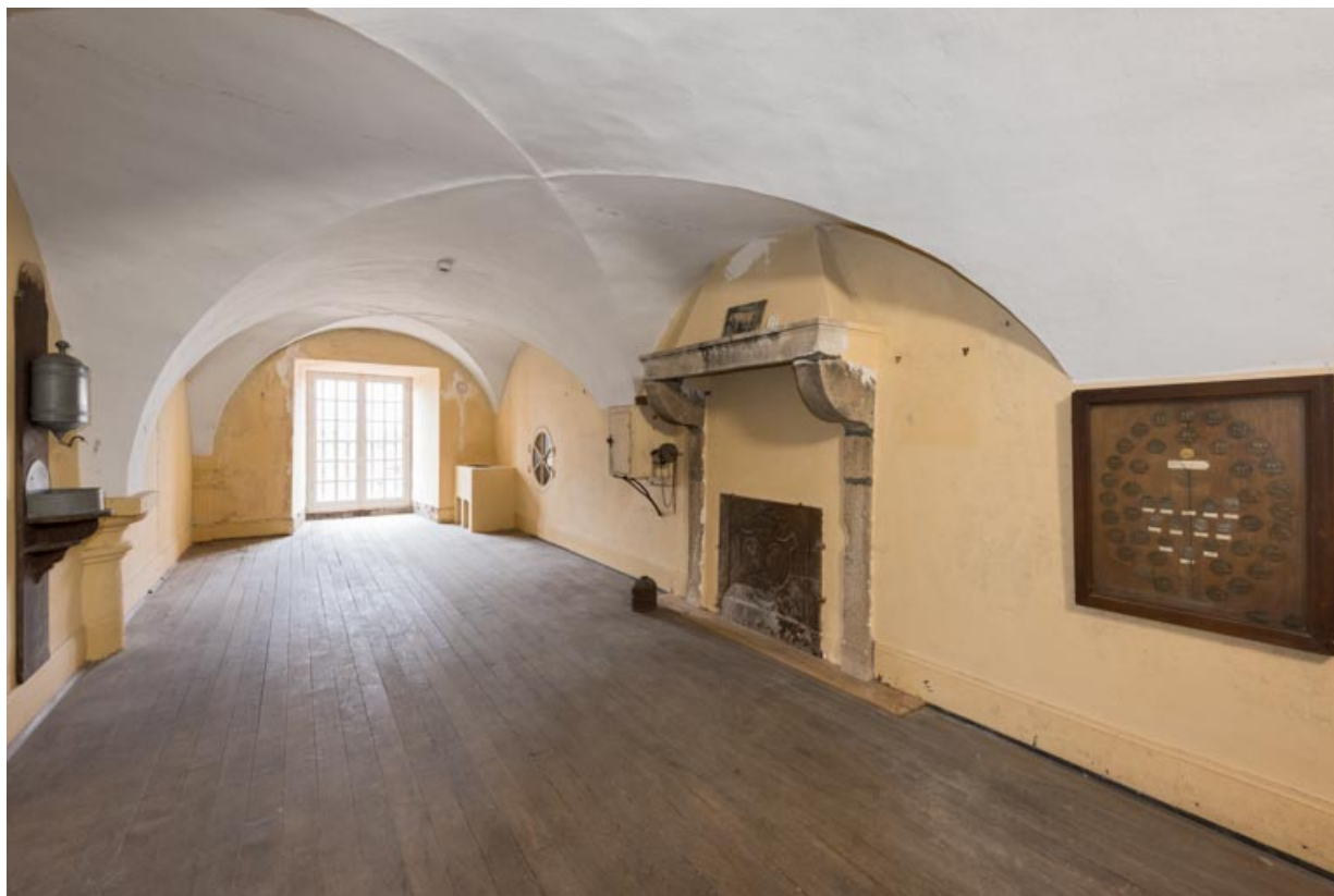
Pièce entresolée entre la salle centrale et la salle nord-est.
