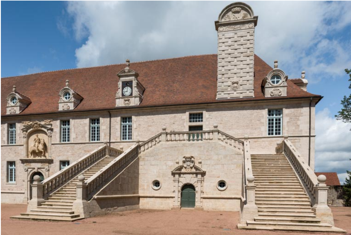
Façade sud-est, partie droite, grand-degré.
