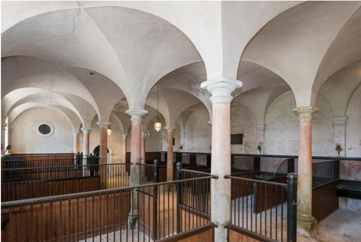
Rez-de-chaussée, salle centrale, vue en direction de l'ouest.
