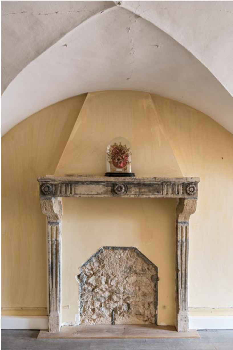
Pièce entresolée entre la salle centrale et la salle nord-est, cheminée factice (?). 71, Saint-Bonnet-de-Joux chemin du Bois de Chaumont, lieudit : Château de Chaumont
