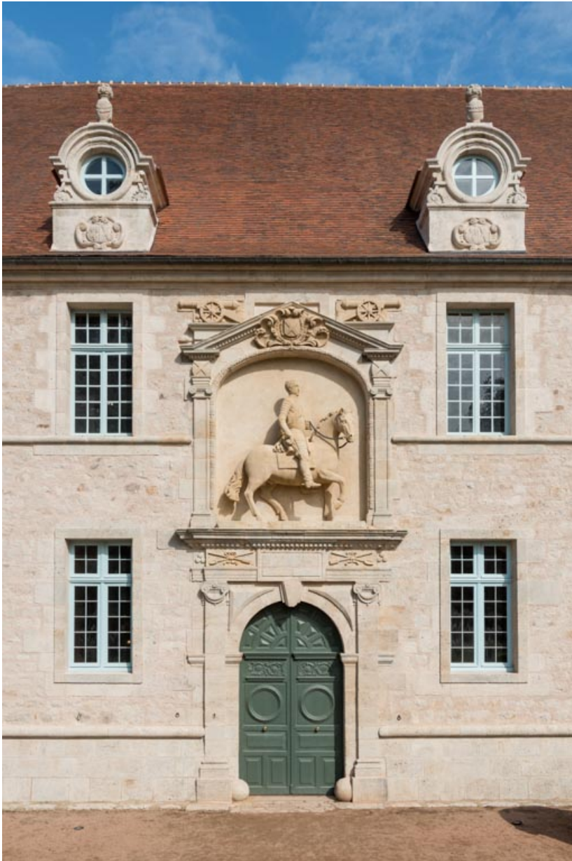
Travée centrale de la façade sud-est, vue après restauration.
