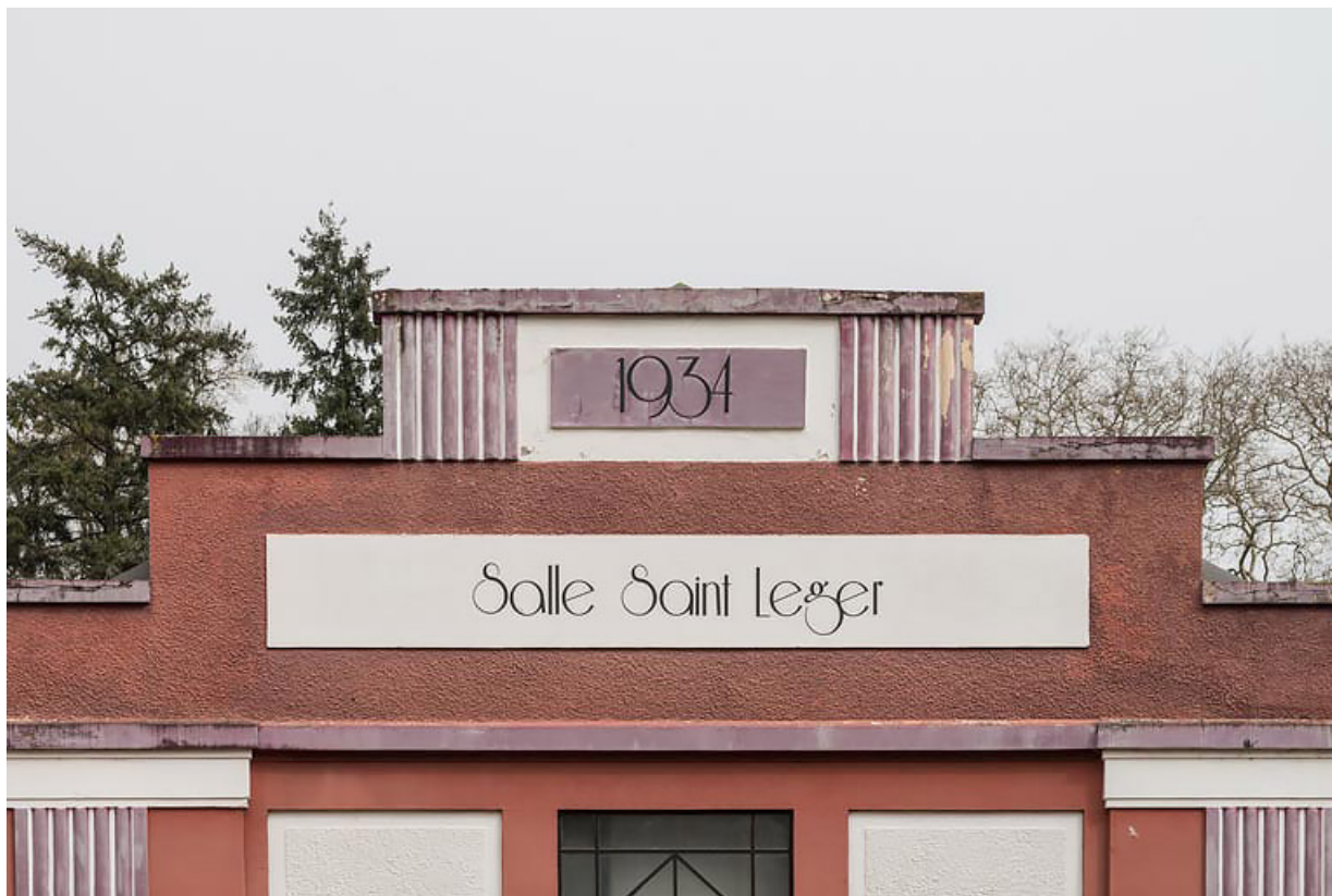
Façade, détail ("Salle Saint-Léger 1934"). 71, Bourbon-Lancy, 2 Parc thermal
