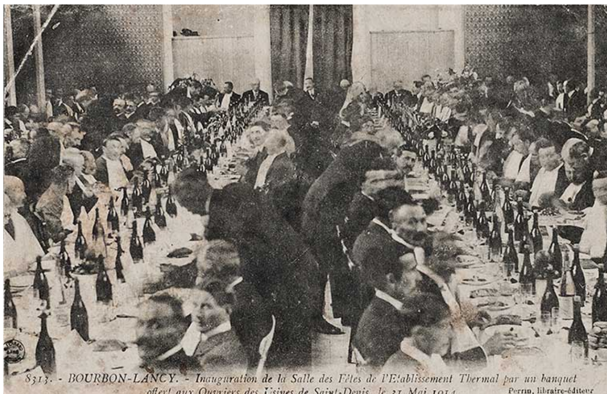
Salle des fêtes, vue intérieure (1914).
