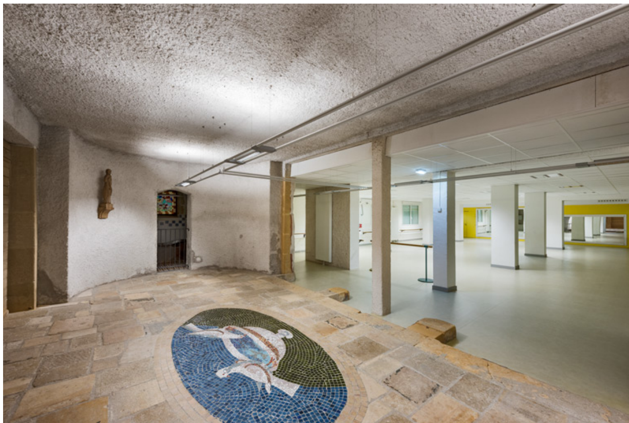
Niveau de l'ancienne piscine, sous-sol de la salle de spectacle actuelle (salle des associations).
