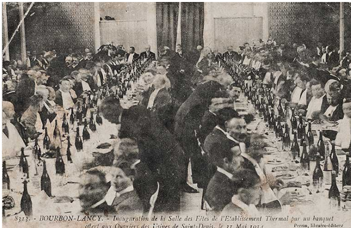
Salle des fêtes, vue intérieure (1914).
